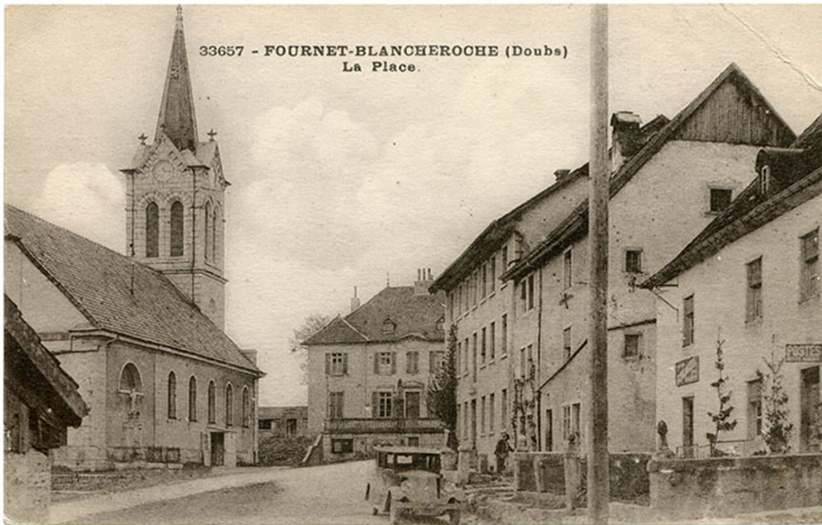
33657 - Fournet-Blancheroche (Doubs). La Place [vue d'ensemble de trois quarts droite], 1ère moitié 20e siècle [avant 1938]. 25, Fournet-Blancheroche, 6 place François Joubert
