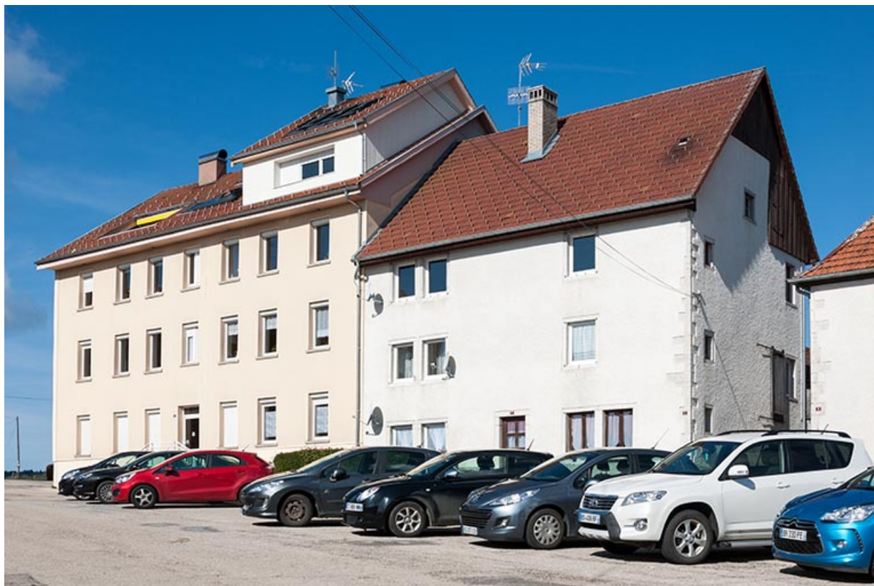
Vue d'ensemble, de trois quarts droite (la "Grande Maison" est à gauche).
