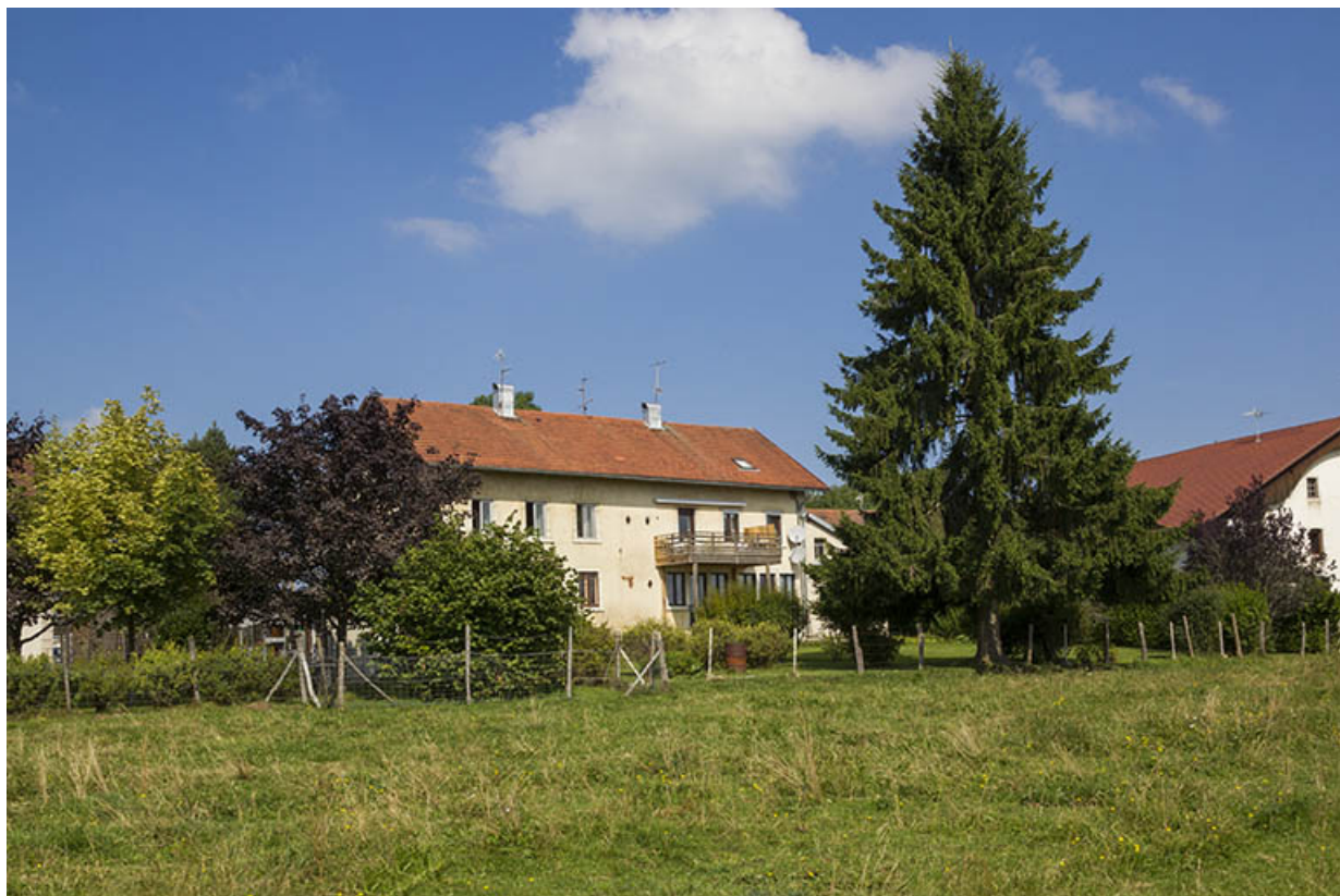
Vue d'ensemble, depuis l'est (façade postérieure).
