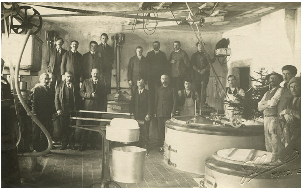
Les Écorces : inauguration de la fromagerie en 1929 [vue intérieure]. 25, Les Écorces, 2 rue des Vies
