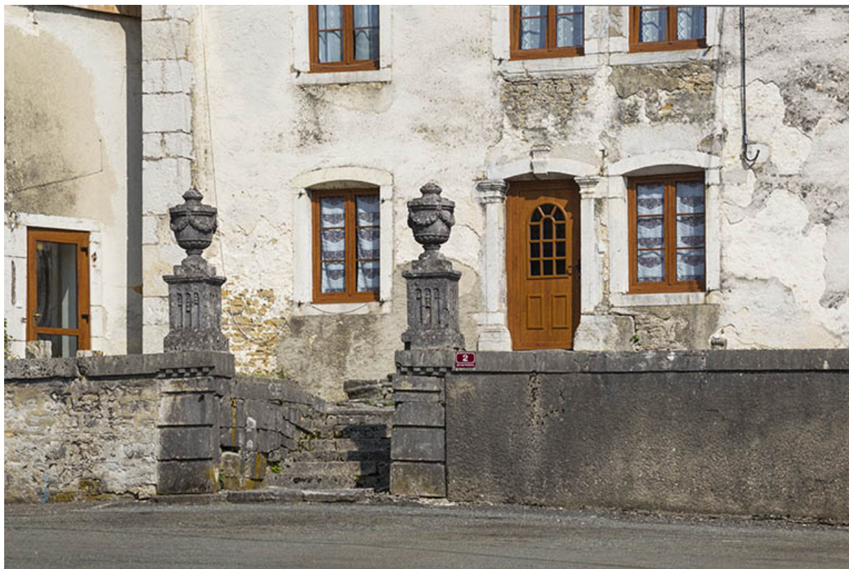
Terrasse surélevée : escalier encadré par deux vases d'amortissement. 25, Tréviillers, 2-6 rue des Fontaines
