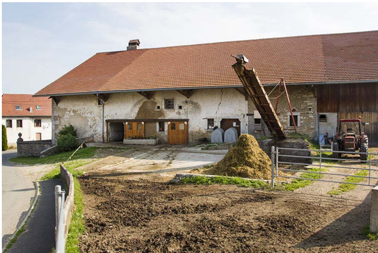
Ferme : façade latérale droite.
