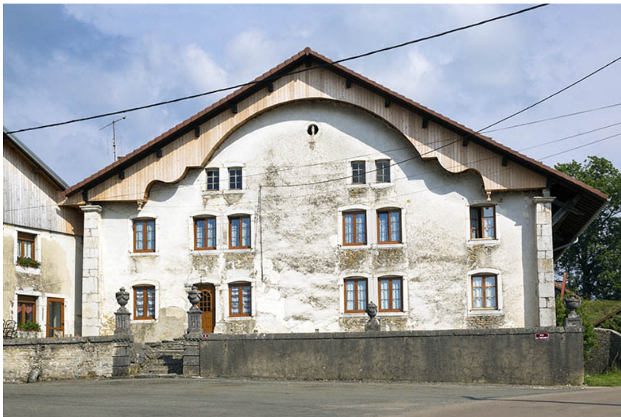
Ferme : façade antérieure.
