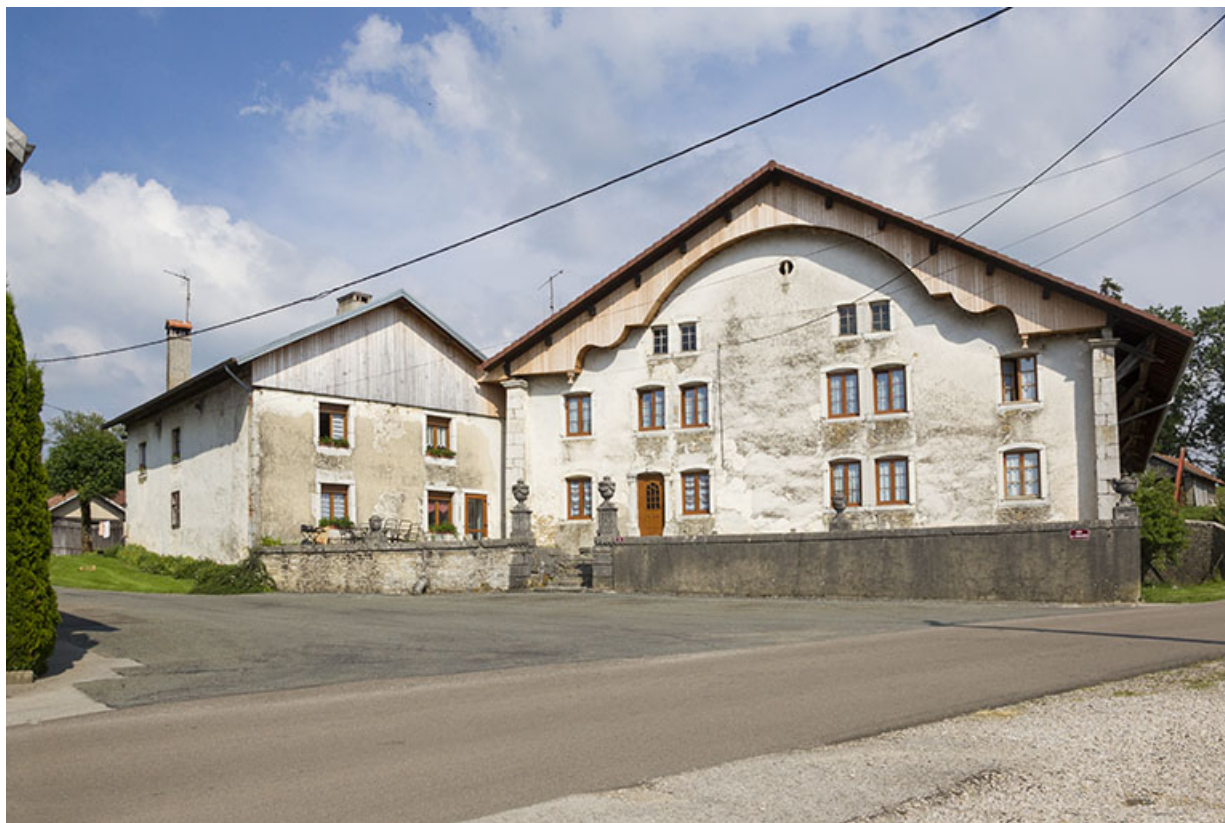
Vue d'ensemble, depuis l'ouest.
