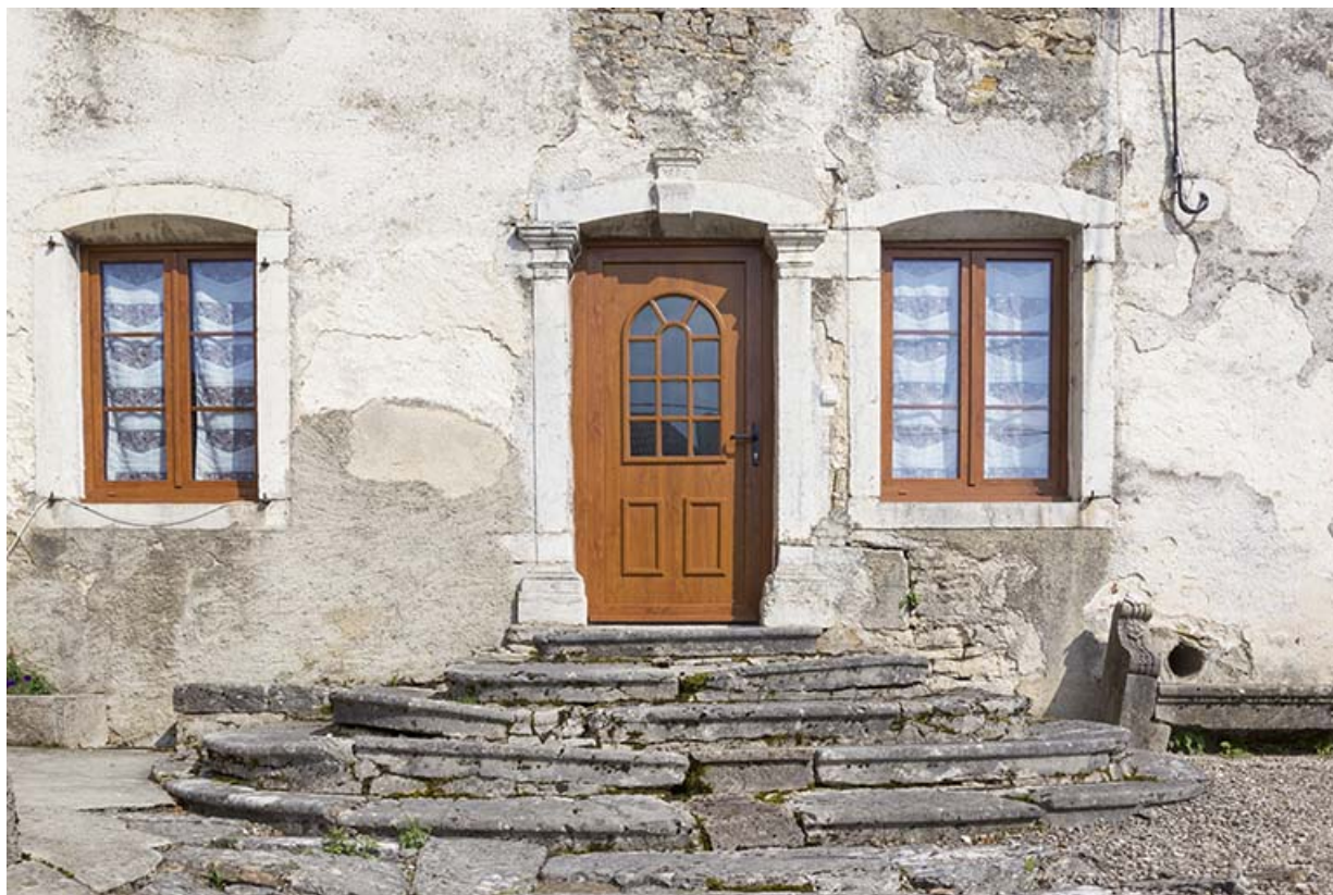
Ferme : perron et entrée sur la façade antérieure.
