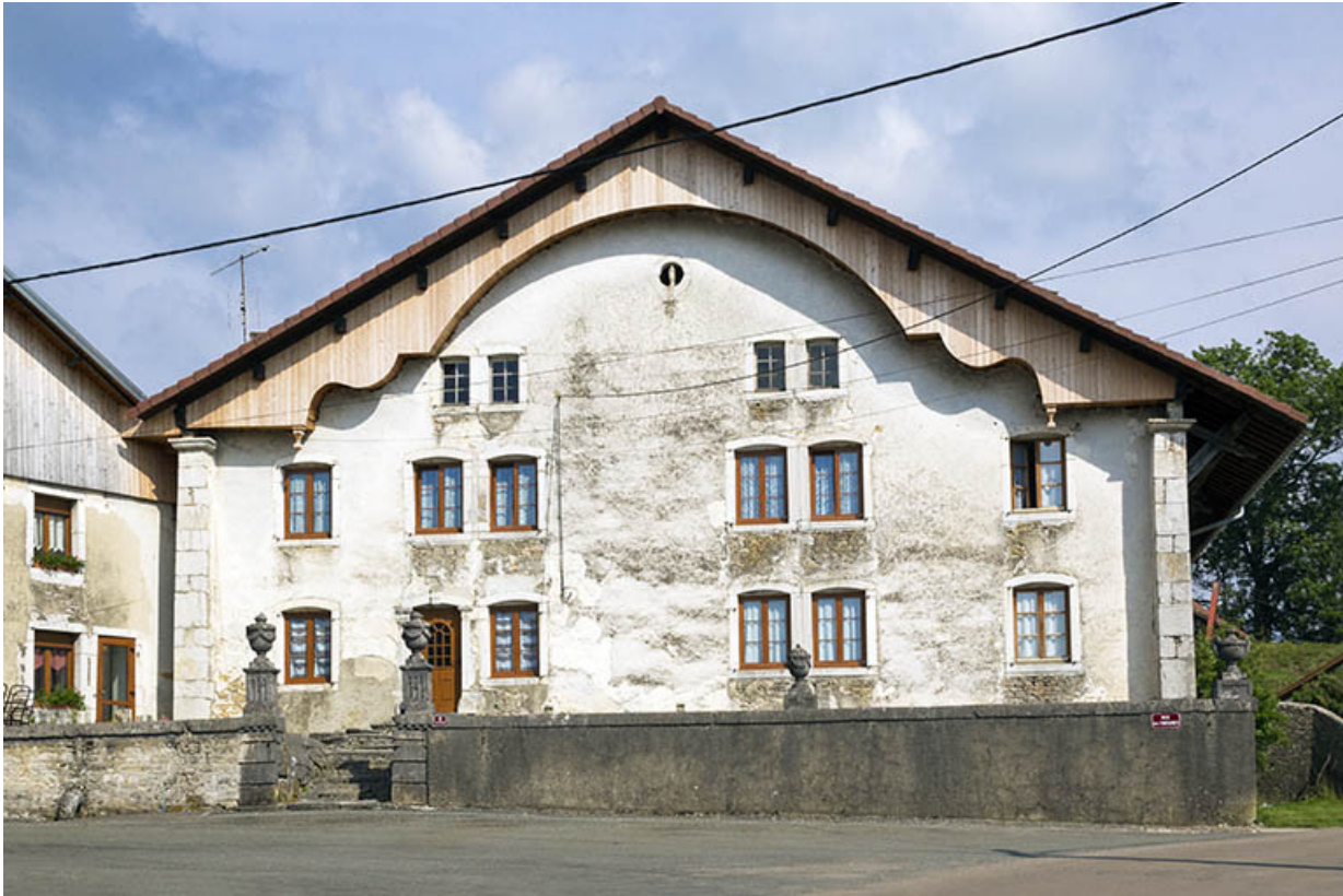
Ferme : façade antérieure.
