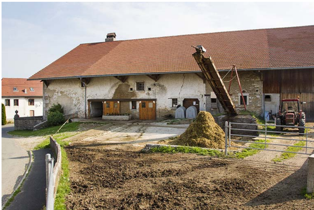
Ferme : façade latérale droite.
