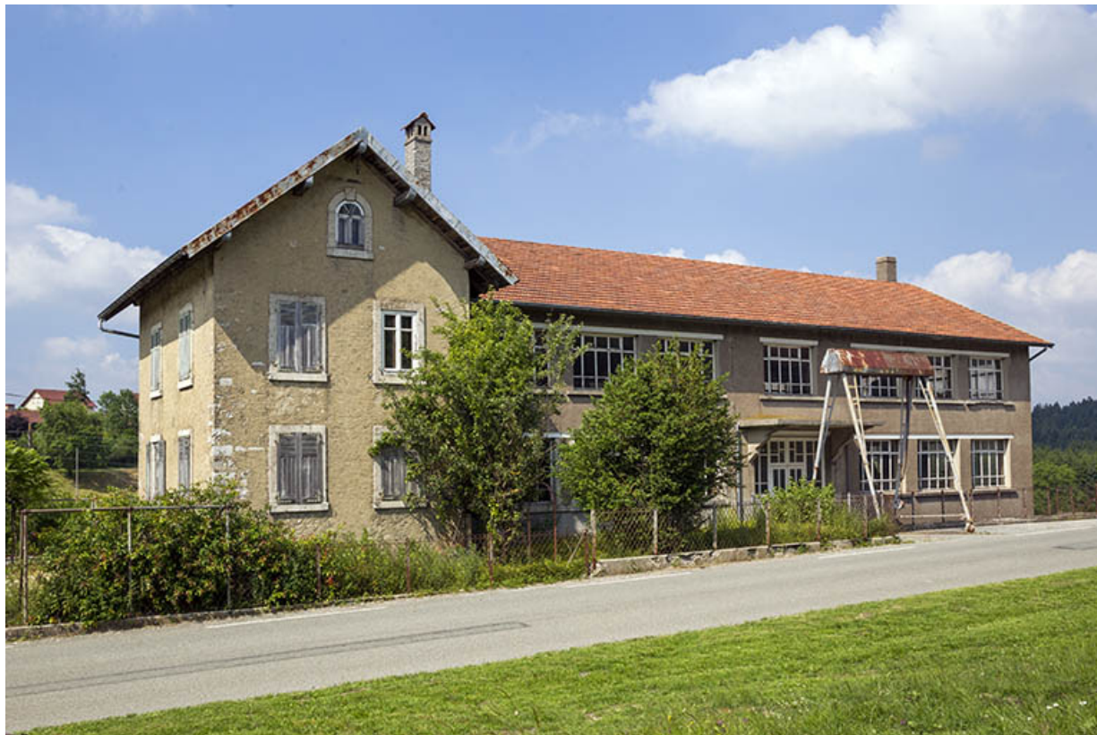
Site rue du Jura : logement, atelier de fabrication et portique (façade antérieure de trois quarts gauche). 25, Trévillers, 11 rue du Jura
