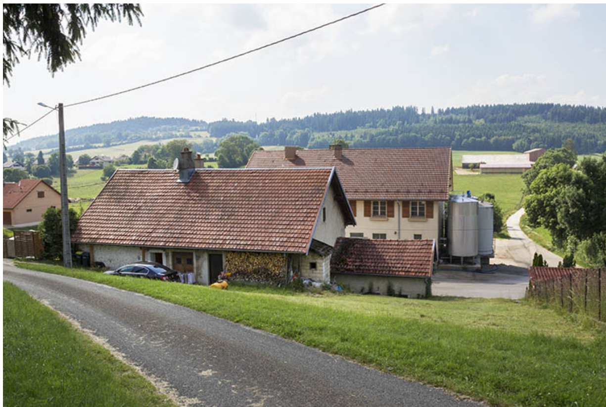
Ancienne fromagerie : façade postérieure (vue du nord-est).
