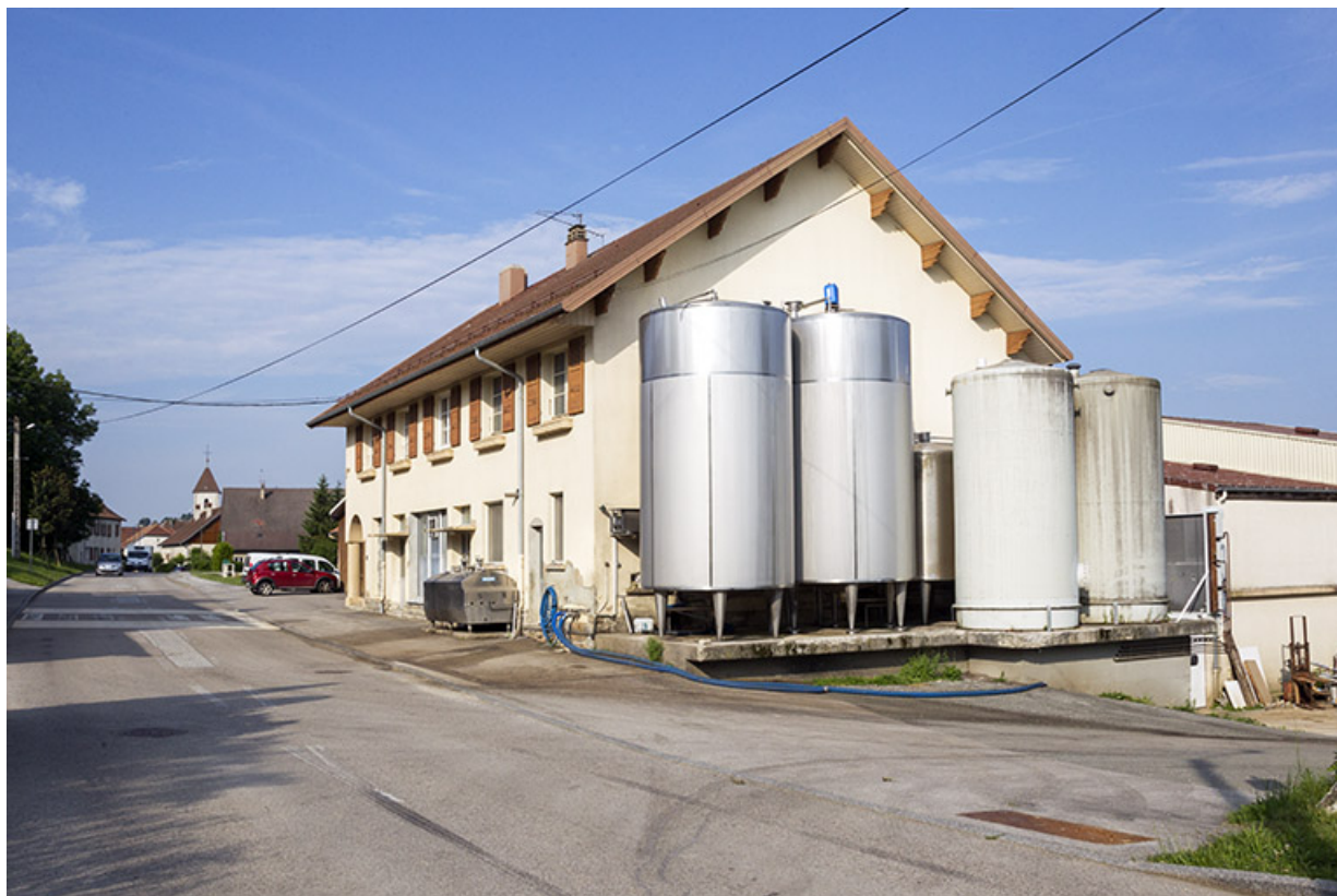
Nouvelle fromagerie : façade antérieure, de trois quarts droite.
