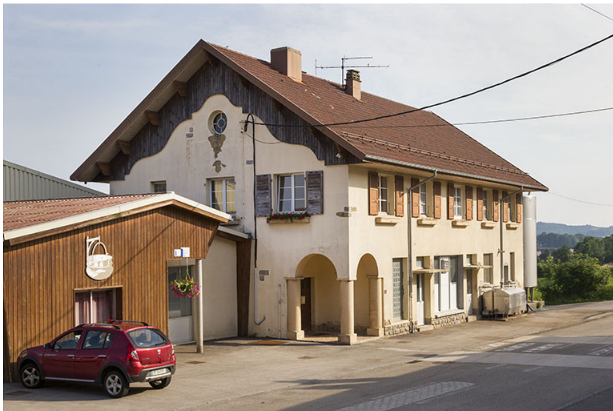
Nouvelle fromagerie : façade antérieure, de trois quarts gauche.
