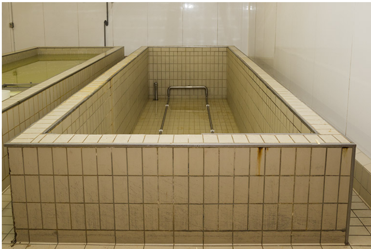
L'une des deux cuves à saumure.
