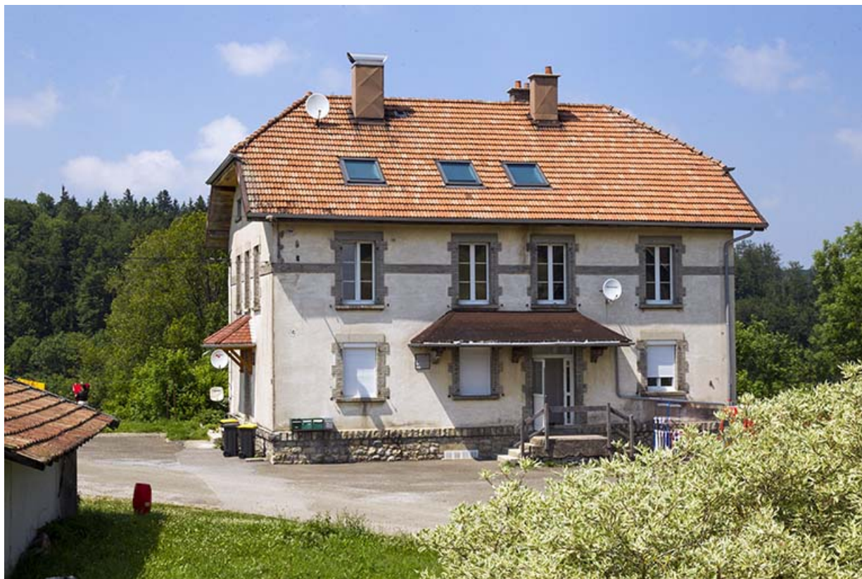
Façade latérale droite, de trois quarts gauche.
