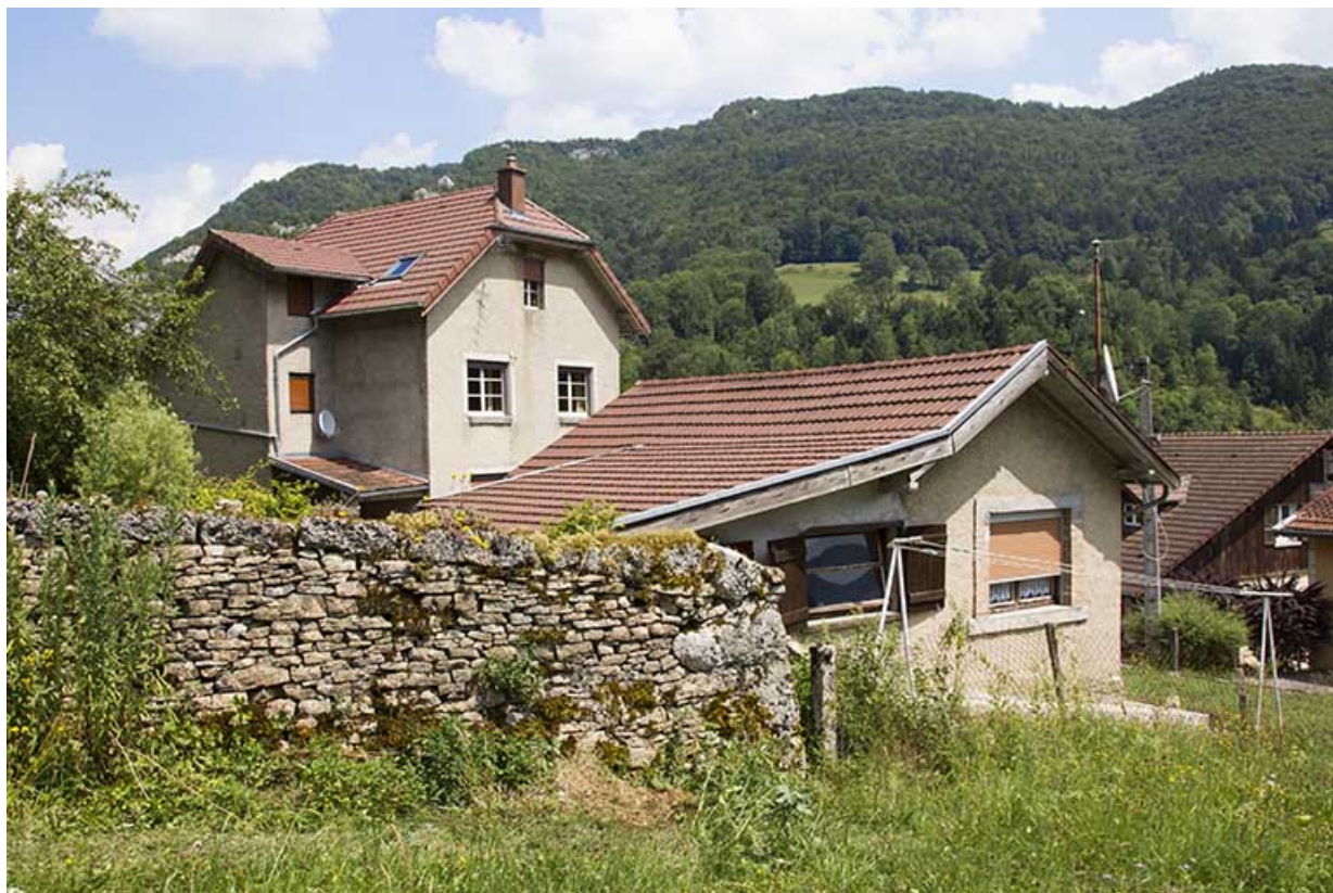
Atelier de fabrication et logement, depuis l'ouest.
