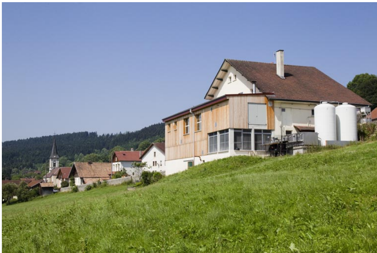
Vue d'ensemble depuis la prairie, au sud-est.
