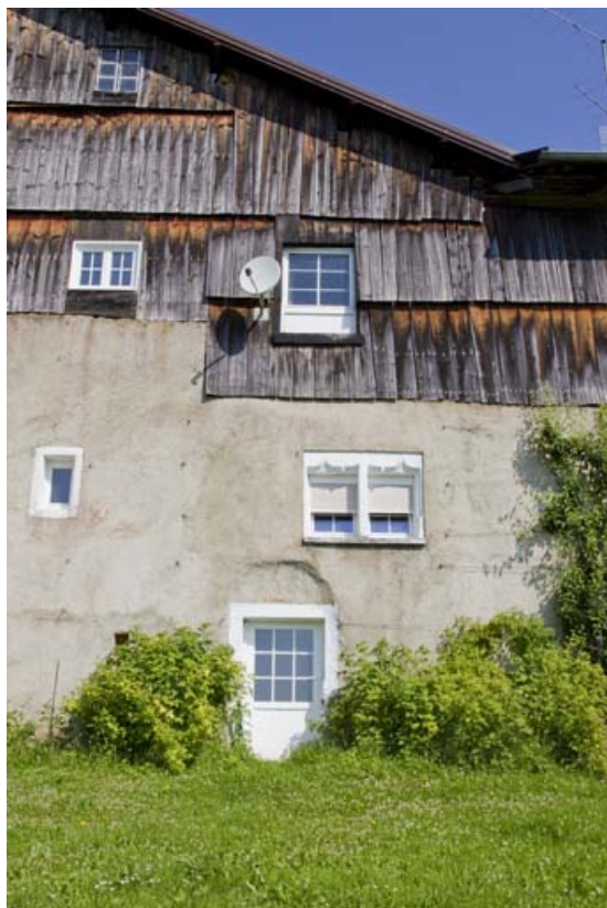
Façade latérale droite : baies.
