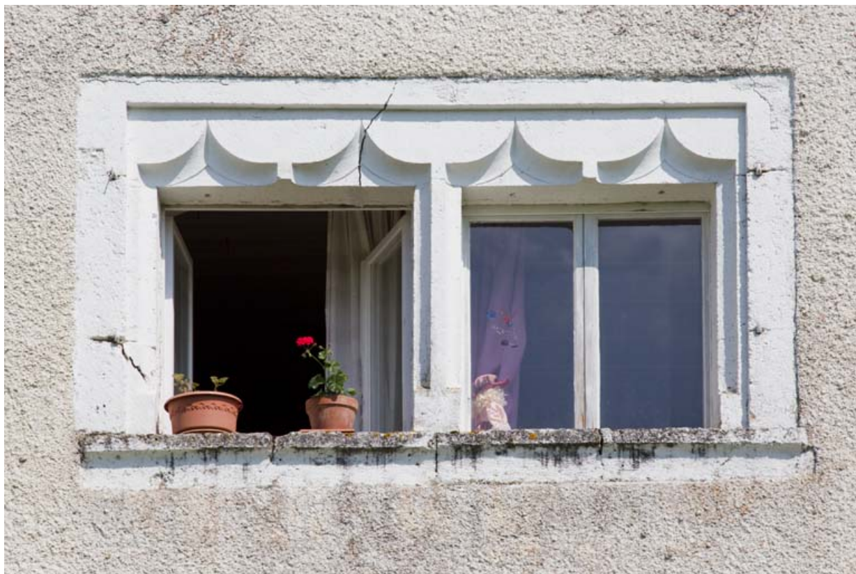
Façade latérale droite : baies coiffées d'arcs en accolade.
