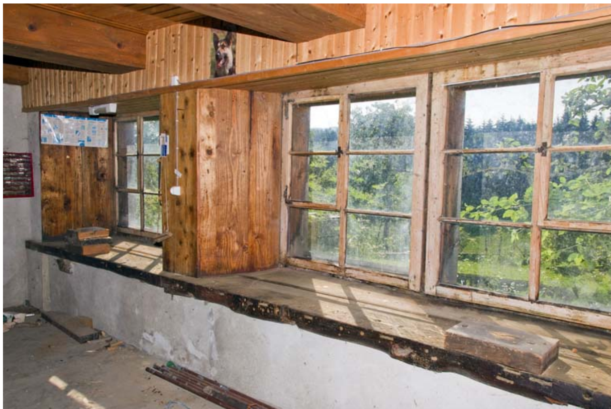
Atelier : intérieur, montrant l'emplacement de l'établi et les fenêtres. 25, Charmauvillers, 20-22 Grande Rue
