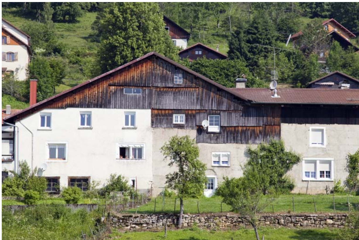
Façade latérale droite (vue rapprochée).
