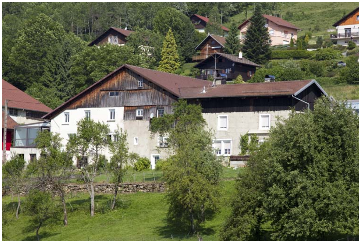
Vue d'ensemble rapprochée depuis le sud-est.
