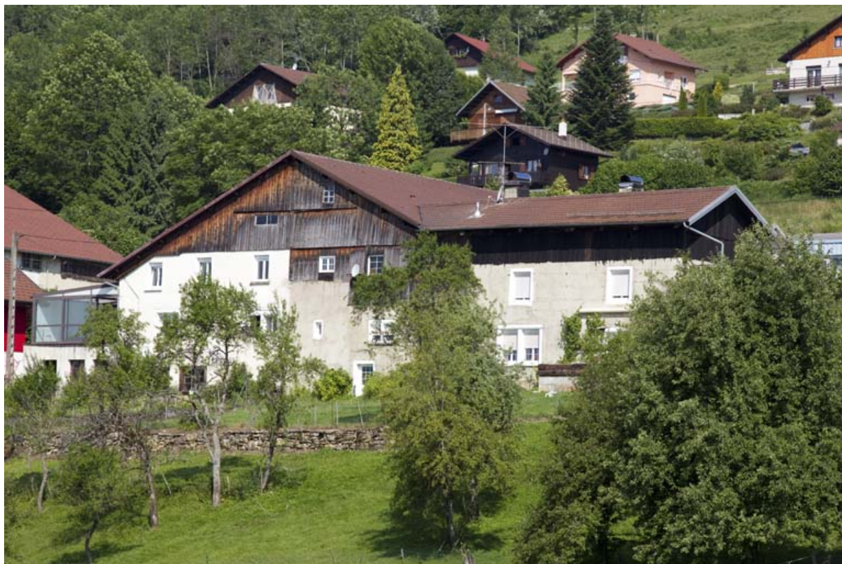
Vue d'ensemble rapprochée depuis le sud-est.
