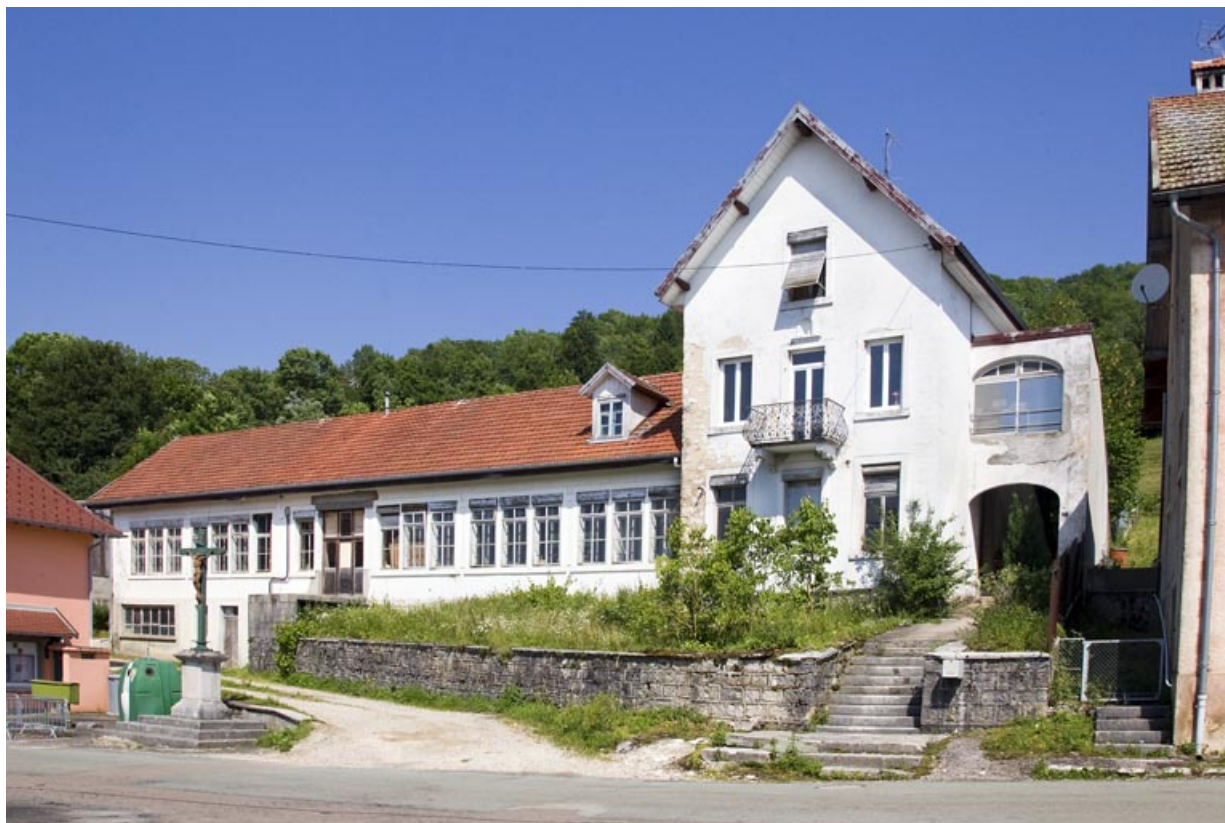
Usine de boîtes de montre Nappey Frères, à Charmauvillers. 25, Charmauvillers, 7 Grande Rue
