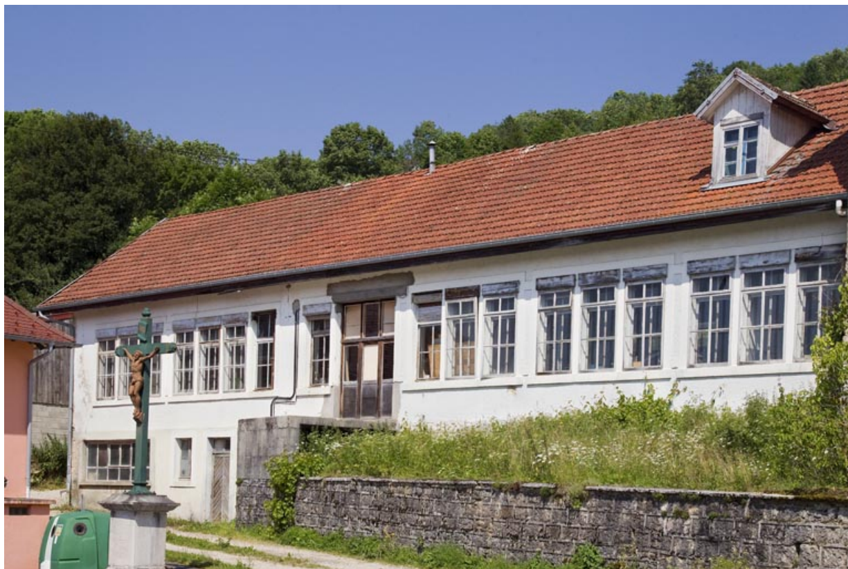
Façade antérieure de l'atelier.
