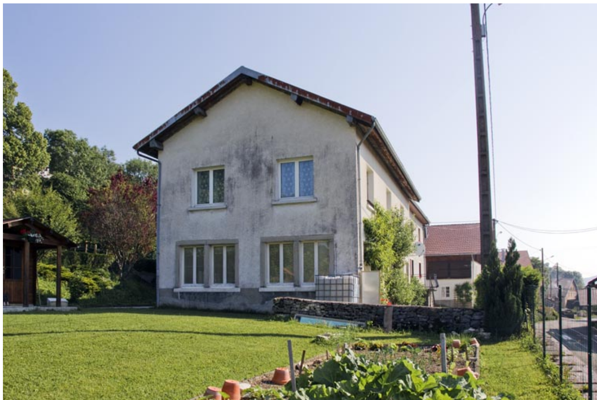
Façade latérale gauche de l'atelier.
