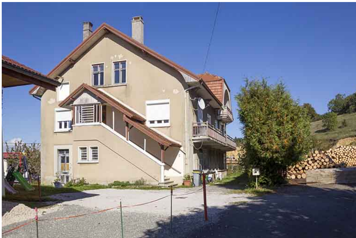
Vue d'ensemble depuis la rue de l'Industrie.
