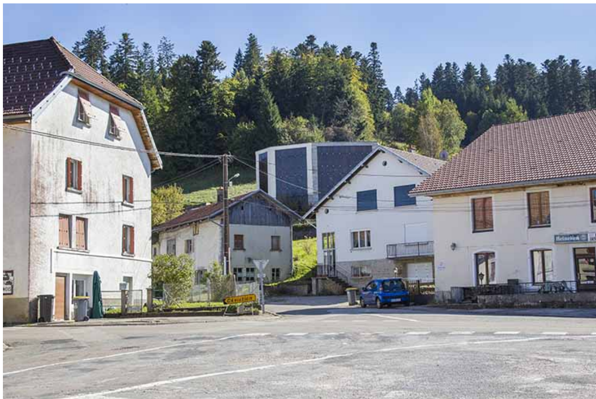
Vue d'ensemble depuis la rue de l'Industrie, au nord. 25, Damprichard, 1 rue des Clos Magnin
