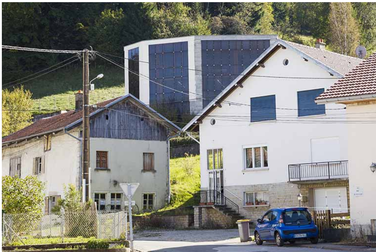
Atelier de fabrication du milieu des années 1990, depuis la rue de l'Industrie. 25, Damprichard, 1 rue des Clos Magnin
