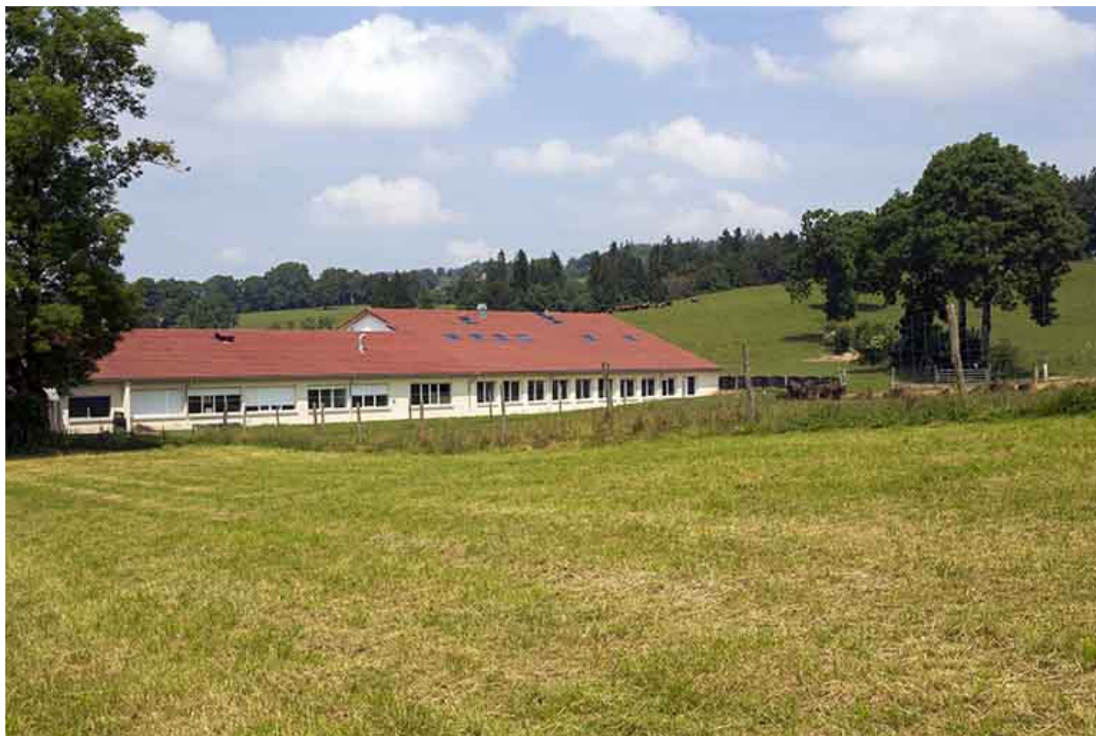
Façade postérieure (sud), de trois quarts gauche.
