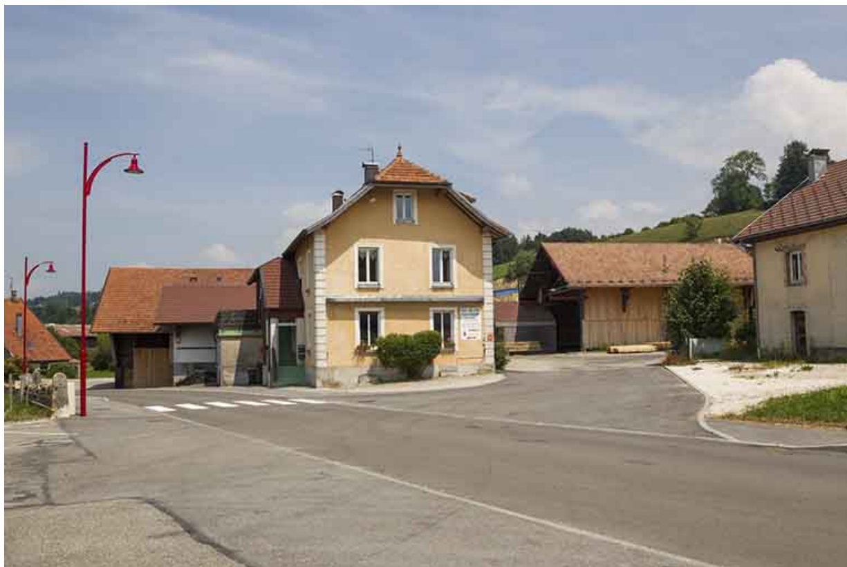
Bureau, logement et atelier de fabrication, depuis la rue du Professeur Grammont. 25, Damprichard, 14 rue du Professeur Grammont
