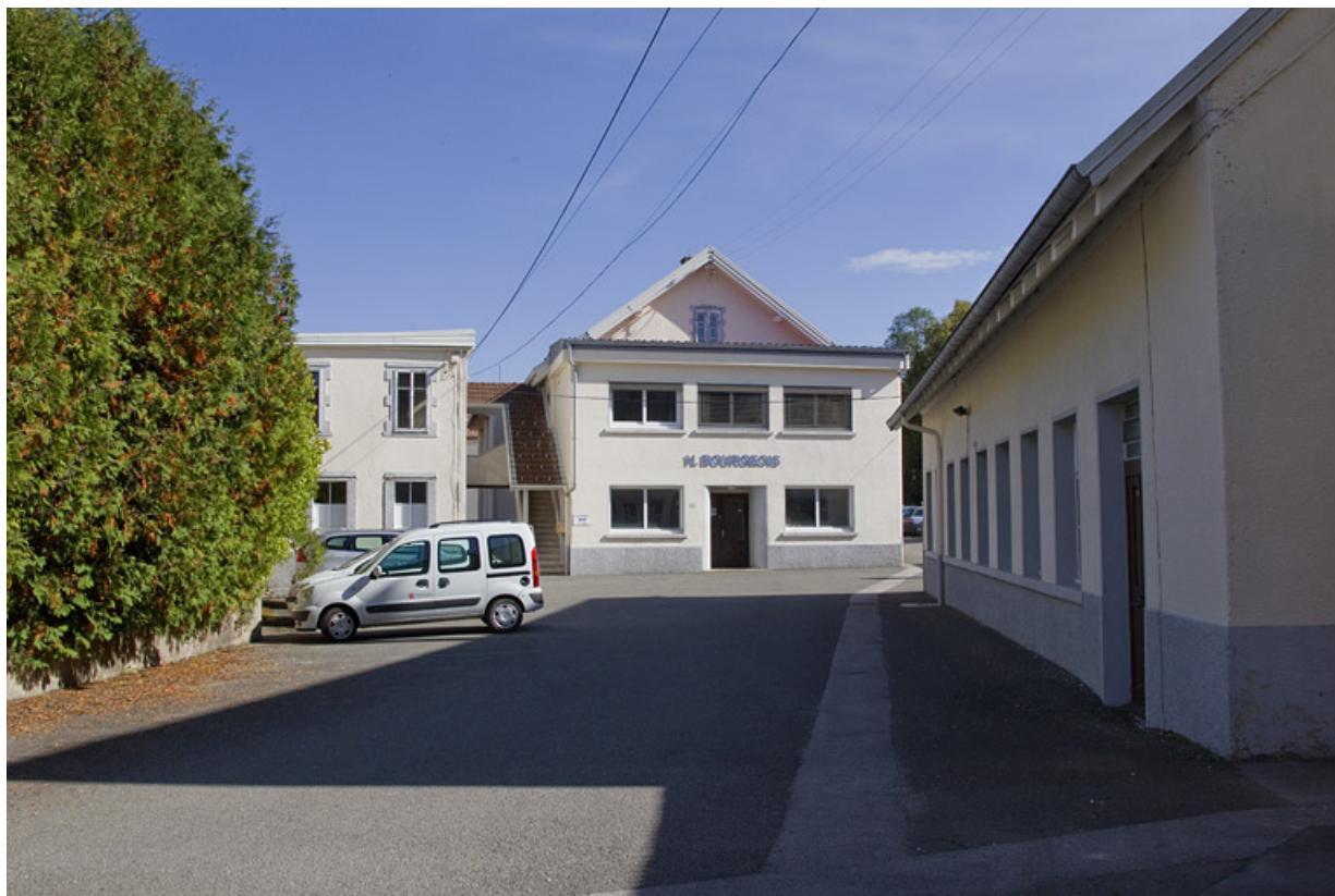
Bureau et atelier rehaussé en 1923-1924, depuis l'entrée de la cour. 25, Damprichard, 1 rue de l' Industrie
