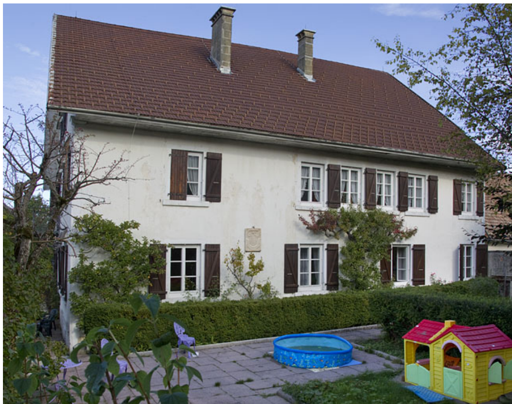
Logement patronal : façade latérale droite (les fenêtres rapprochées signalent l'emplacement de l'ancien atelier). 25, Damprichard, 1 rue de l' Industrie
