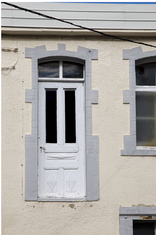
Atelier rehaussé en 1923-1924 : porte haute.
