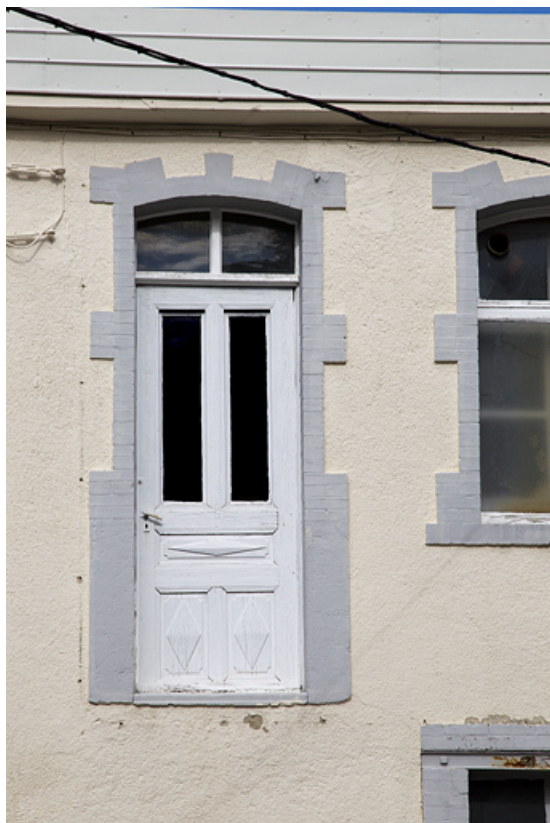
Atelier rehaussé en 1923-1924 : porte haute.
