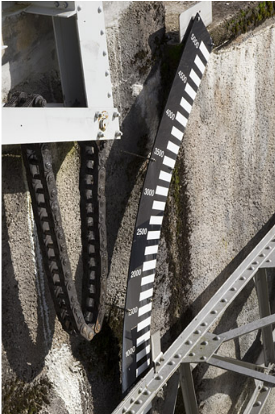
Barrage : repère mesurant l'ouverture d'une vanne secteur.
