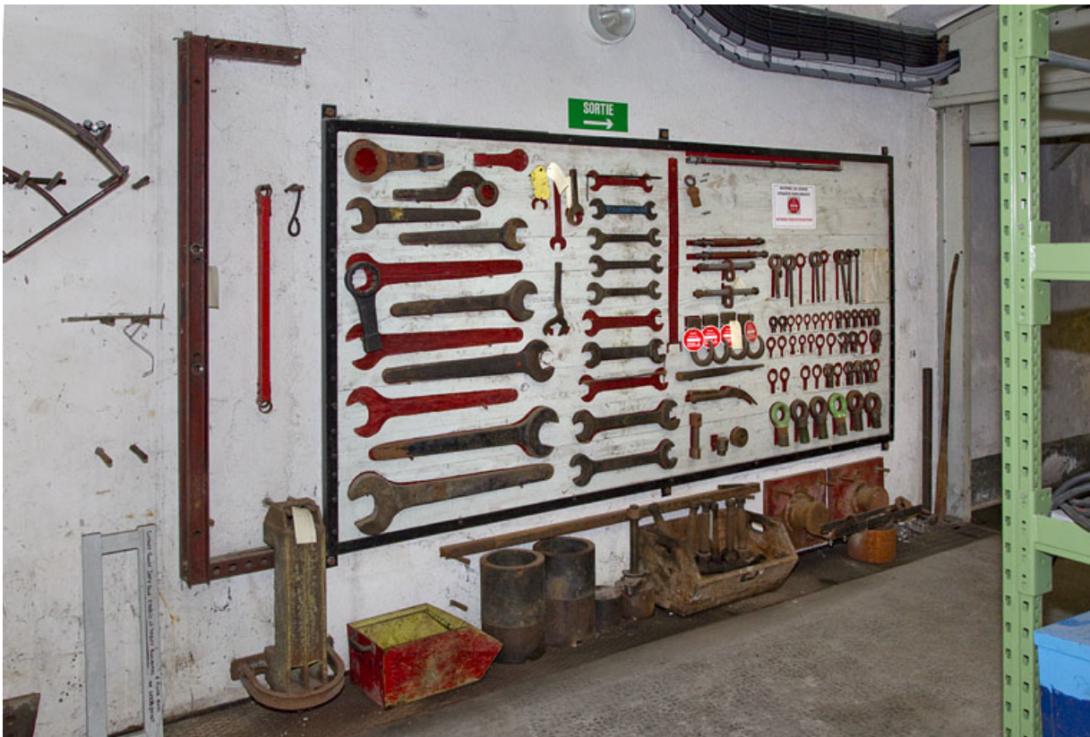
Centrale : ratelier de clefs à l'étage de soubassement. 25, Liebvillers, lieudit : Moulin Artus
