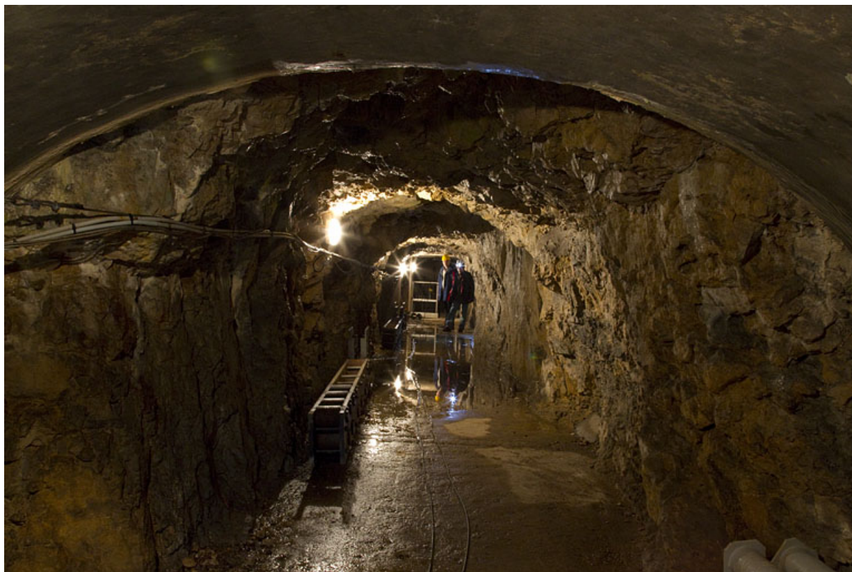
Tunnel d'amenée d'eau : galerie d'accès à la cheminée d'équilibre.
