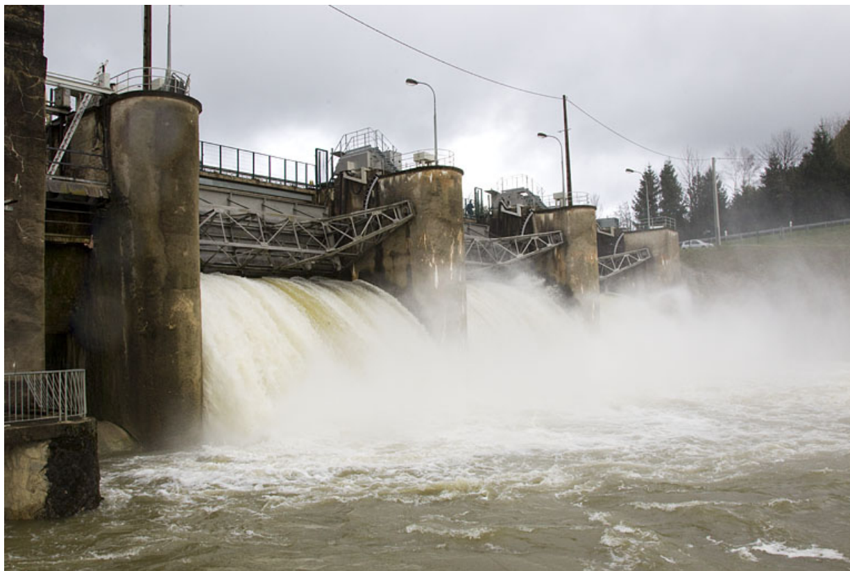
Le barrage en période de crue, depuis l'aval. 25, Vaufrey, lieudit : Barrage de Vaufrey
