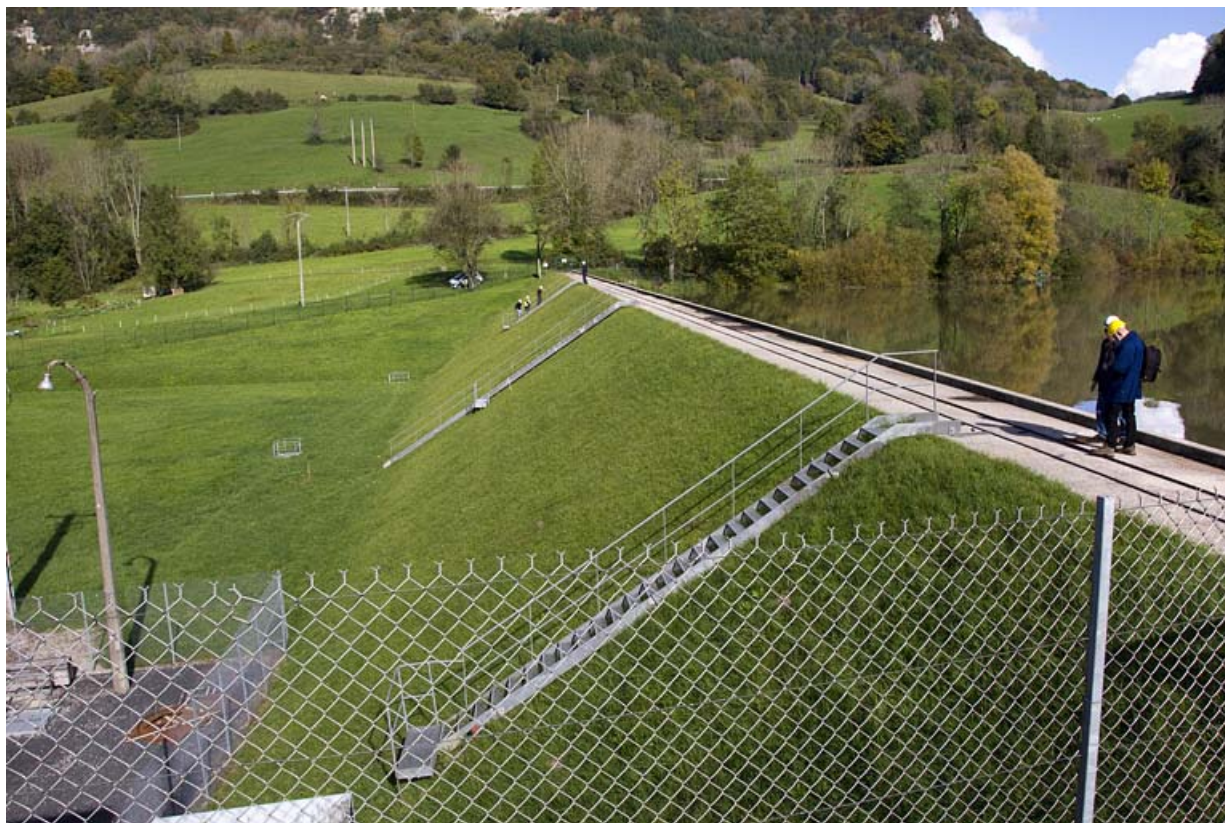
La digue depuis le barrage (côté rive gauche).
