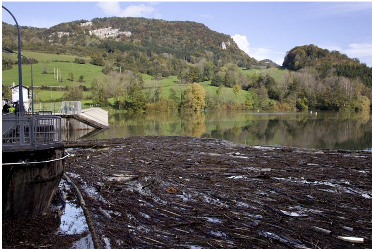
Barrage : amoncellement de branches et débris en amont.
