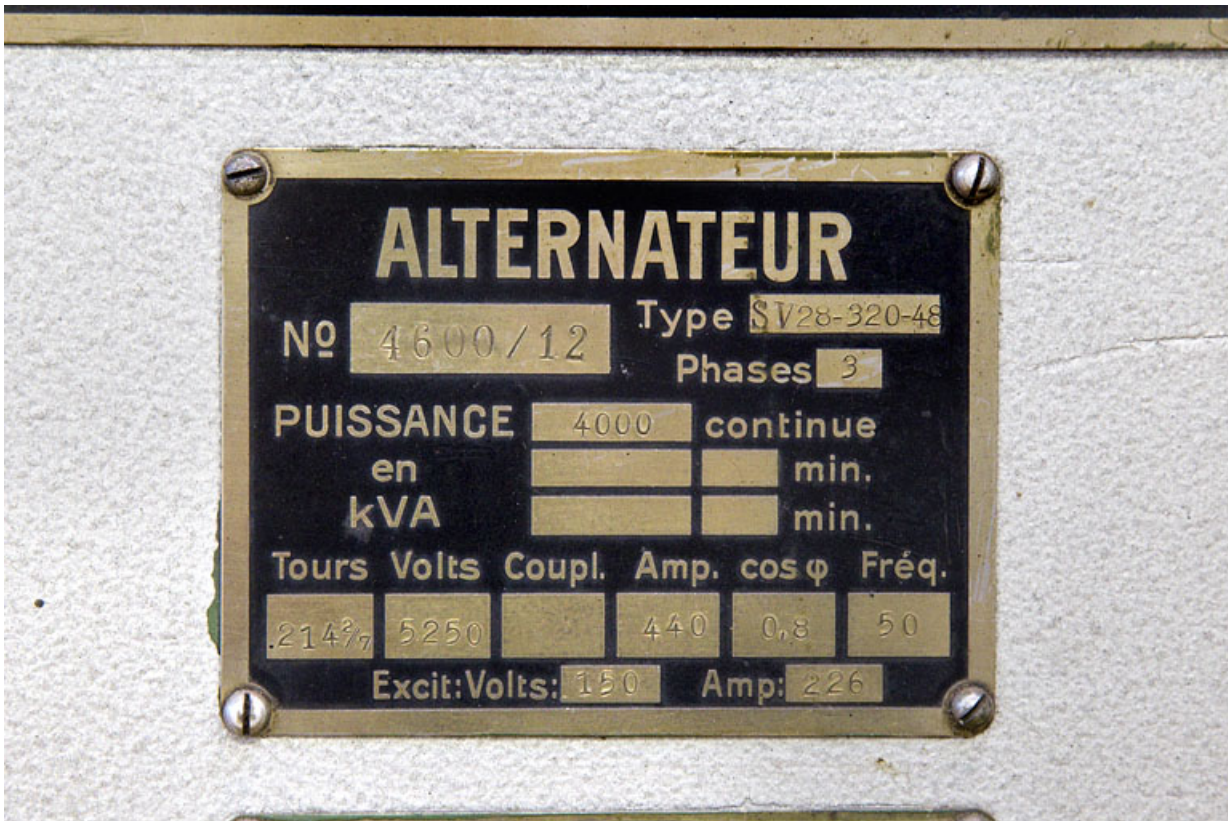
Groupe n° 1 : plaque signalétique de l'alternateur.
