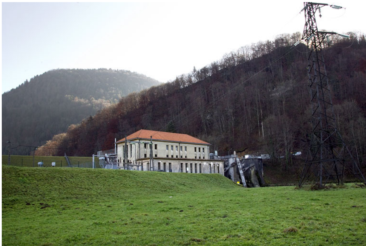
Vue d'ensemble depuis le nord (aval rive droite).
