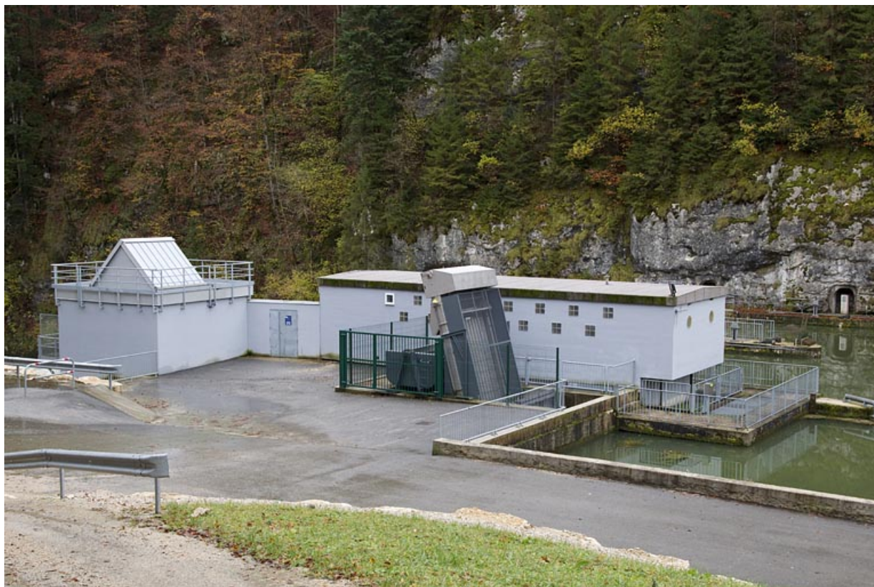
Barrage : prise d'eau et salle des machines (centrale du groupe de restitution) au premier plan, salle de commande des vannes toits à l'arrière-plan.
