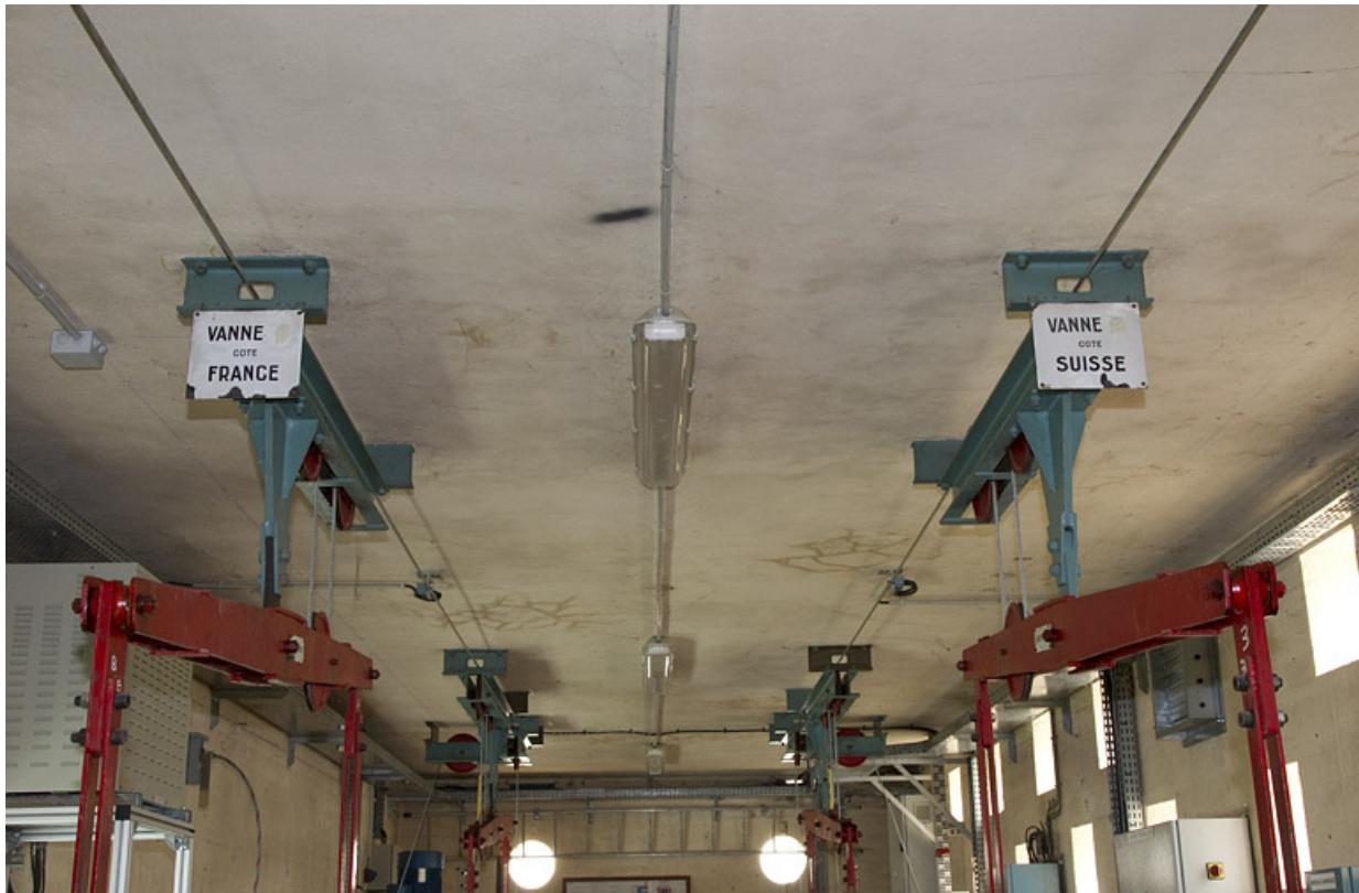
**Barrage : repérage des vannes toit.**
