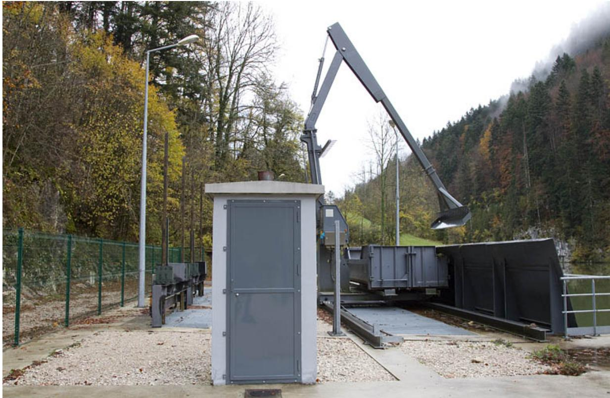
**Prise d'eau : dégrilleur automatique et édicule protégeant un puits limnimétrique.**
