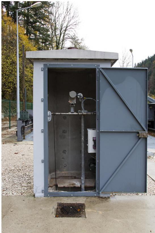
**Prise d'eau : édicule et puits limnimétrique.**
