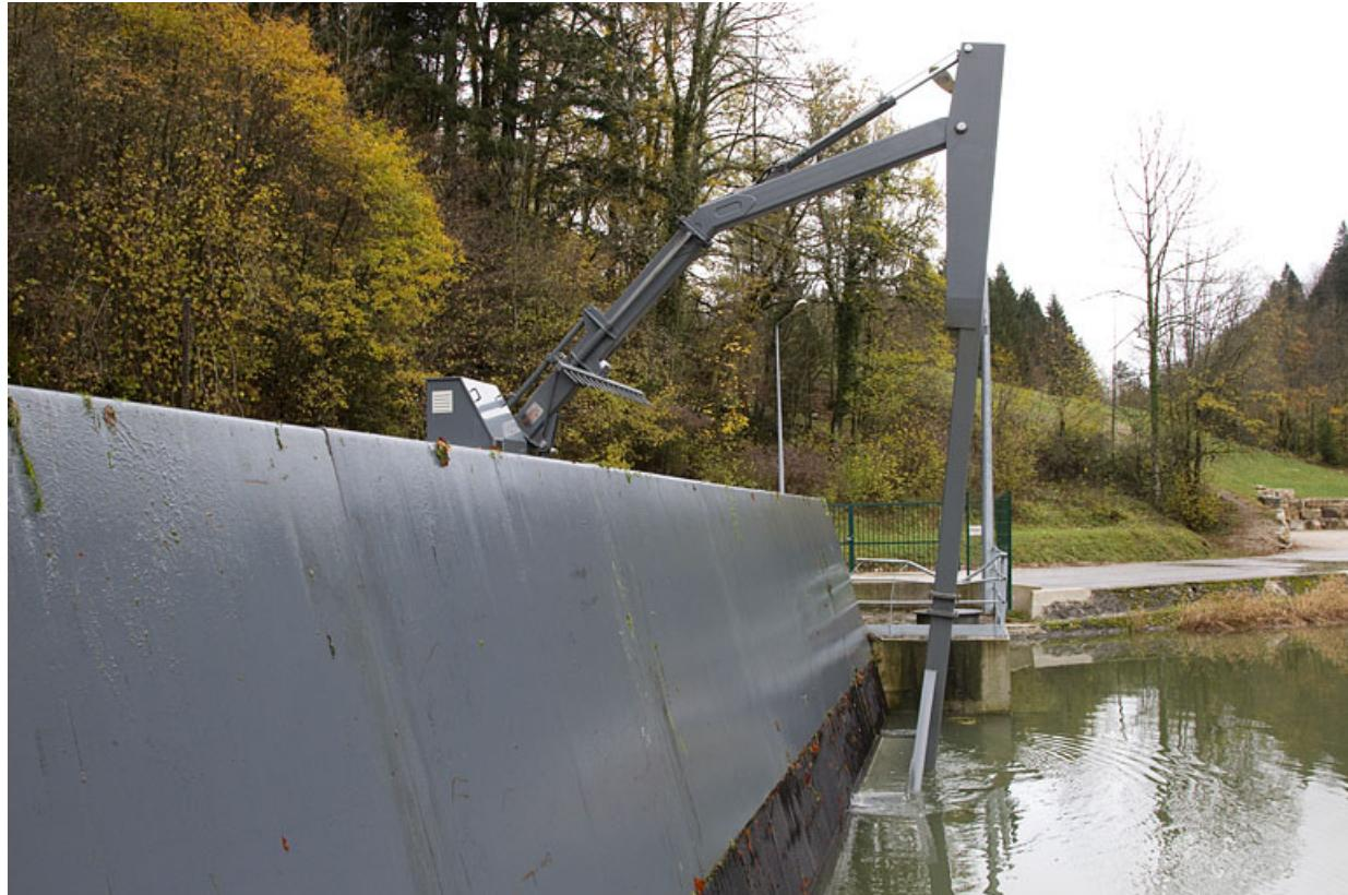
**Prise d'eau : dégrilleur en fonctionnement.**
