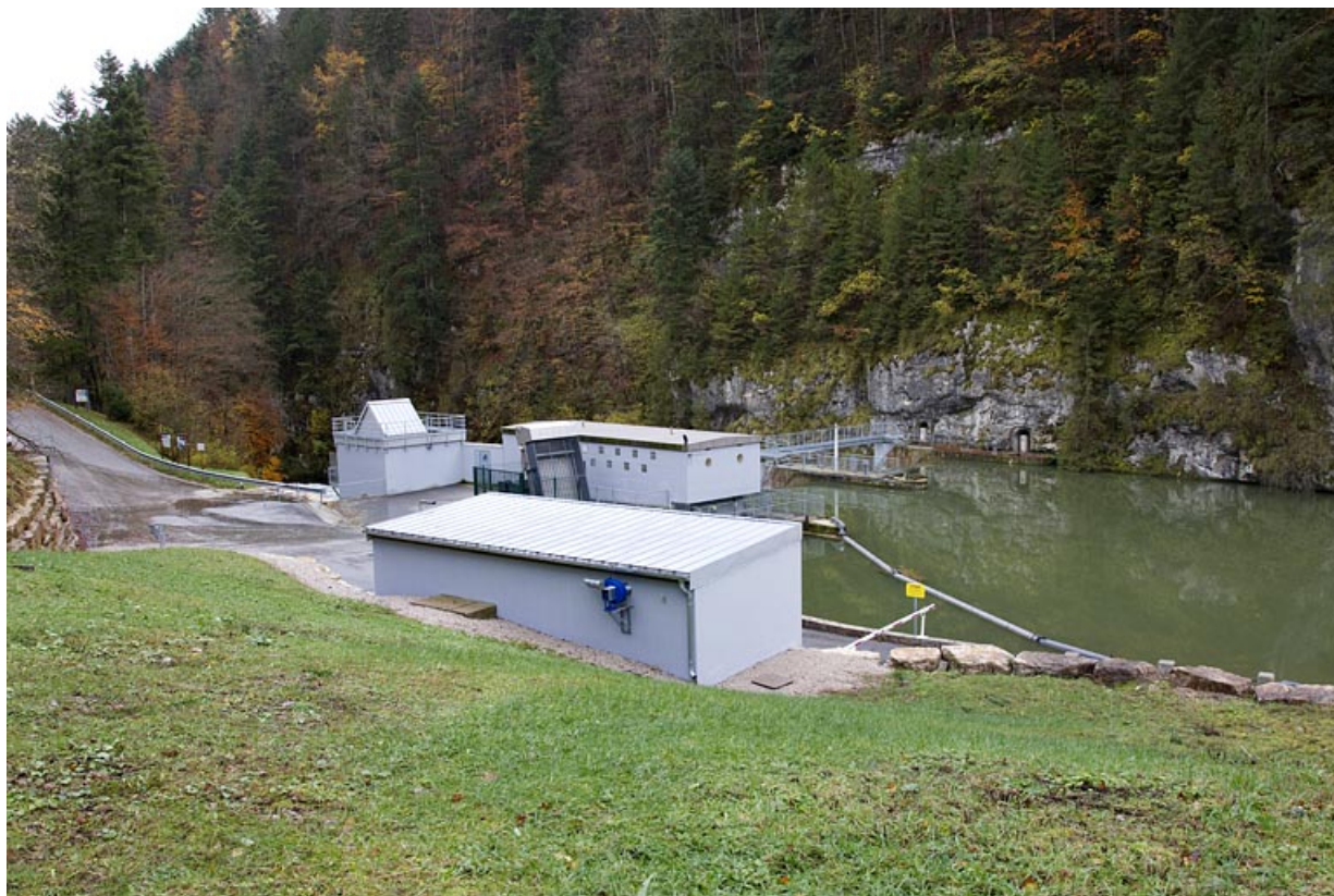
Vue d'ensemble depuis le nord-ouest (amont).
