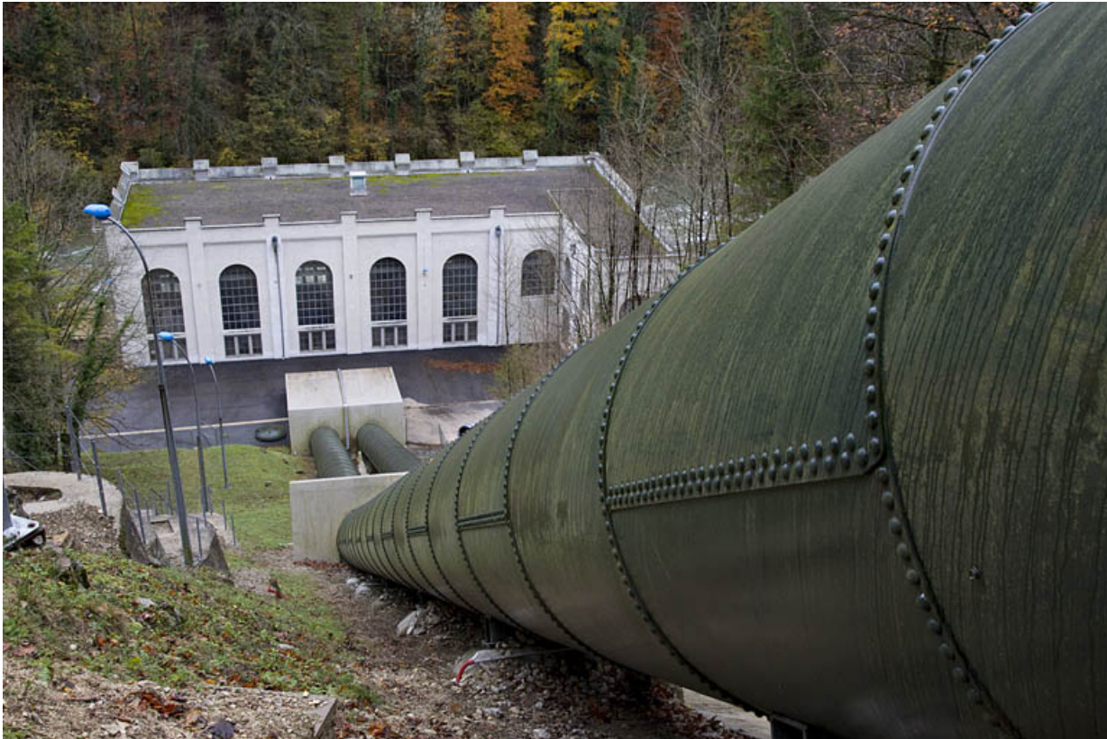
Conduite forcée : vue plongeante.
