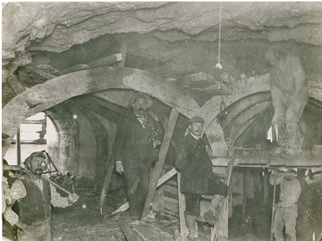
[Construction de la chambre de mise en charge], [vers 1908].
