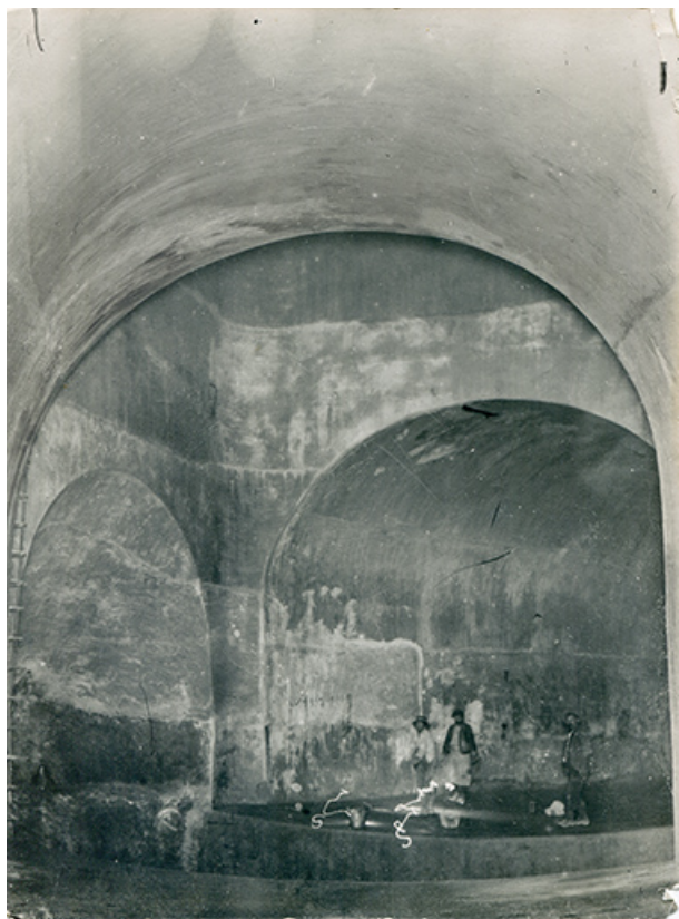
[Chambre de mise en charge achevée], [1908 ?].
