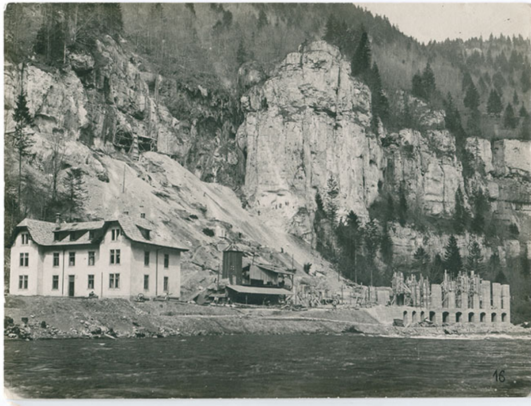
[Vue d'ensemble du site, avec construction des murs de la centrale], [1908 ?]. 25, Charquemont, lieudit : Mortier
