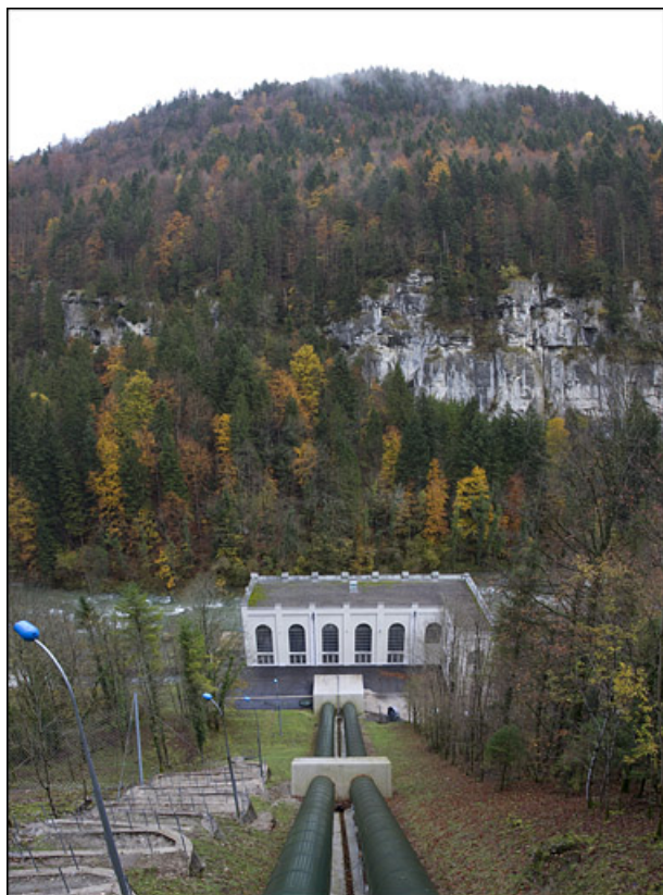
Centrale hydroélectrique du Refrain, à Charquemont.
