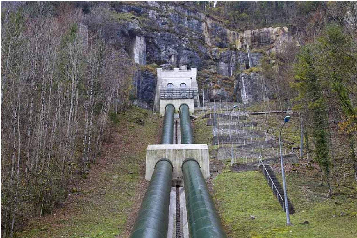
Conduite forcée : chambre de mise en charge et conduite, depuis la centrale. 25, Charquemont, lieudit : Mortier
