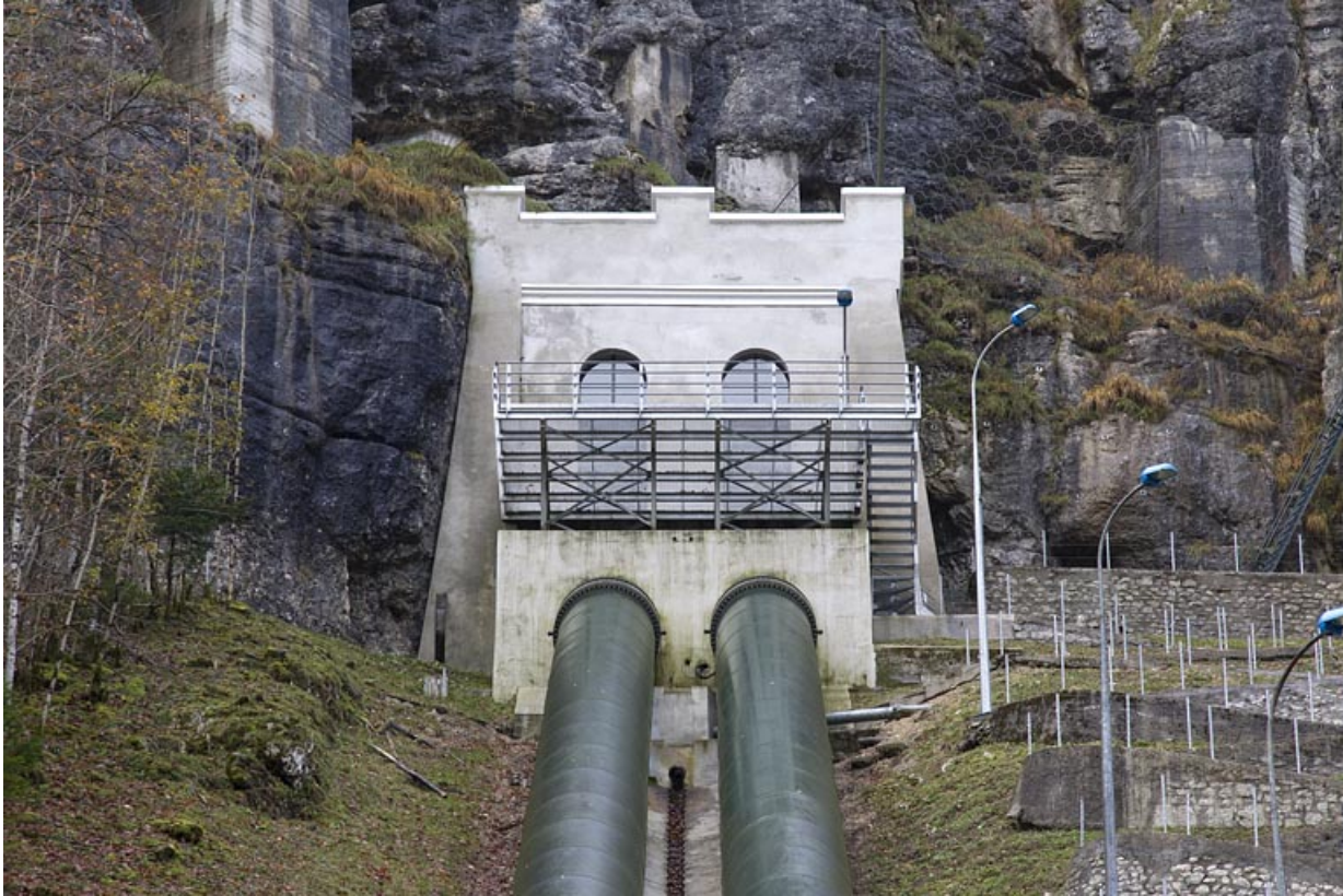
Conduite forcée : chambre de mise en charge.
