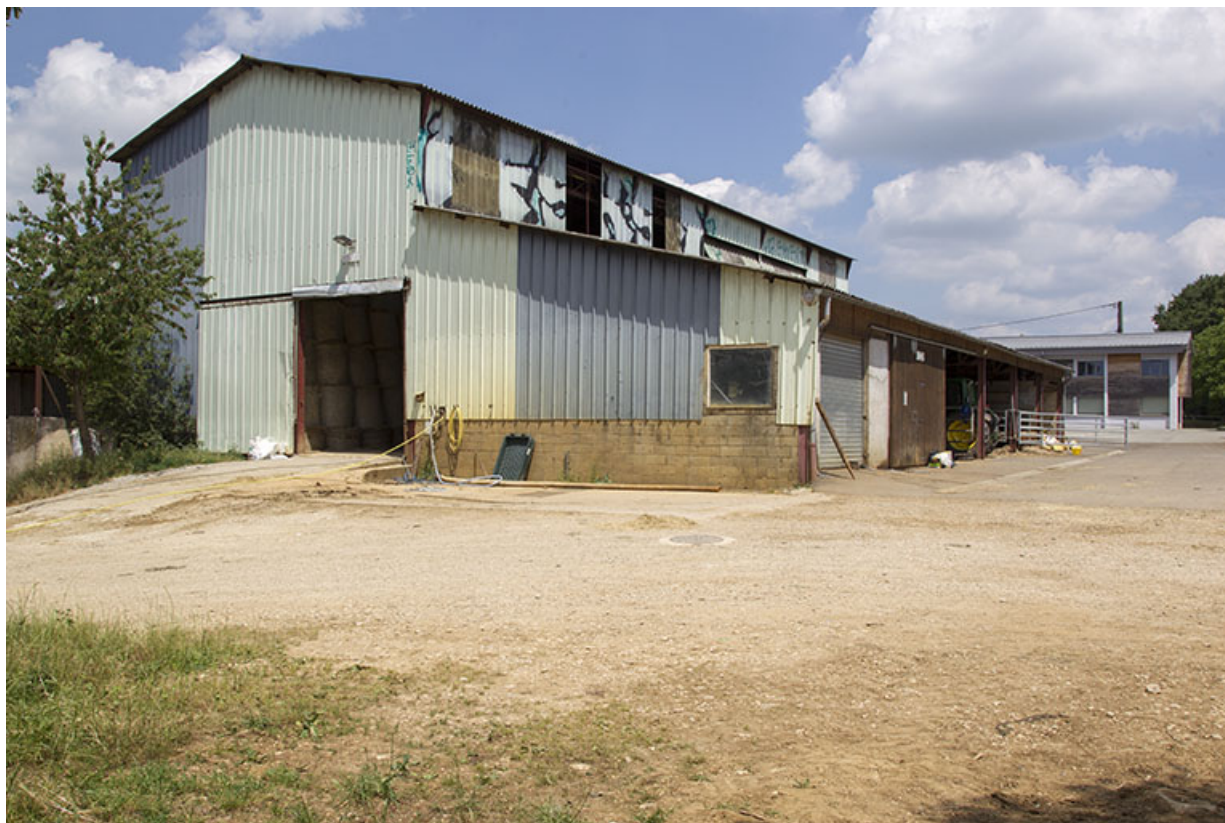
Vue de trois-quart sud-est de l'entrepôt agricole.
