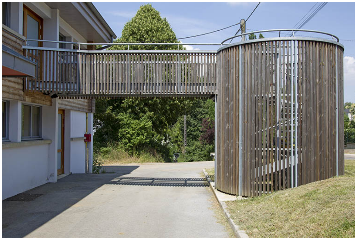
Escalier hors-oeuvre sur la face antérieure du bâtiment de services.
