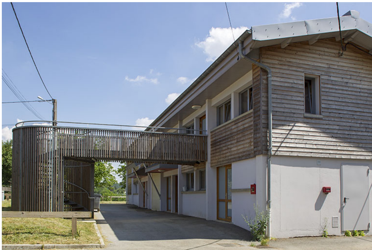
Façade antérieure - nord - et pignon ouest du bâtiment de services.
