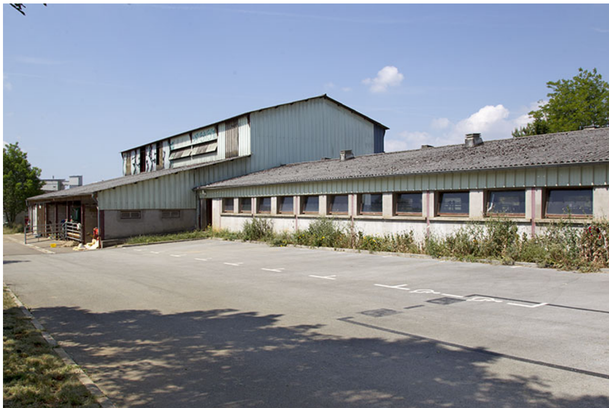
Façades est de l'étable est et de l'entrepôt agricole.
