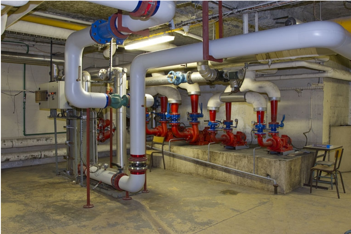
Externat (sous-sol), chaufferie : les pompes.
