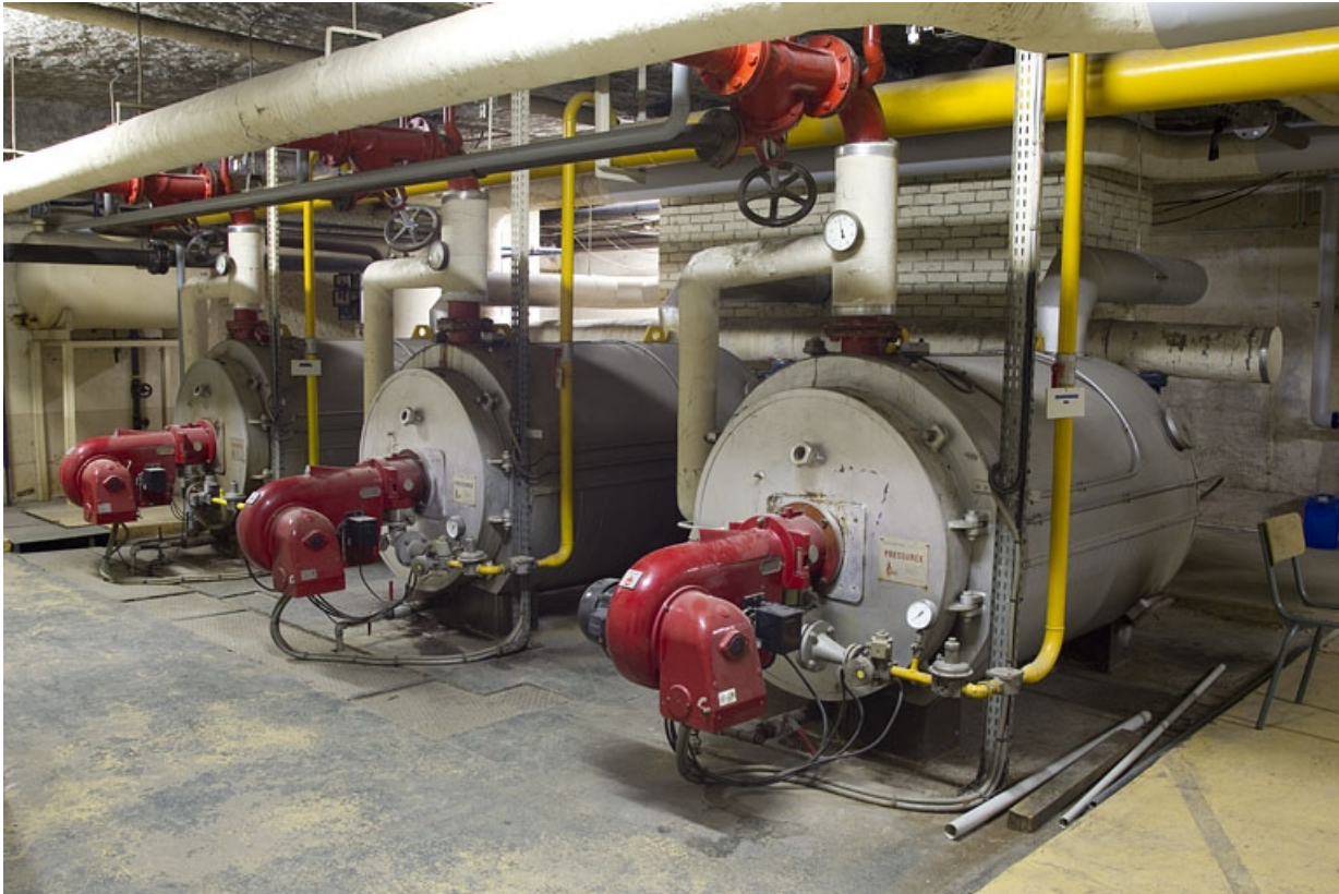
Externat (sous-sol), chaufferie : les chaudières.
