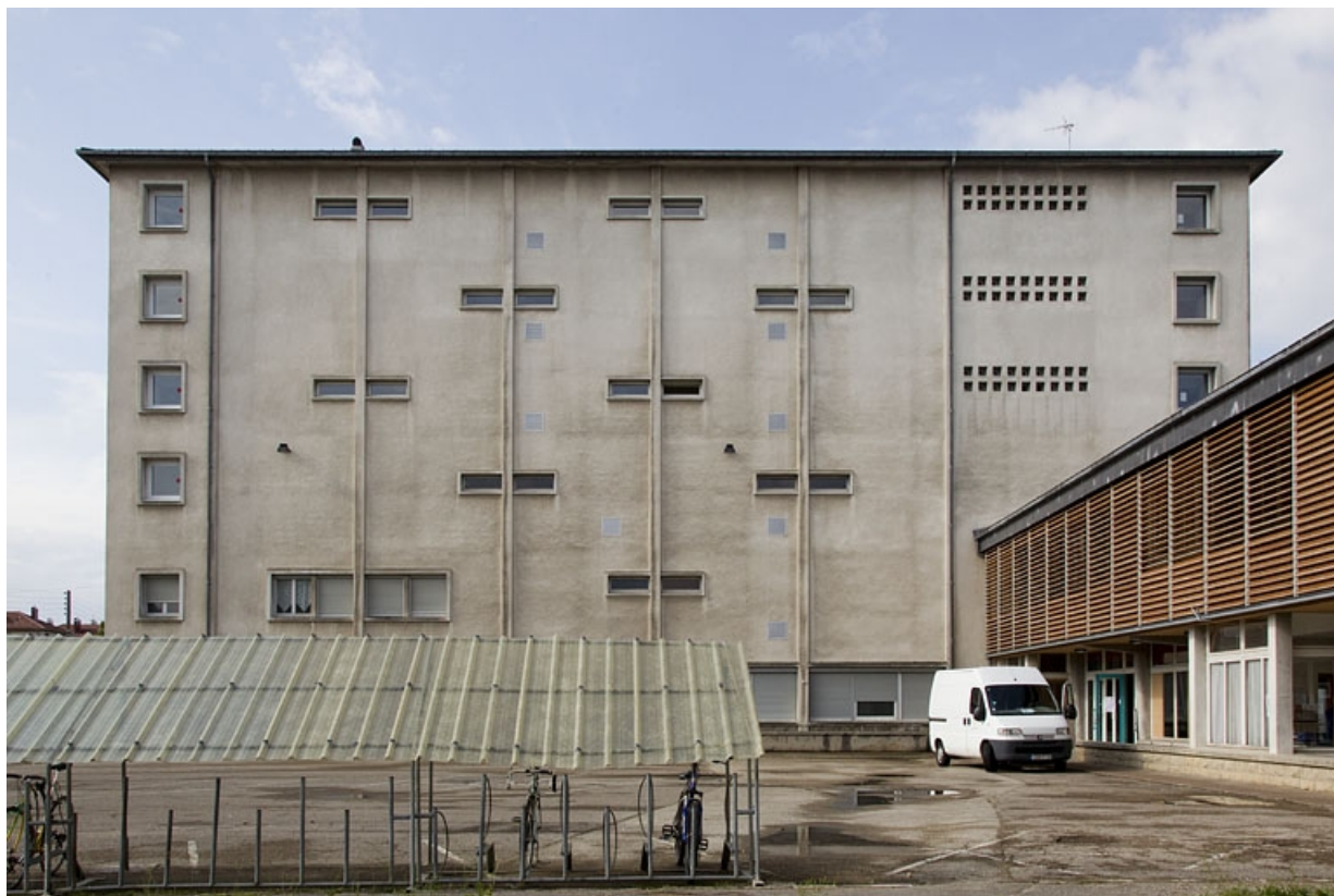
Internat garçons, vu du nord.
