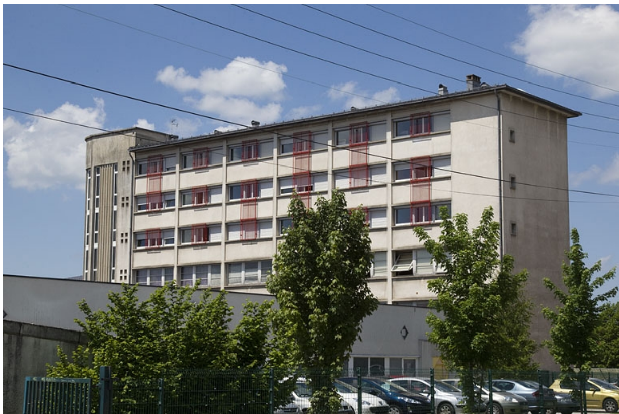
Internat garçons, vu du sud. 25, Pontarlier, 3 rue des Fusillés
