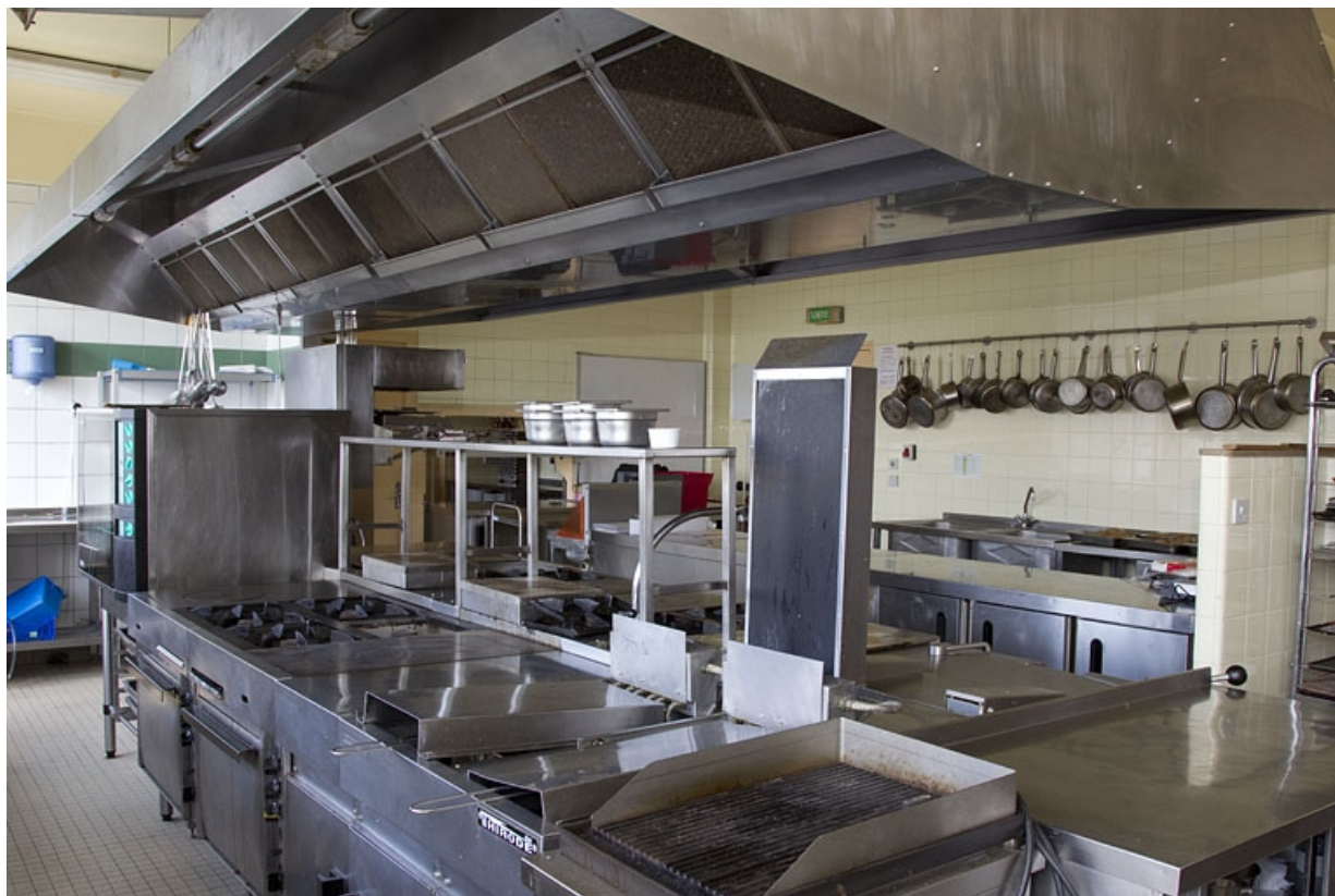
Bâtiment de l'hôtellerie : cuisine pédagogique (nord).
