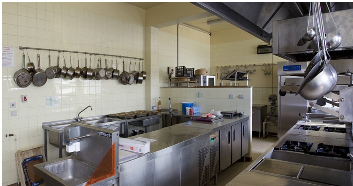
Bâtiment de l'hôtellerie : cuisine pédagogique (nord).
