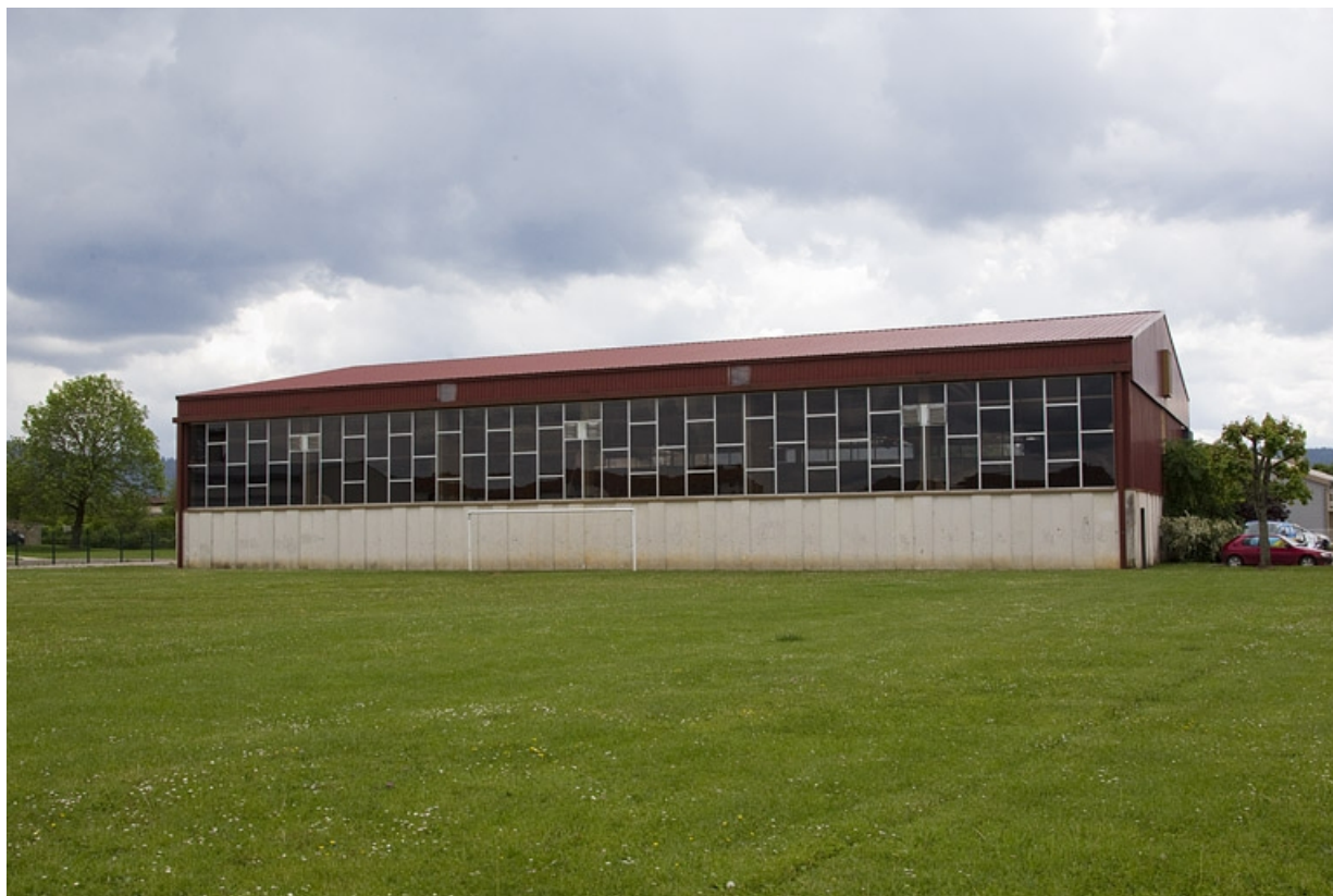
Grand gymnase occidental, vu du nord.
