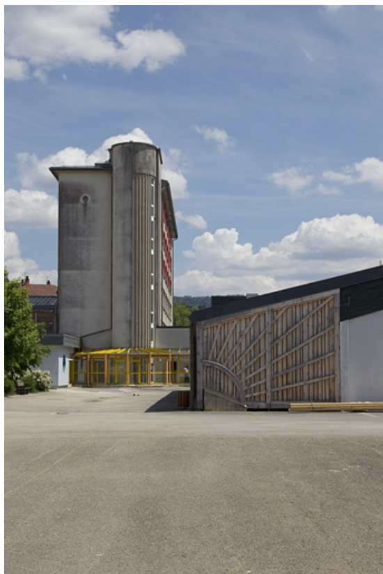
Internat garçons : face latérale et cage d'escalier.
