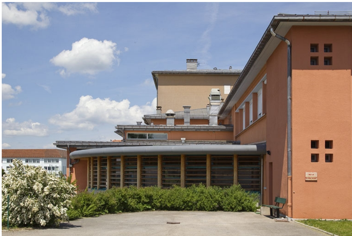
Bâtiment de la restauration : extrémité sud. 25, Pontarlier, 3 rue des Fusillés
