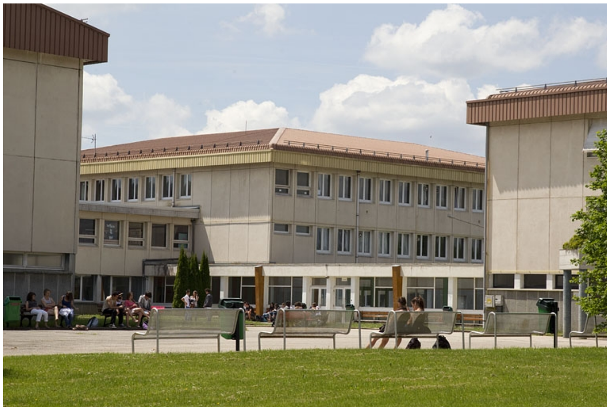
Ancien bâtiment des classe scientifiques, depuis la cour au nord-est. 25, Pontarlier, 53 rue de Doubs
