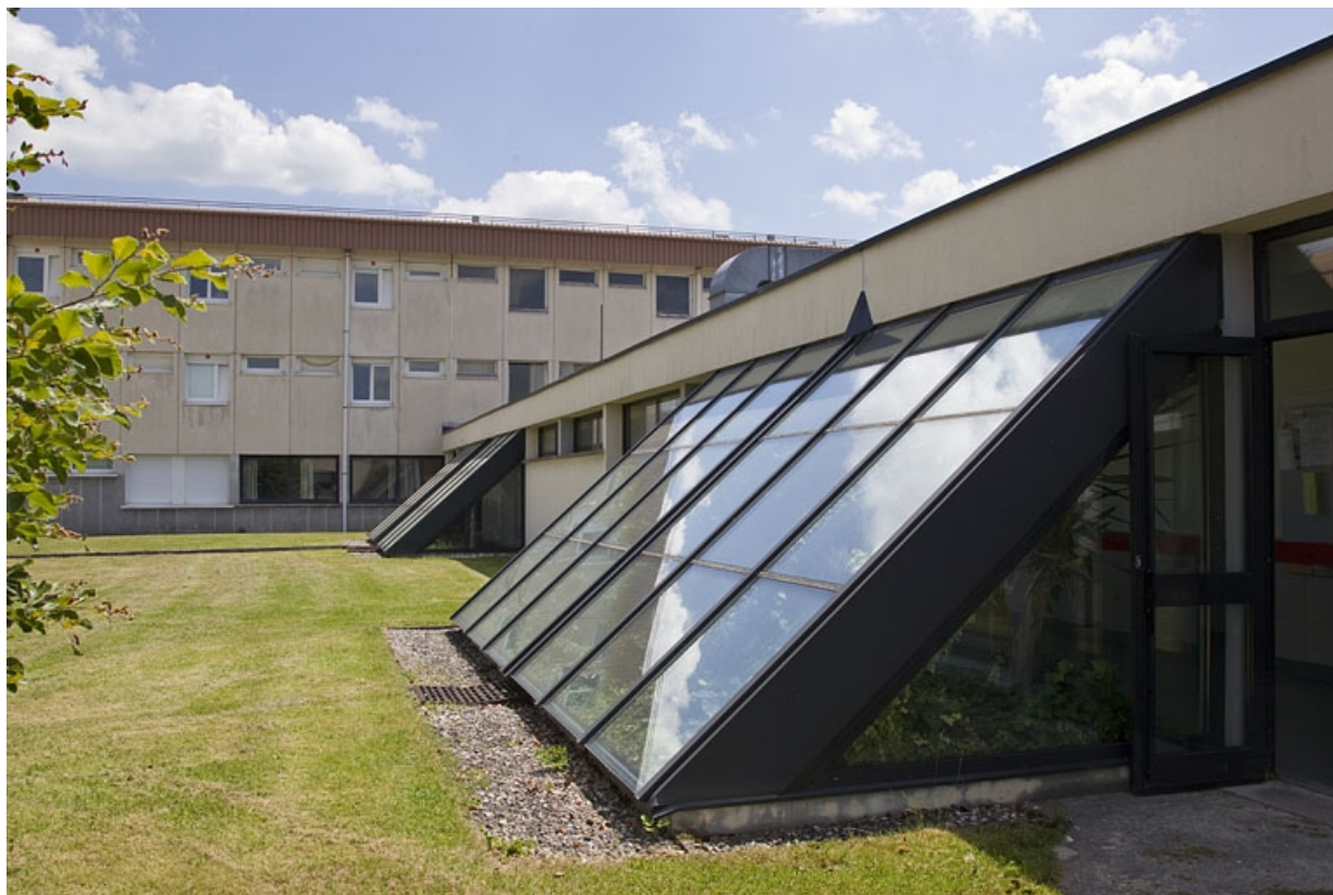
Bâtiment de la restauration : face nord.
