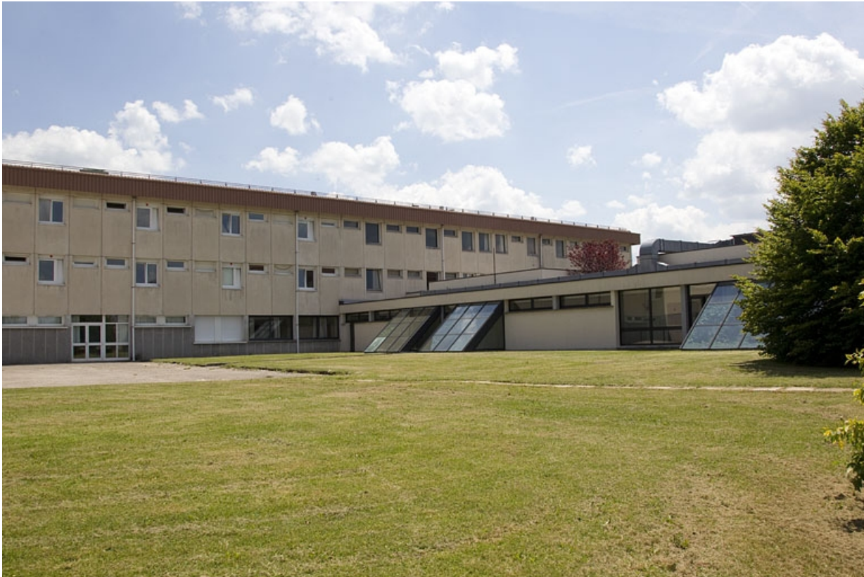
Face postérieure du bâtiment de l'infirmerie et restauration.
