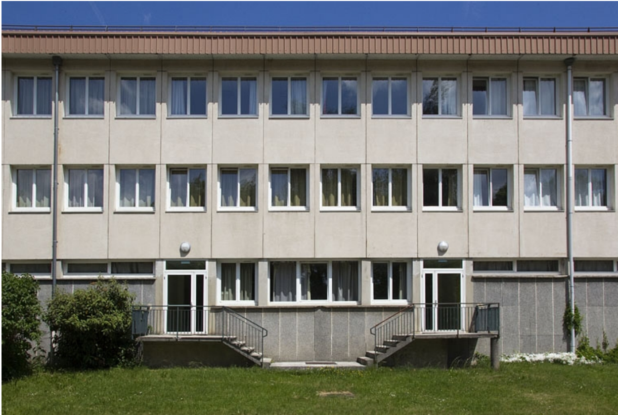
Ancien externat 1er cycle : façade latérale gauche.
