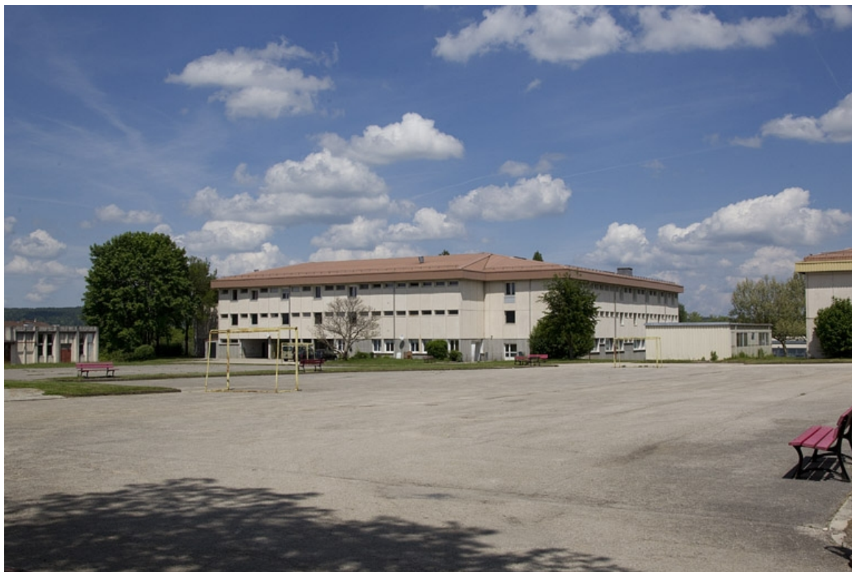
Bâtiment de l'internat ouest, vu du sud.
