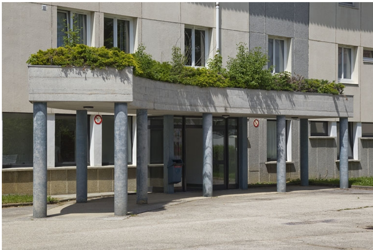
Bâtiment de l'infirmierie : portique.
