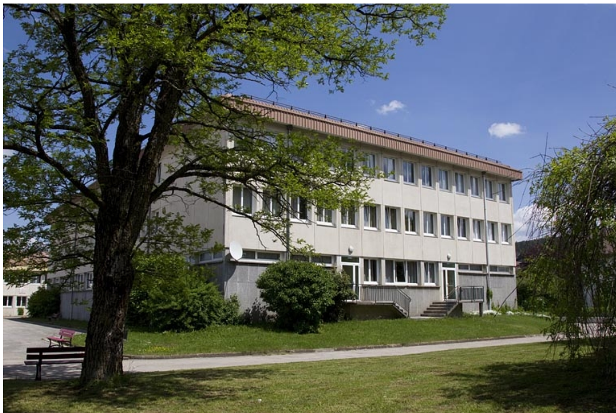
Ancien externat 1er cycle : façades postérieure et latérale gauche.
