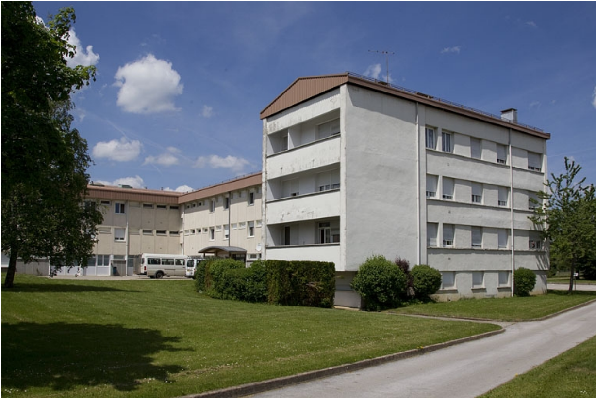
Bâtiments de l'infirmerie, des salles techniques-internat et logements. 25, Pontarlier, 53 rue de Doubs
