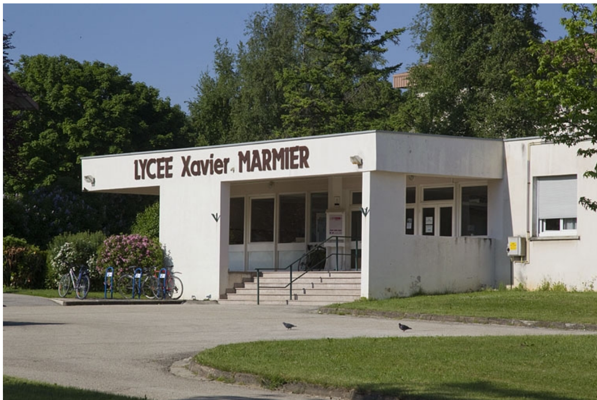
Bâtiment de l'administration : entrée.
