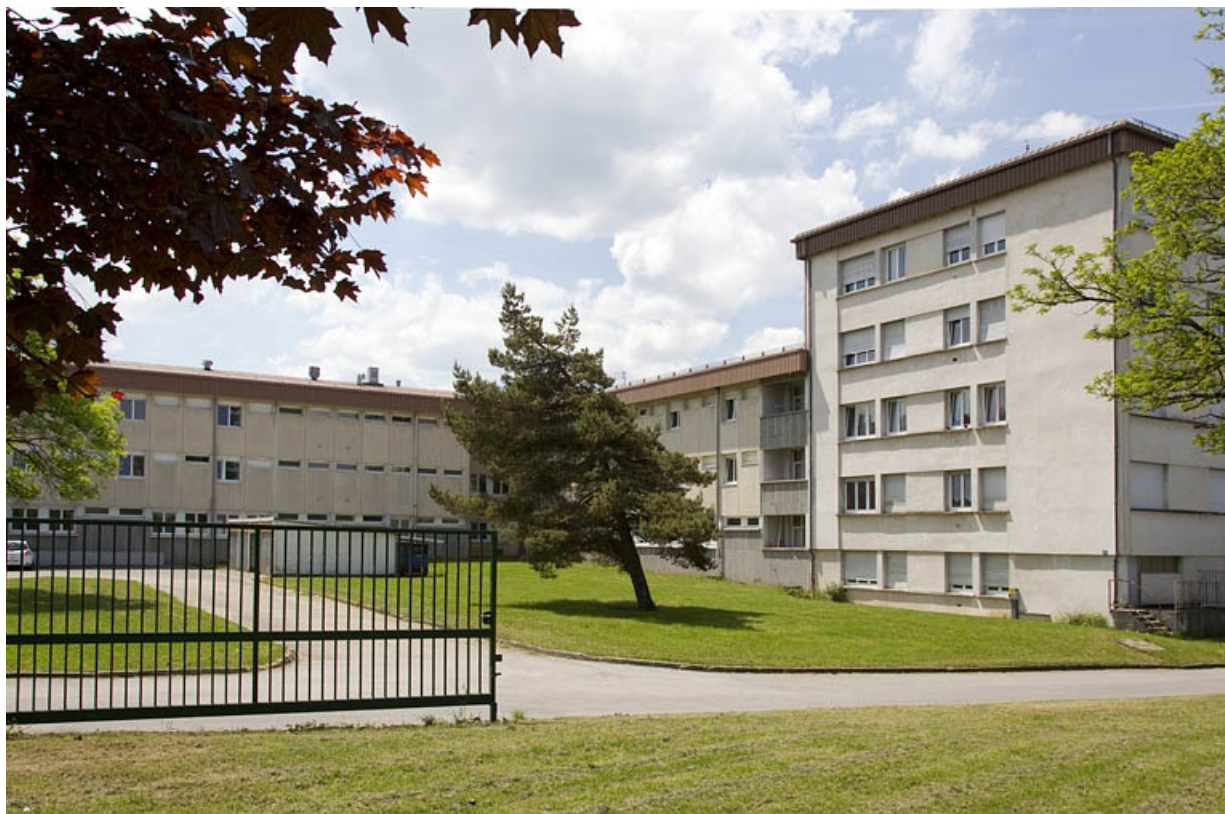
Face postérieure du bâtiment des salles techniques-internat et logements nord. 25, Pontarlier, 53 rue de Doubs
