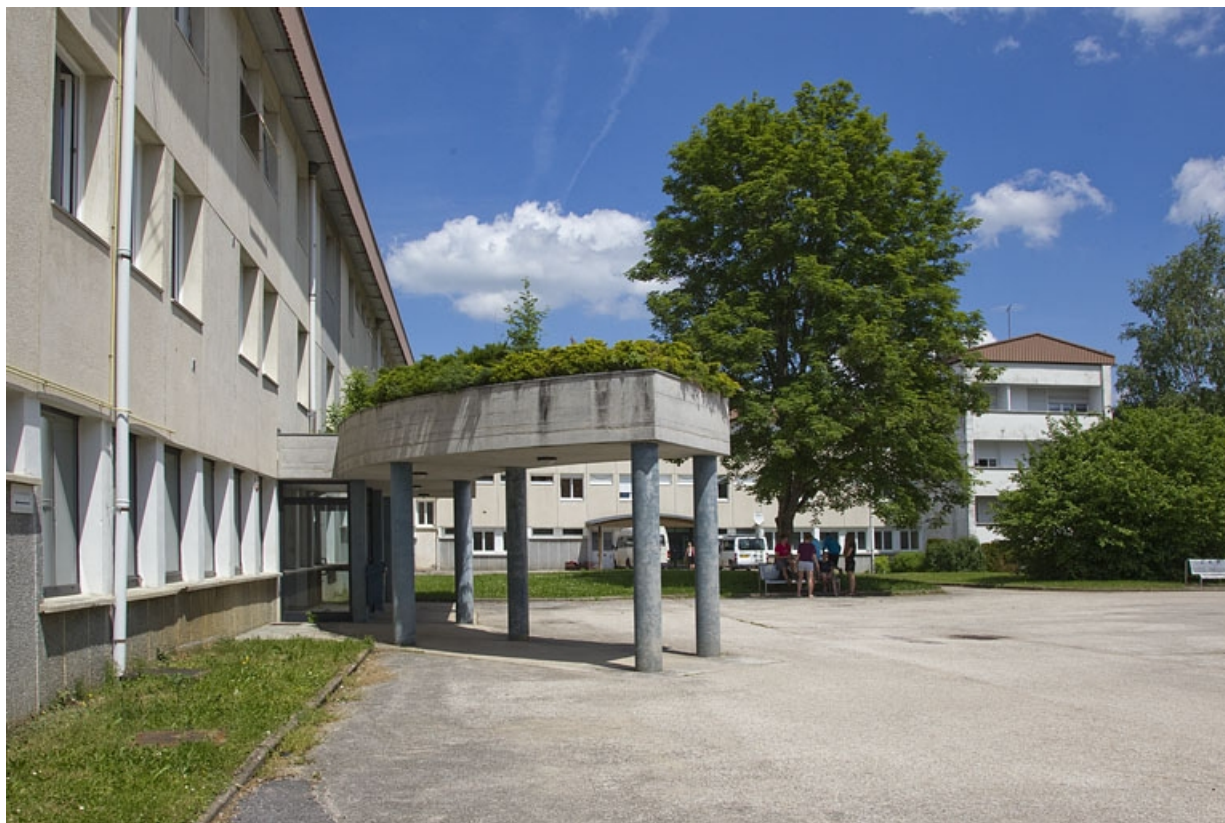
Bâtiments de l'infirmerie et des salles techniques-internat.
