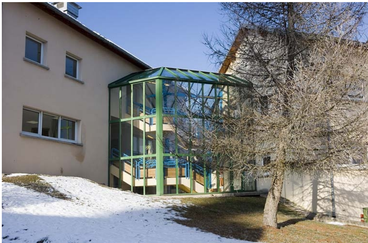
Site récent : galerie reliant l'entrée au bâtiment de l'administration.
