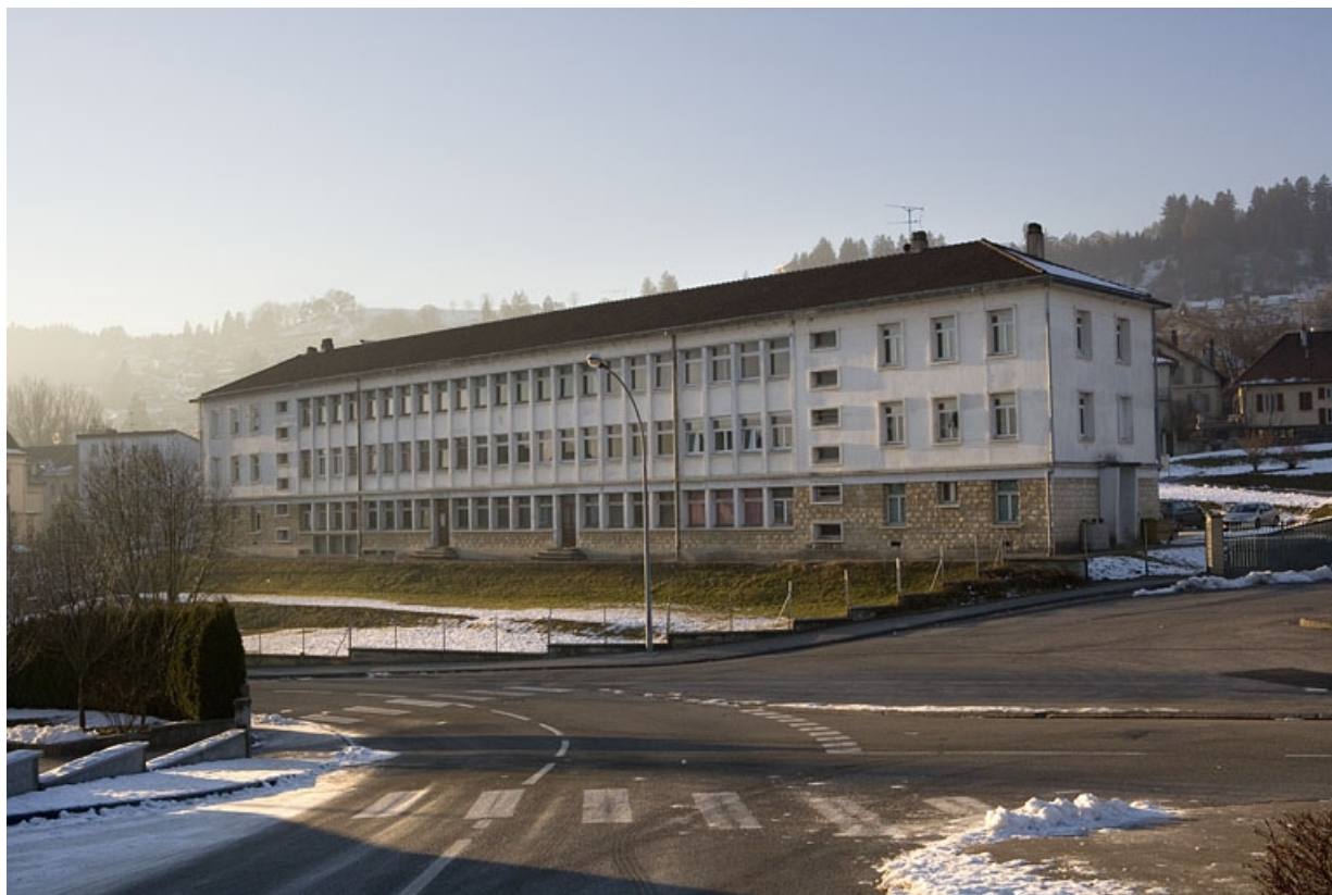
Site ancien : bâtiment du Greta (ancien internat de filles), depuis l'est. 25, Morteau, 2 rue du Docteur Léon Sauze
