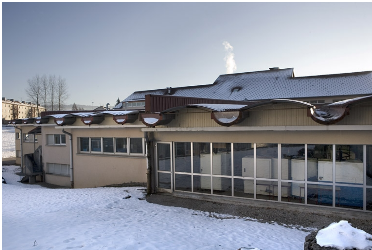
Site récent : ateliers de microtechnique et d'horlogerie, depuis le nord. 25, Morteau, 2 rue du Docteur Léon Sauze
