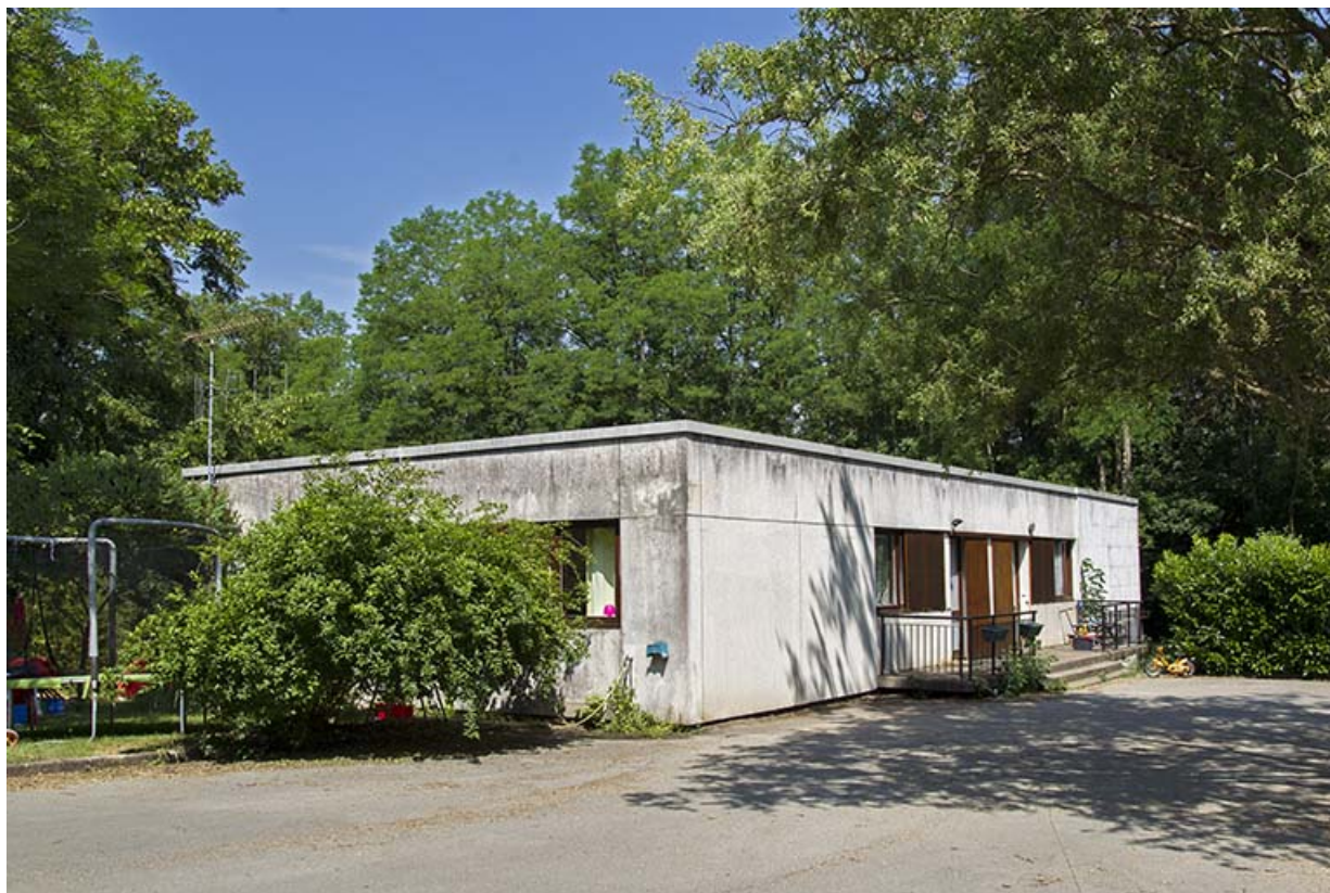
Angle sud-est des logements de fonction collectifs orientés nord sud, situés au sud-ouest du parc. 25, Dannemarie-sur-Crète, 16 rue de Damprichard
