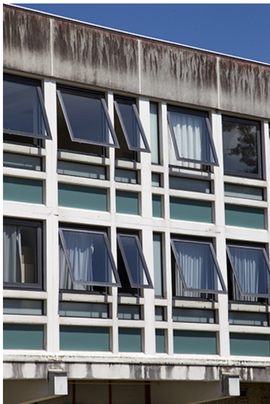
Détail de façade postérieure - ouest - de l'externat.
