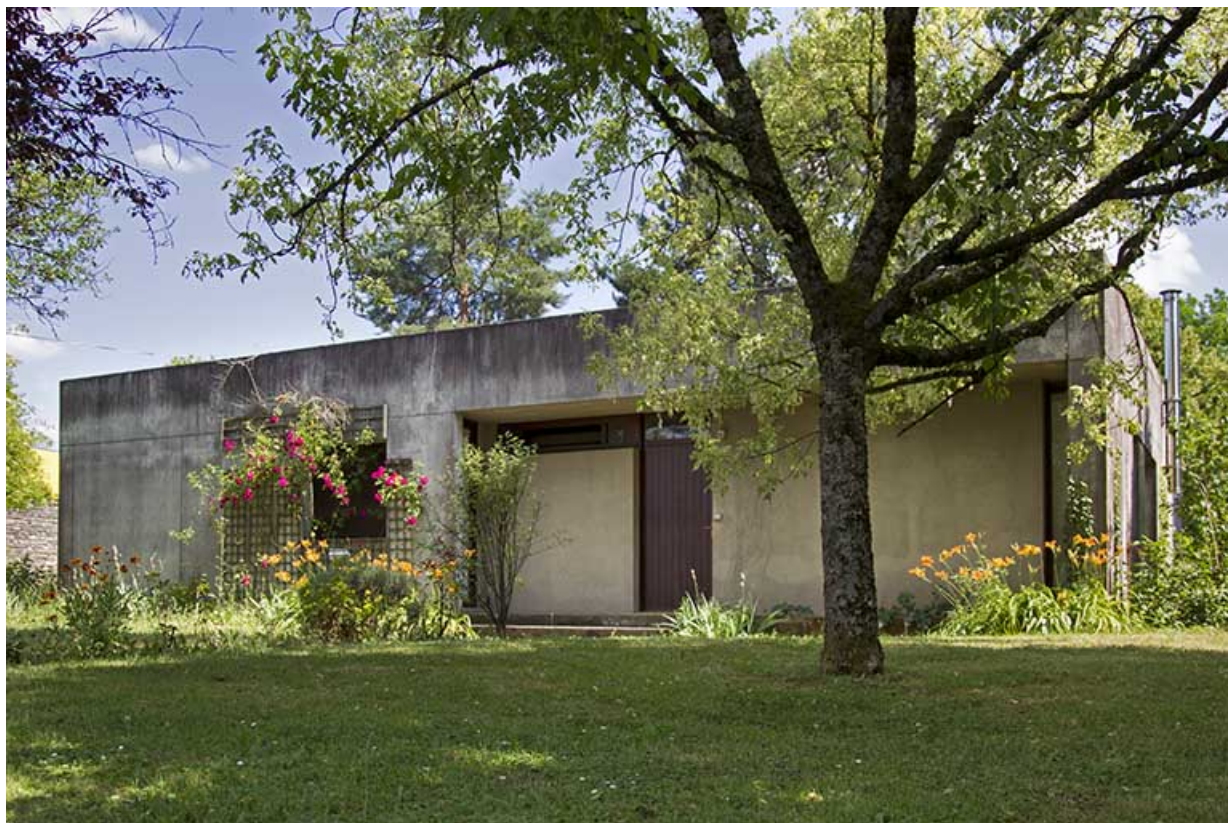
Façade nord du logement de fonction individuel situé au sud de l'administration. 25, Dannemarie-sur-Crète, 16 rue de Damprichard
