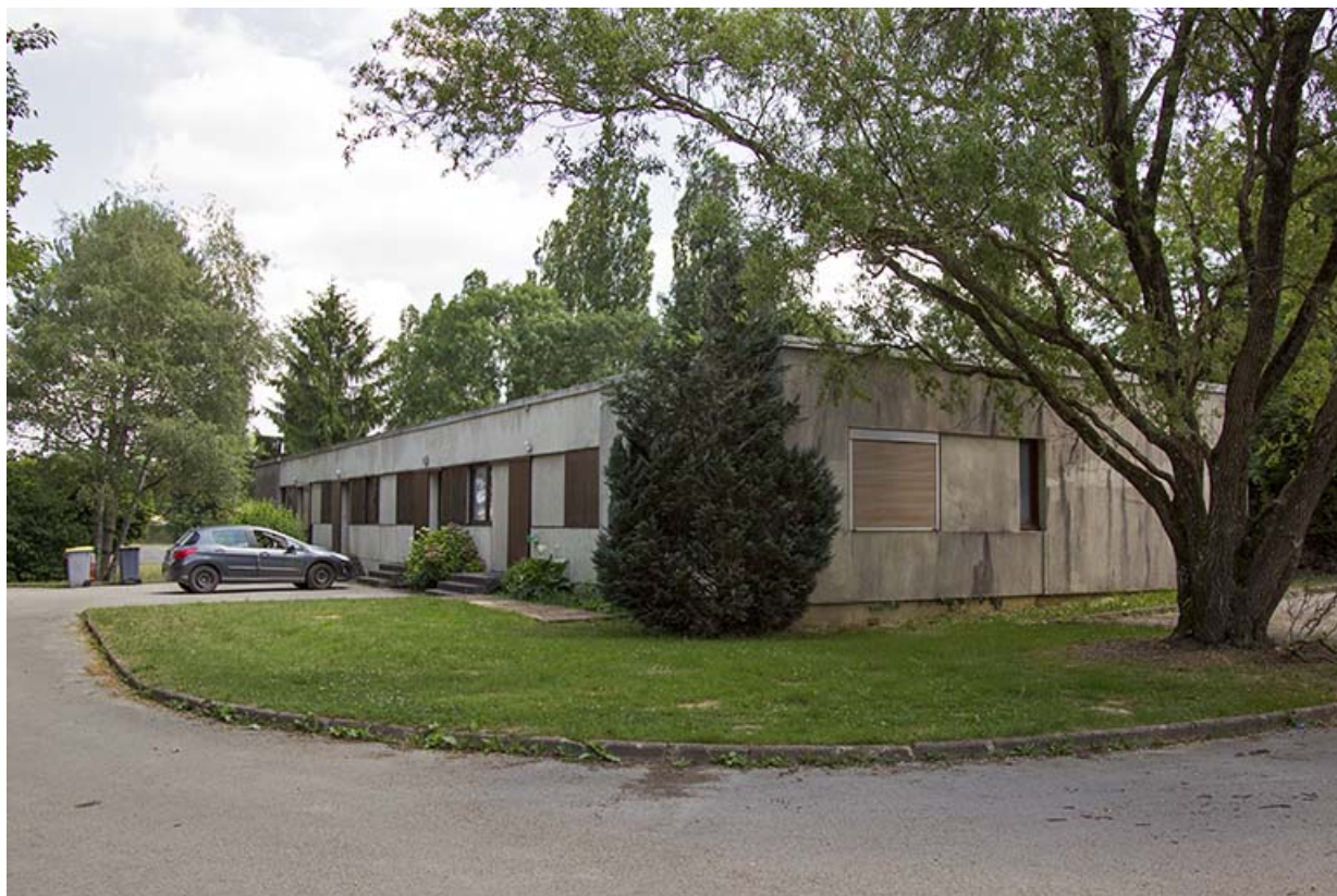
Angle nord-ouest des logements de fonction collectifs orientés est-ouest, situés au sud-ouest du parc. 25, Dannemarie-sur-Crète, 16 rue de Damprichard
