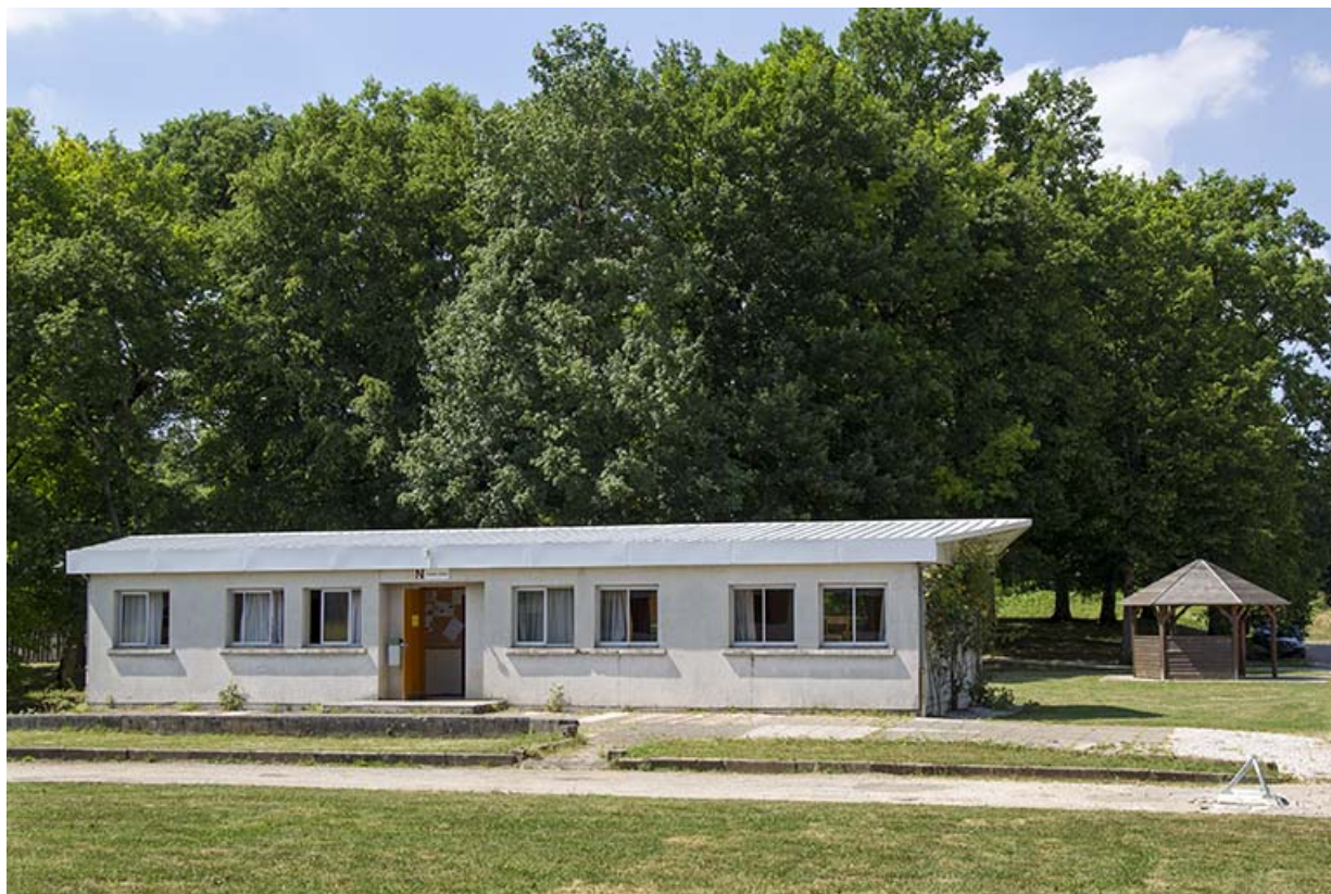
Façade sud des salles des classes préparatoires.
