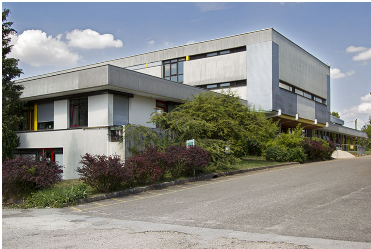
Façade sud et angle sud-ouest du bâtiment d'internat de garçons et d'externat. 25, Dannemarie-sur-Crète, 16 rue de Damprichard
