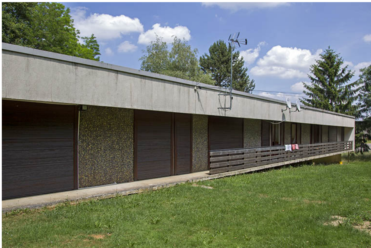
Façade sud des logements collectifs de fonction orientés est-ouest, situés au sud-ouest du parc. 25, Dannemarie-sur-Crète, 16 rue de Damprichard
