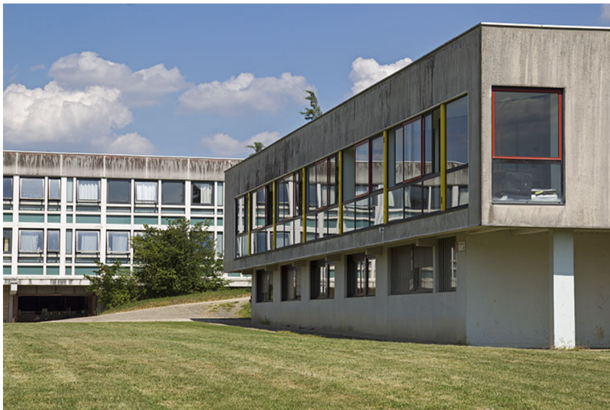
Angle nord-ouest du bâtiment d'internat de filles.
