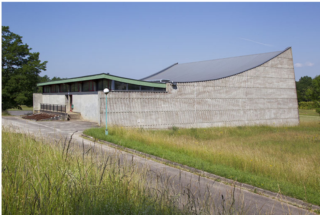
Flanc est du gymnase, vue de trois quart.
