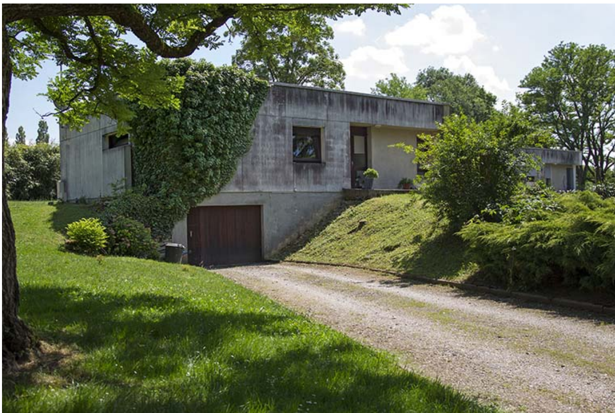
Détail de façade nord d'un logement individuel au nord-ouest.
