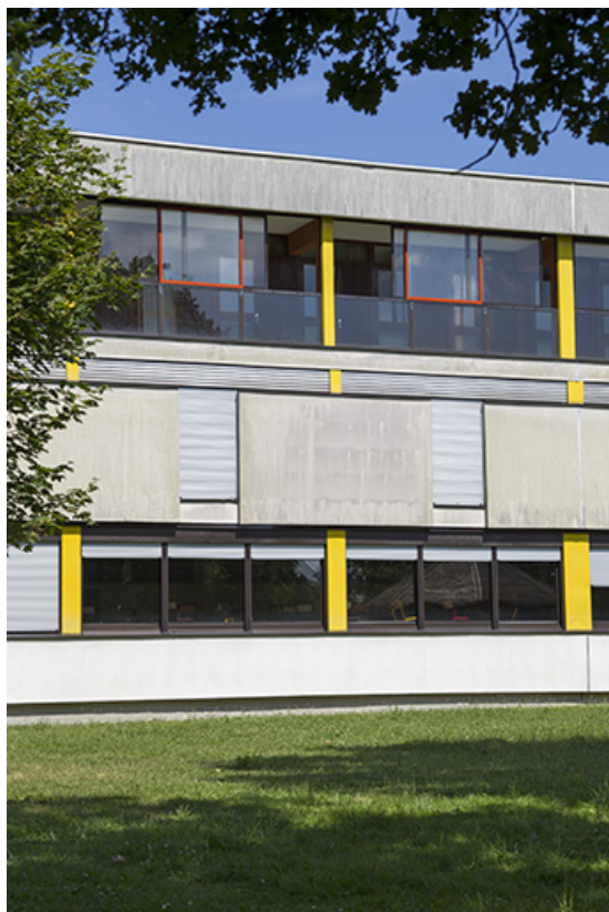
Détail de la façade ouest de l'internat de garçons - externat. 25, Dannemarie-sur-Crète, 16 rue de Damprichard
