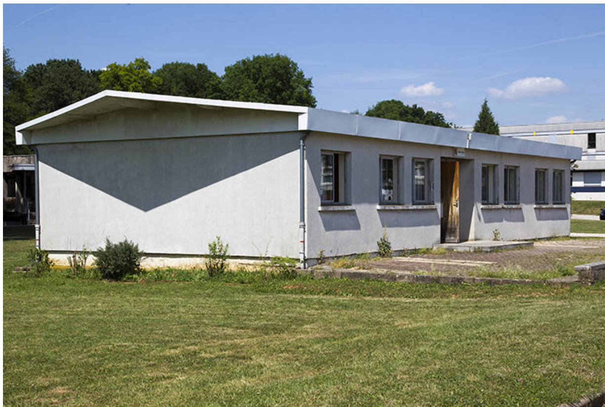
Pignon ouest et façade sud des salles des classes préparatoires.
