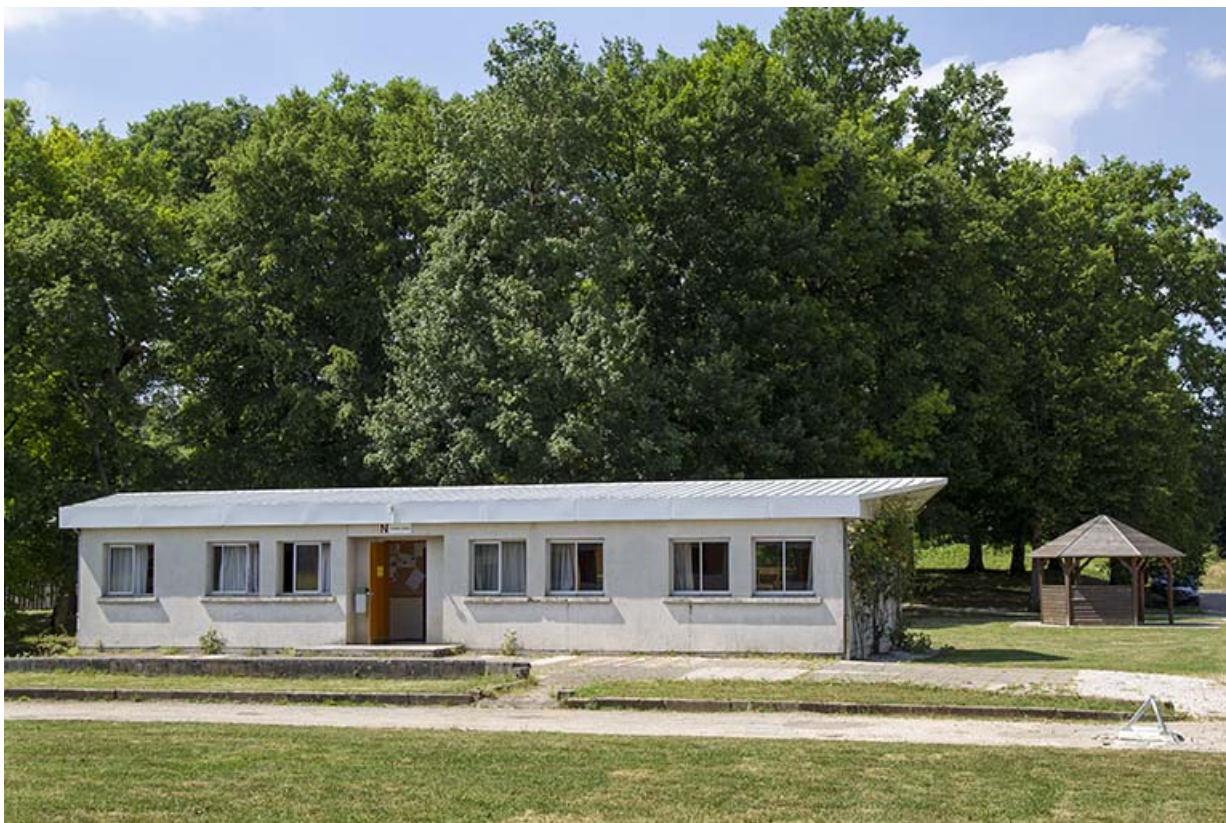
Façade sud des salles des classes préparatoires.
