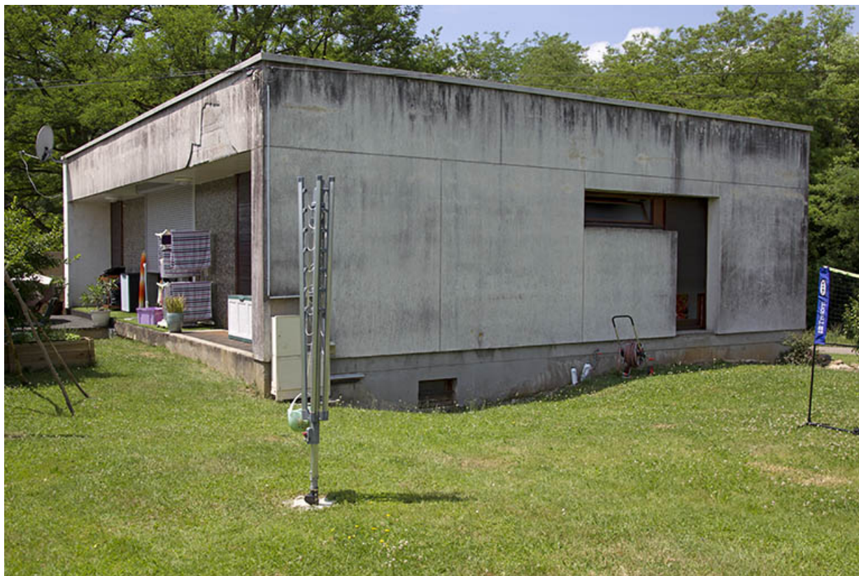
Angle sud-est, pignon est, façade postérieure - sud - d'un logement individuel au nord-ouest. 25, Dannemarie-sur-Crète, 16 rue de Damprichard
