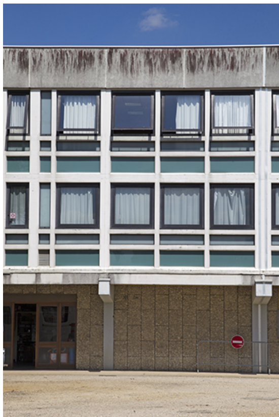
Détail de la façade postérieure - ouest - de l'externat. 25, Dannemarie-sur-Crète, 16 rue de Damprichard
