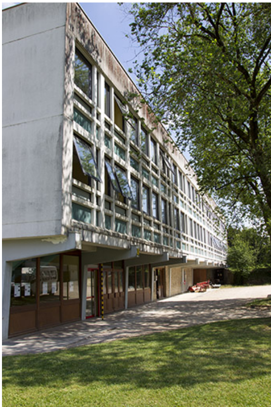
Vue de profil, du nord-ouest, de la façade postérieure - ouest - de l'externat. 25, Dannemarie-sur-Crète, 16 rue de Damprichard
