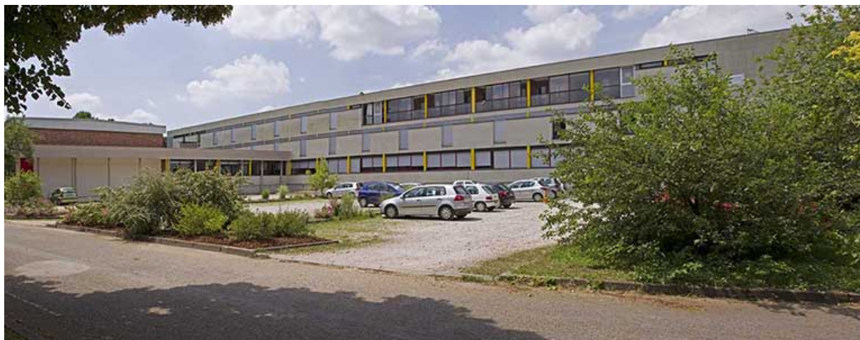
Façade orientale du bâtiment d'internat de garçons et d'externat.
