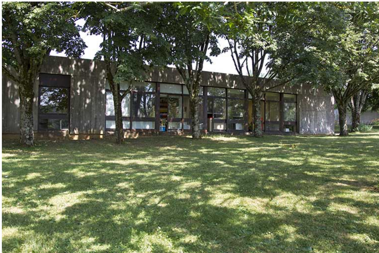
Façade postérieure - ouest - de l'administration.
