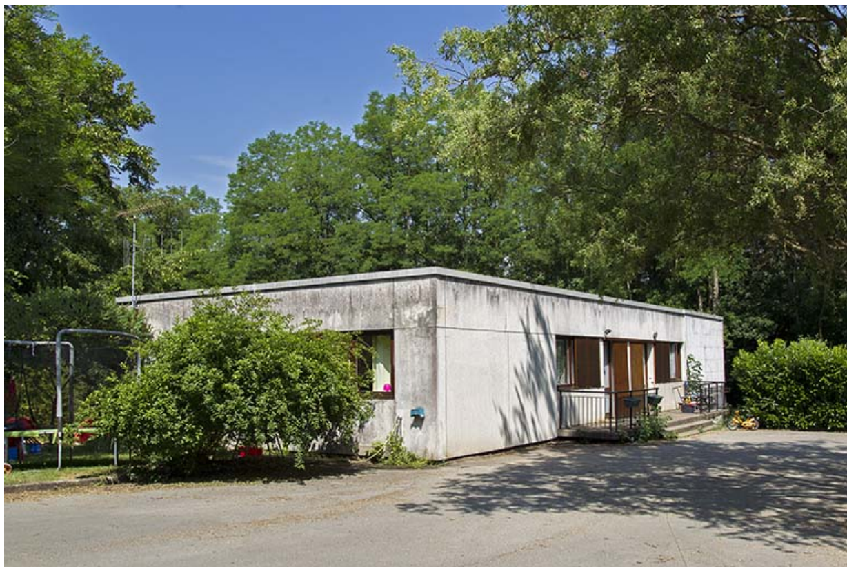
Angle sud-est des logements de fonction collectifs orientés nord sud, situés au sud-ouest du parc. 25, Dannemarie-sur-Crète, 16 rue de Damprichard
