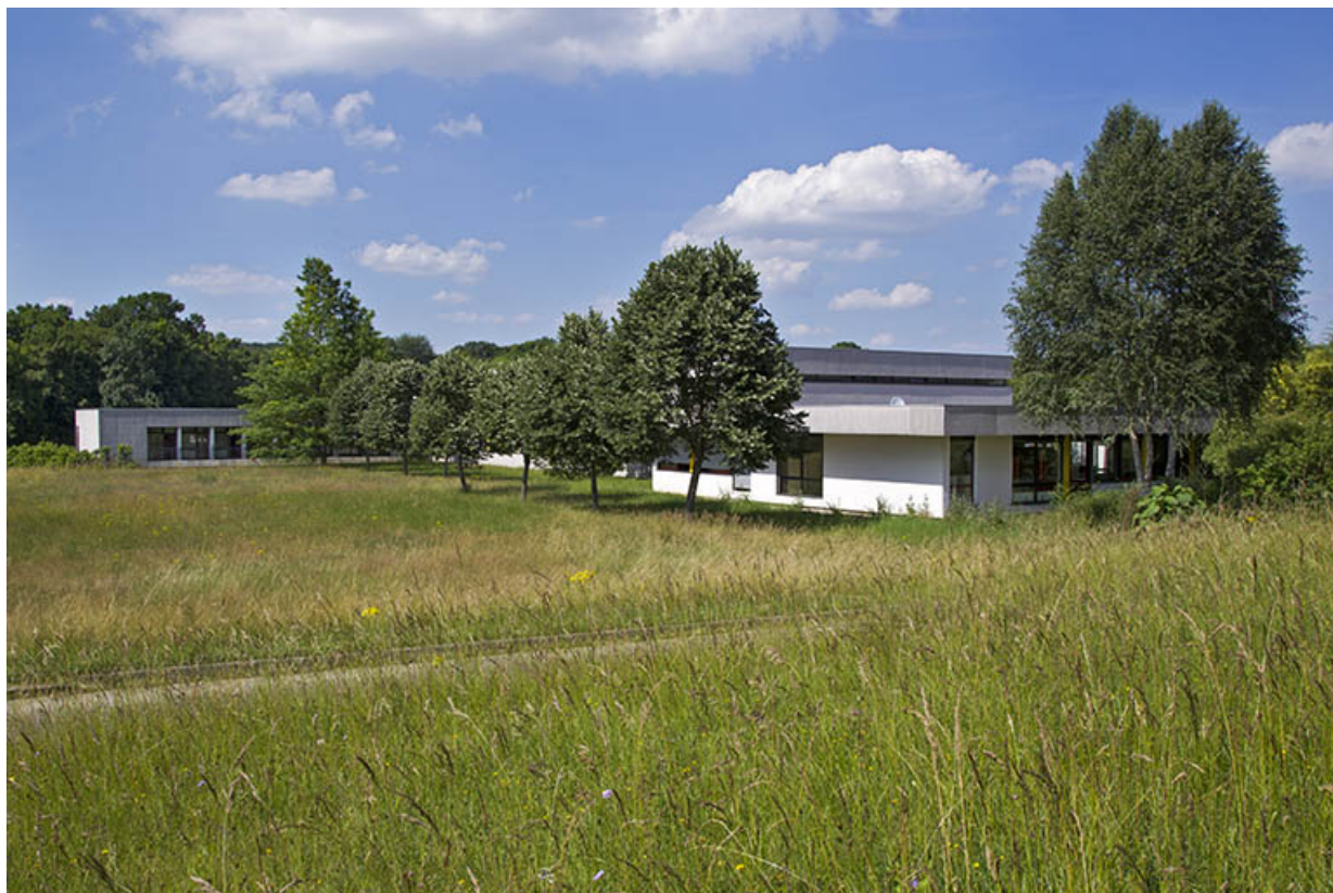
Angle sud-ouest de l'internat de filles et centre de documentation et d'information.
