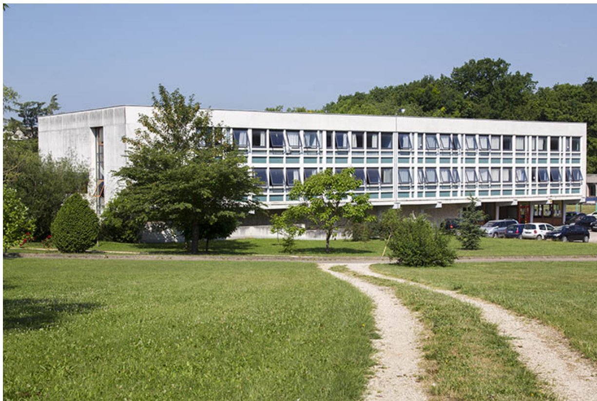
Pignon sud et façade antérieure - est - de l'externat.
