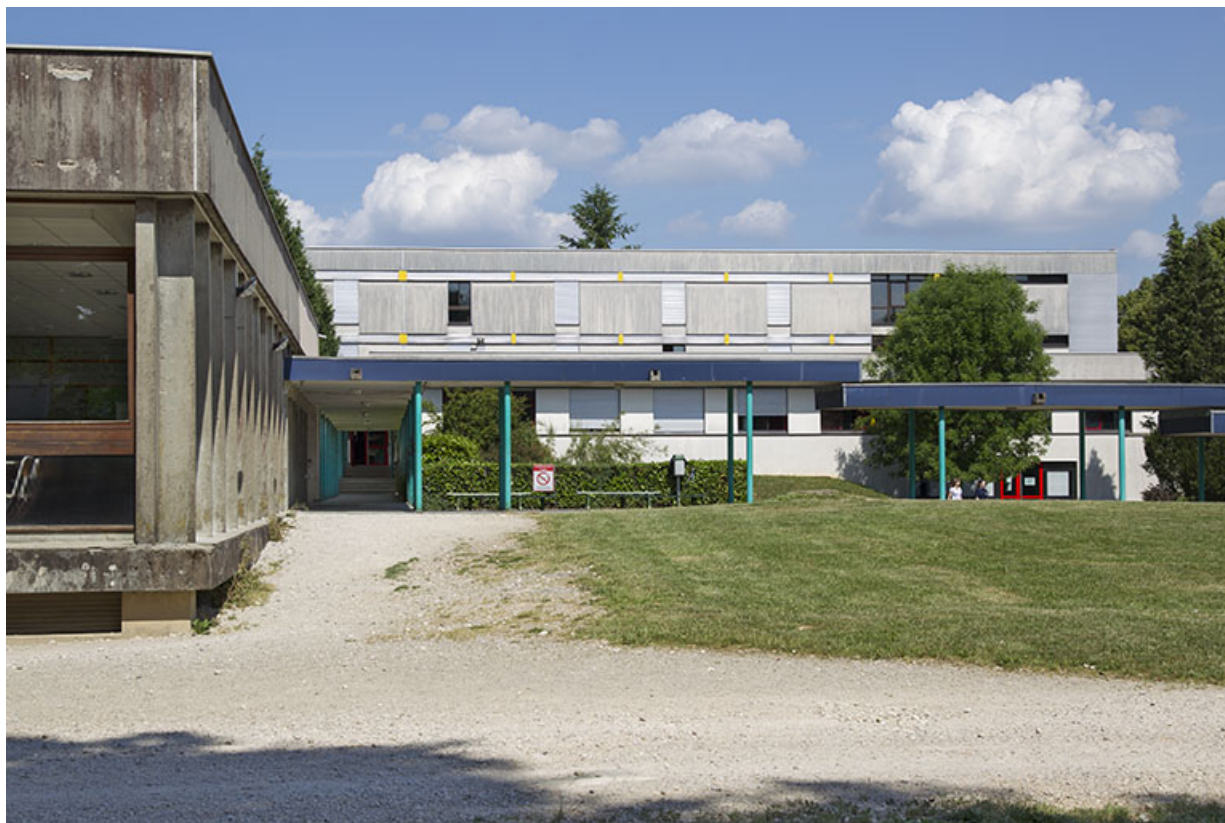
Le long de la façade sud de la cantine, face à la façade ouest du bâtiment d'internat de garçons et d'externat. 25, Dannemarie-sur-Crète, 16 rue de Damprichard
