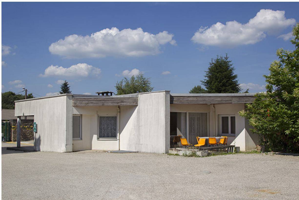
Façade postérieure ouest de la loge.
