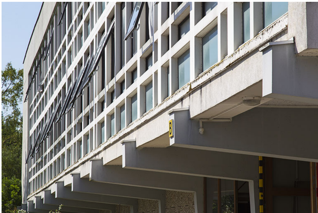
Détail de façade postérieure - ouest - de l'externat.
