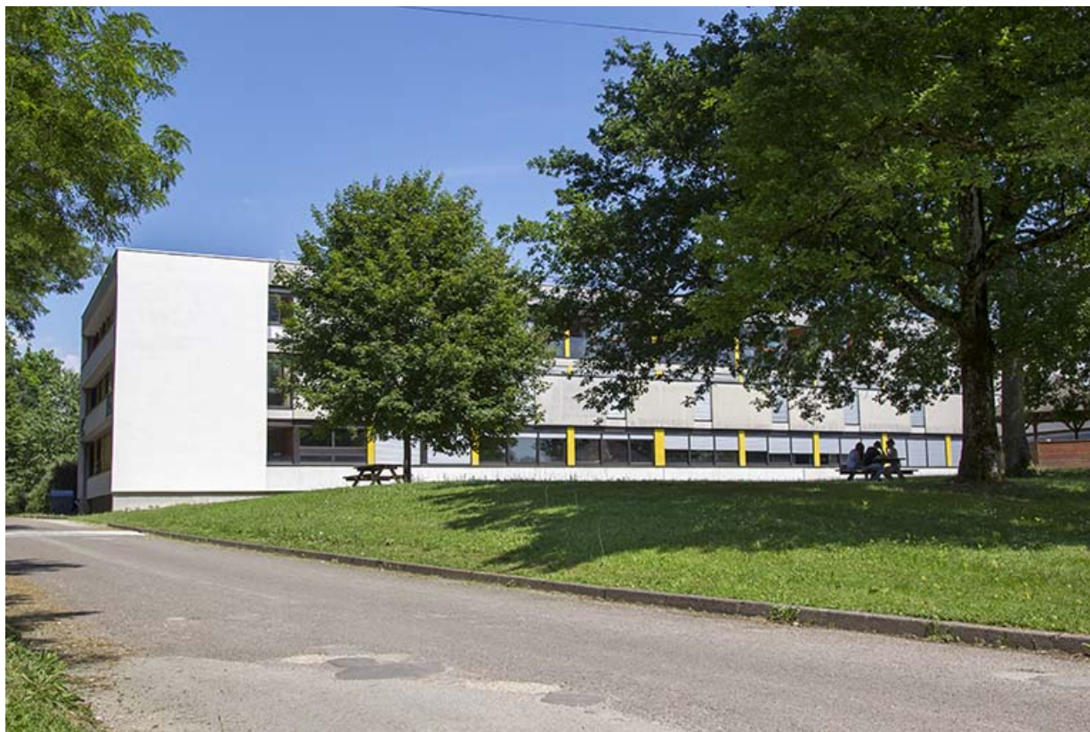
Façade ouest de l'internat de garçons - externat et kiosque.
