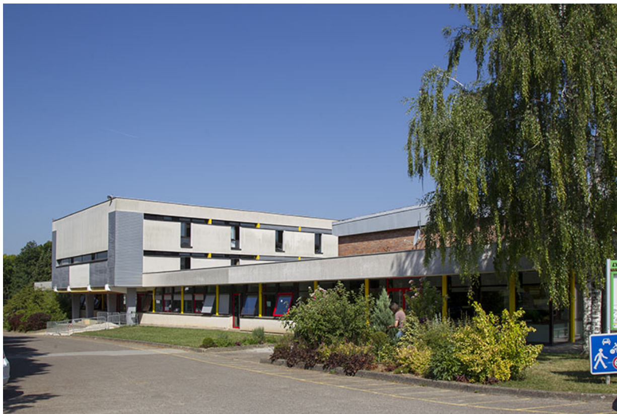
Façade sud et angle sud-est du bâtiment d'internat de garçons et d'externat. 25, Dannemarie-sur-Crète, 16 rue de Damprichard
