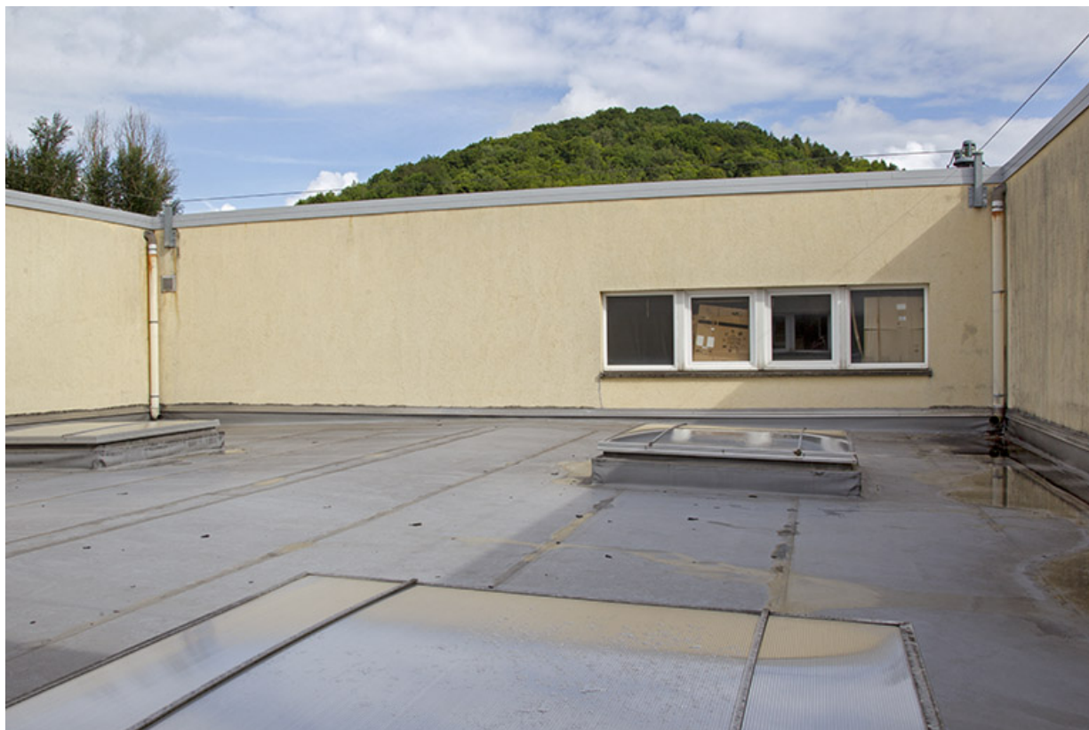
Vue du premier étage de la terrasse intérieure de l'atelier d'électronique, d'électrotechnique et d'ascensoriste. 25, Baume-les-Dames, 16 rue de l' Helvétie
