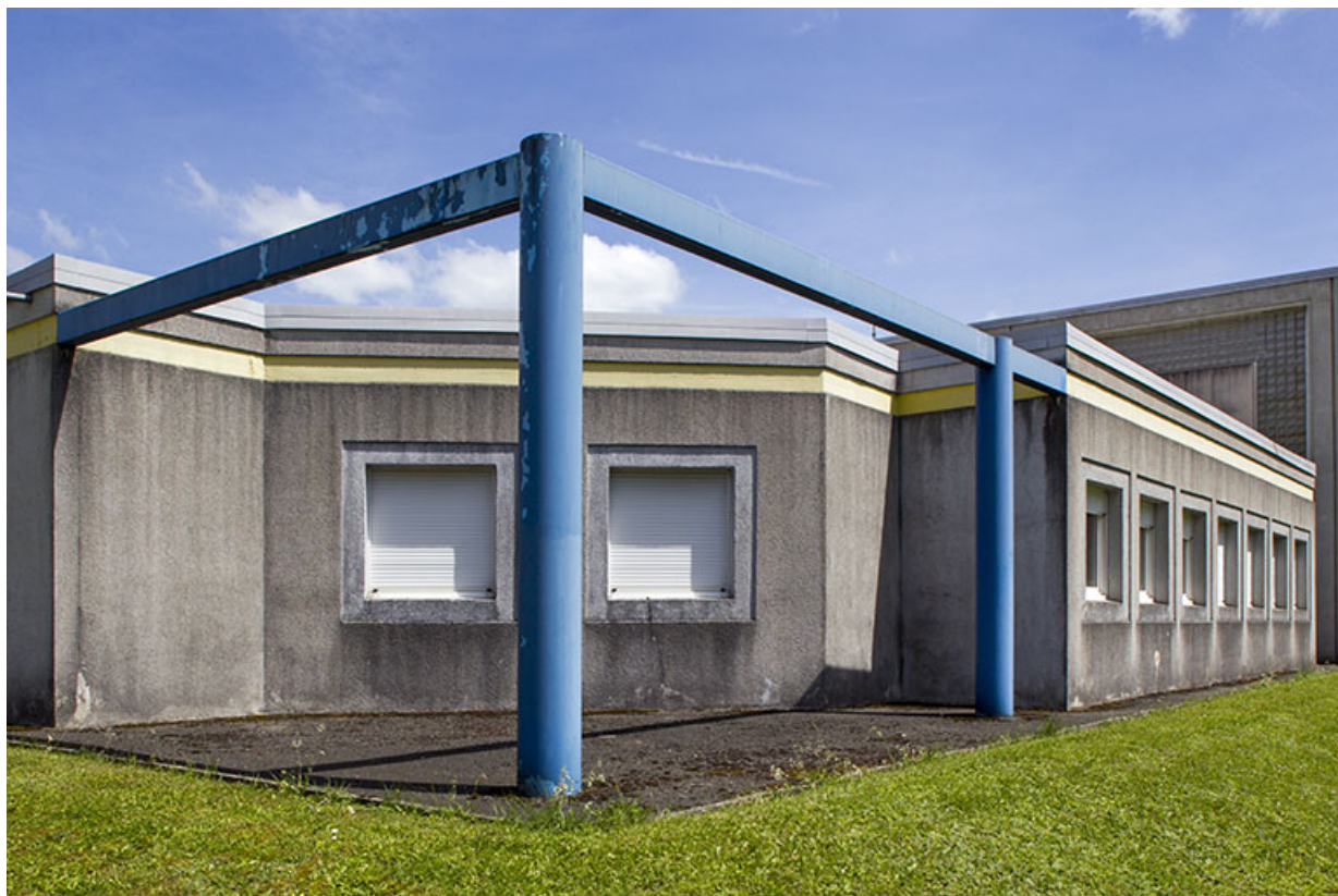
Vue rapprochée de l'angle nord-ouest du bâtiment dédié aux métiers de la construction.
