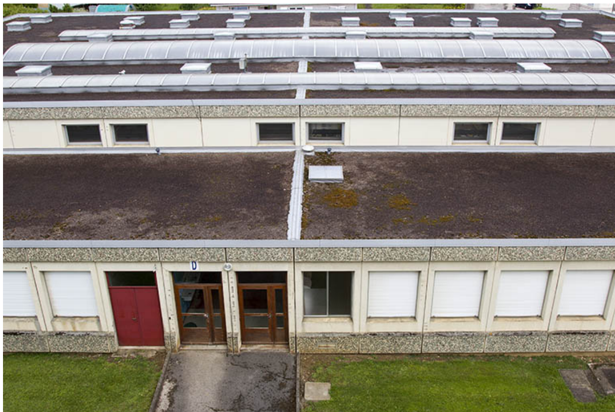
Vue sur la terrasse de l'atelier dédié aux métiers de la maintenance.
