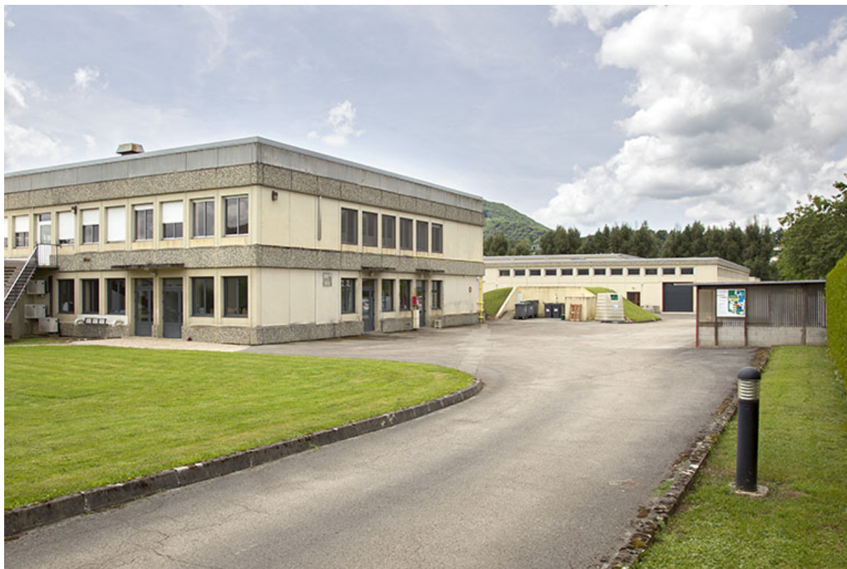
Angle nord de la restauration et atelier de maintenance.
