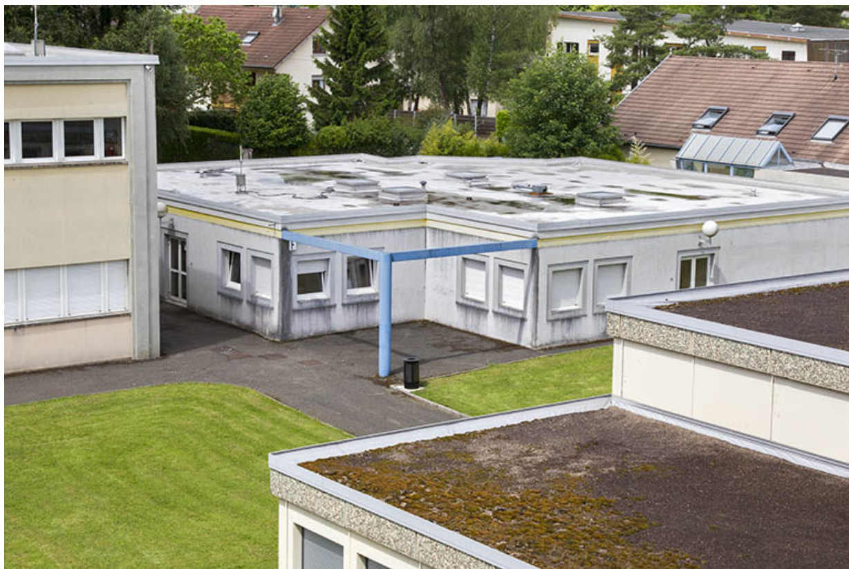
Angle sud-est du bâtiment dédié aux métiers de la construction.
