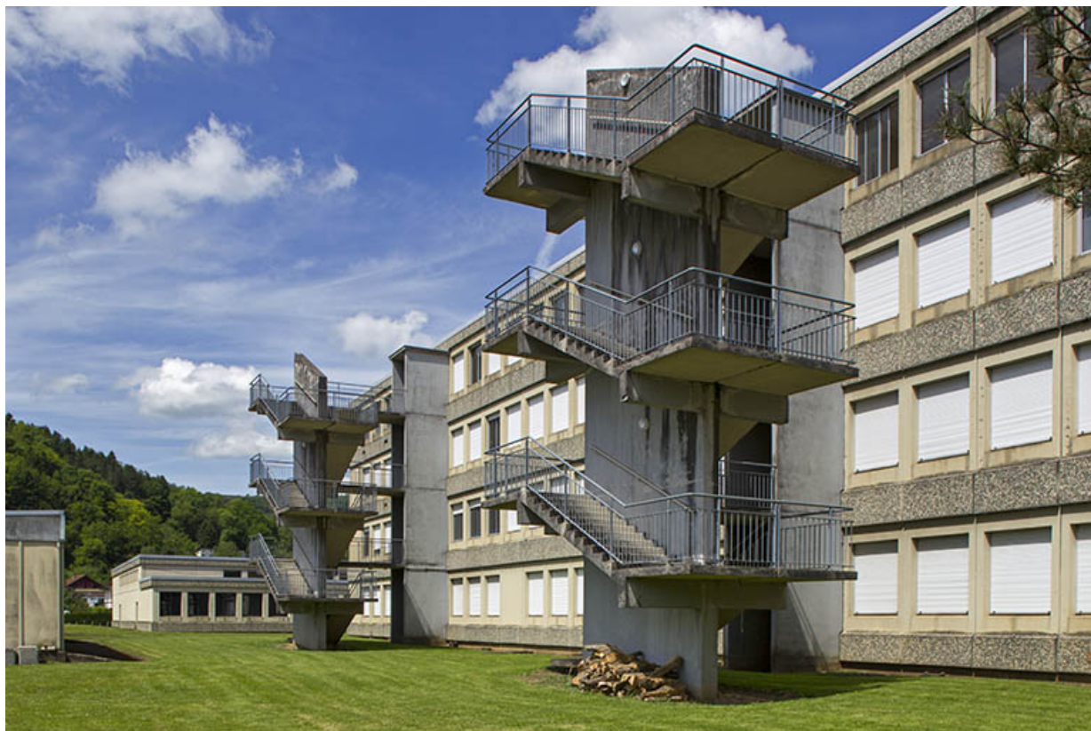
Les deux escaliers de secours sur la façade postérieure ouest de l'internat, vus du sud. 25, Baume-les-Dames, 16 rue de l' Helvétie
