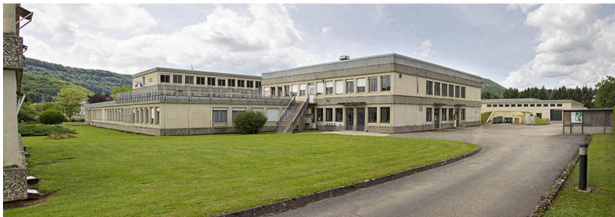
Vues d'ensemble du nord-est à côté des logements : la restauration, l'administration, l'atelier de maintenance. 25, Baume-les-Dames, 16 rue de l' Helvétie
