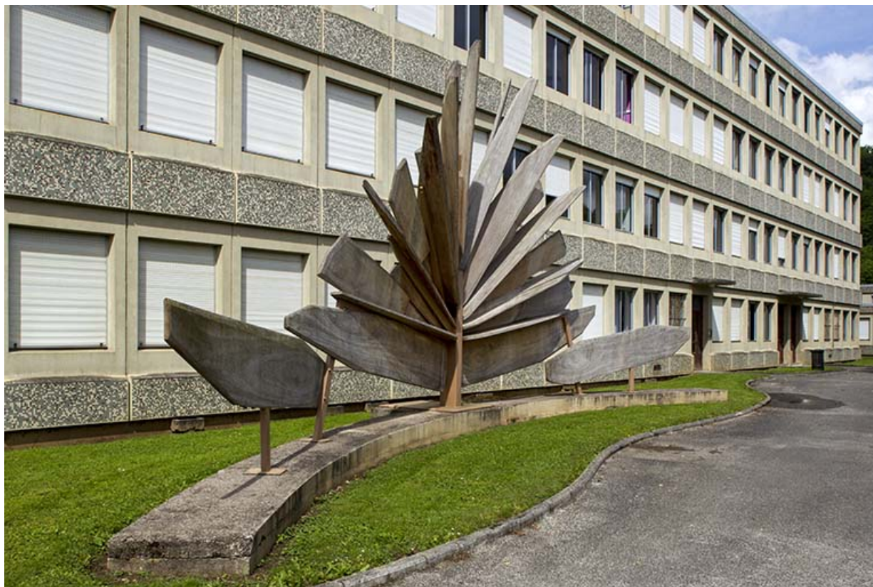
Vue rapprochée de la façade antérieure est de l'internat et sa sculpture.
