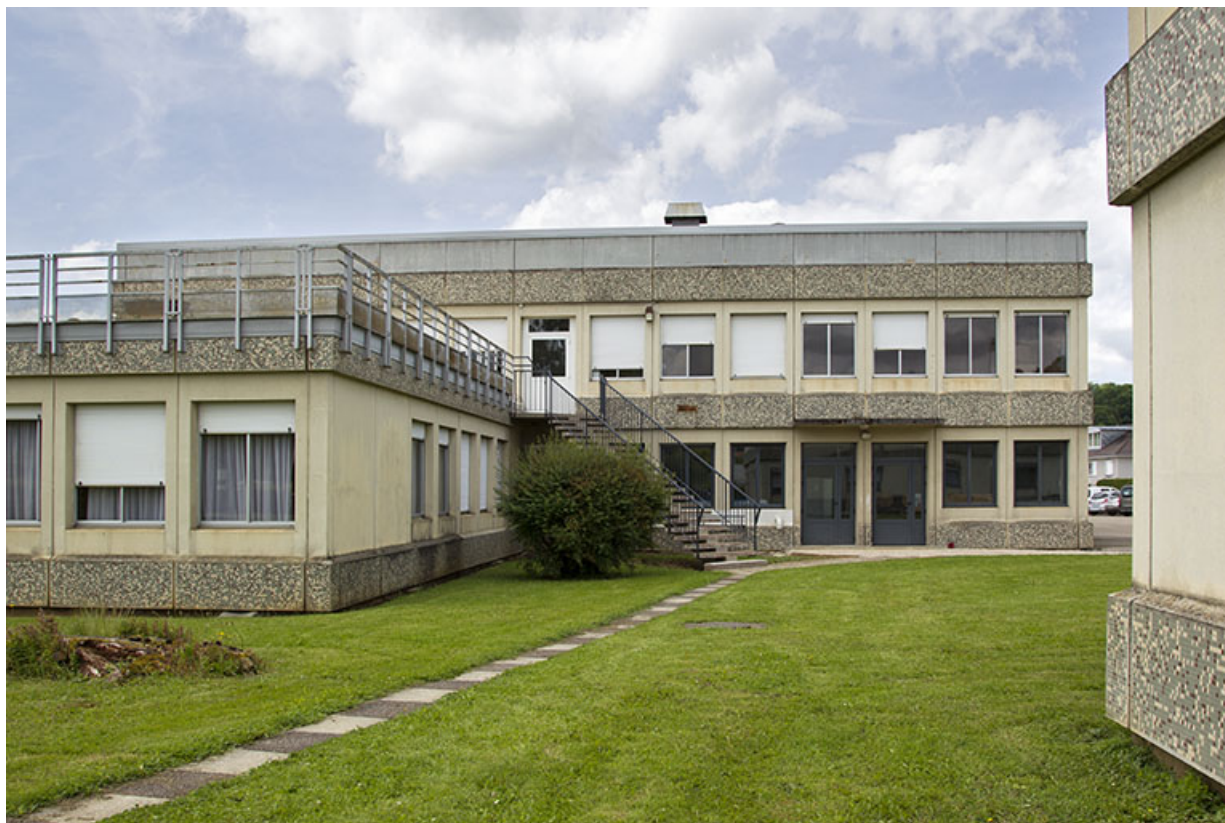
Vue rapprochée de la restauration, depuis les logements.
