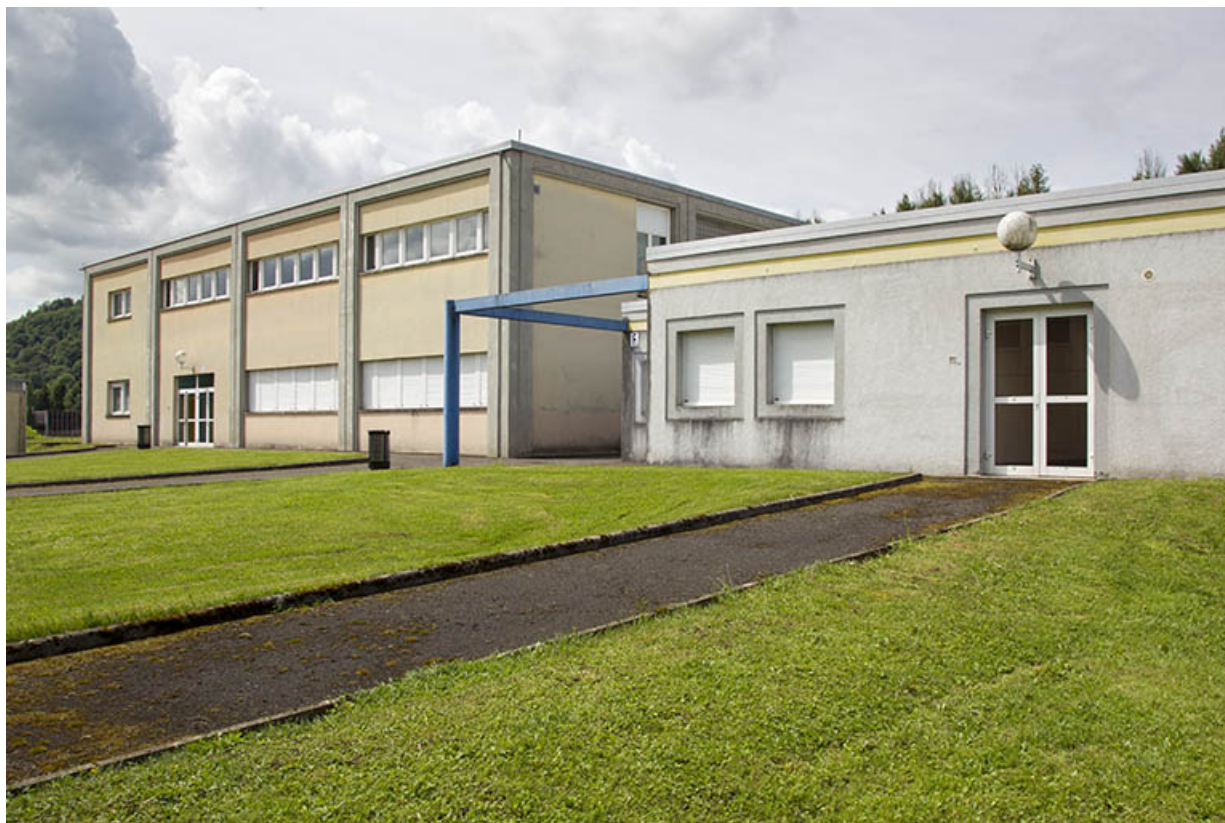
Façades nord-est des bâtiment dédié aux métiers de la construction et de l'atelier d'électronique, électrotechnique et ascensoriste. 25, Baume-les-Dames, 16 rue de l' Helvétie
