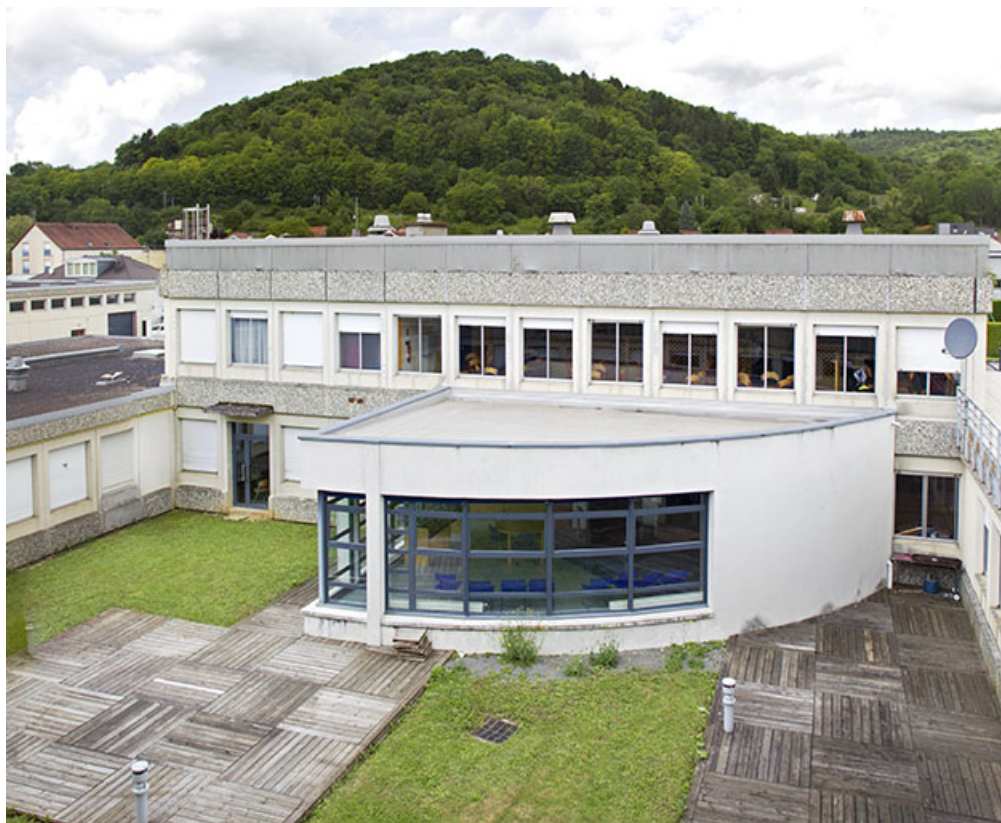
Vue sur la cour intérieure des bâtiments d'externat et de restauration.
