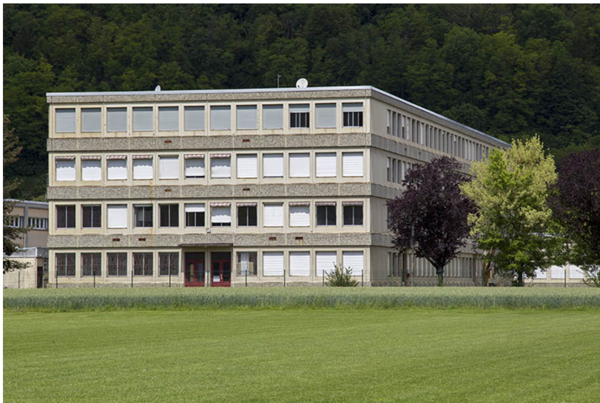
Façade antérieure est de l'internat et pignon sud, vus du sud.
