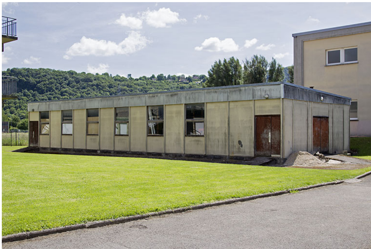
Dernier préfabriqué provisoirement encore en place, à usage de stockage.
