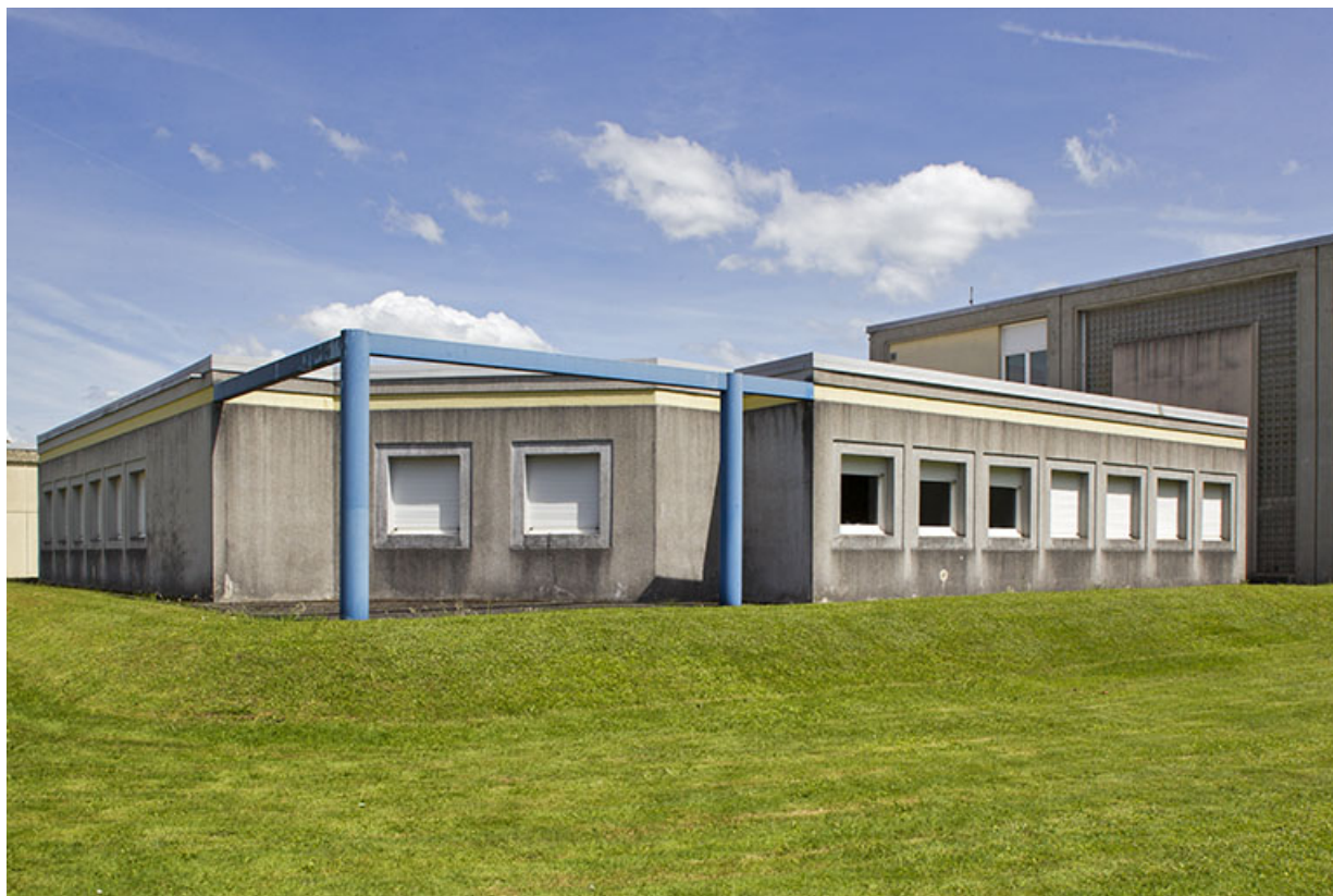
Angle nord-ouest du bâtiment dédié aux métiers de la construction.
