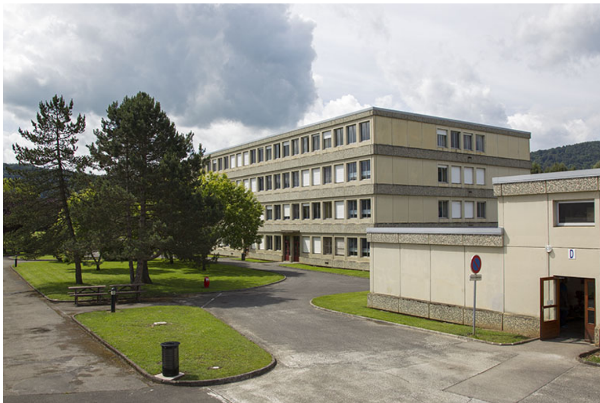
Au premier plan façade nord-est de l'atelier de maintenance et angle nord de l'internat au second plan. 25, Baume-les-Dames, 16 rue de l' Helvétie
