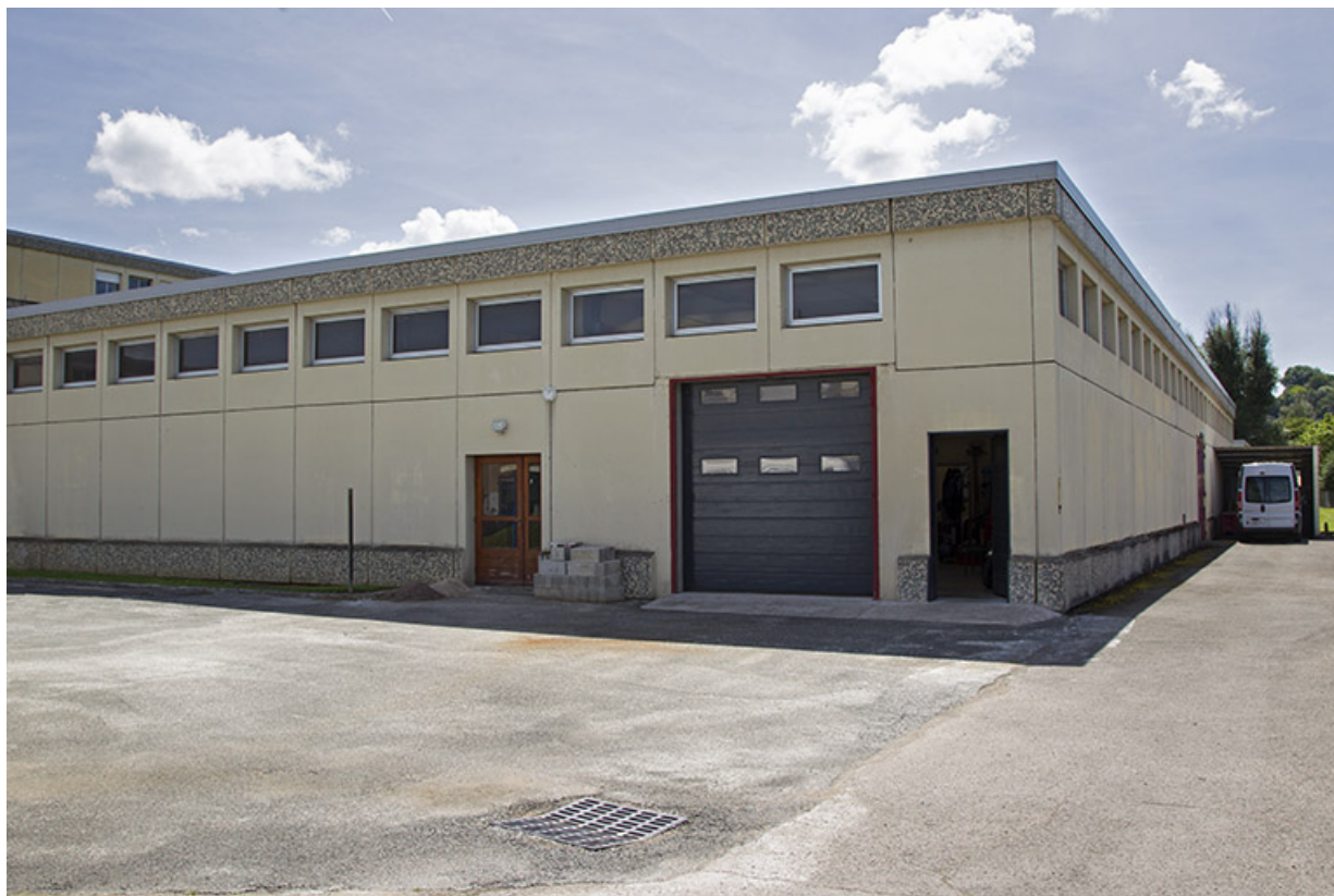
Angle nord de l'atelier dédié aux métiers de la maintenance.
