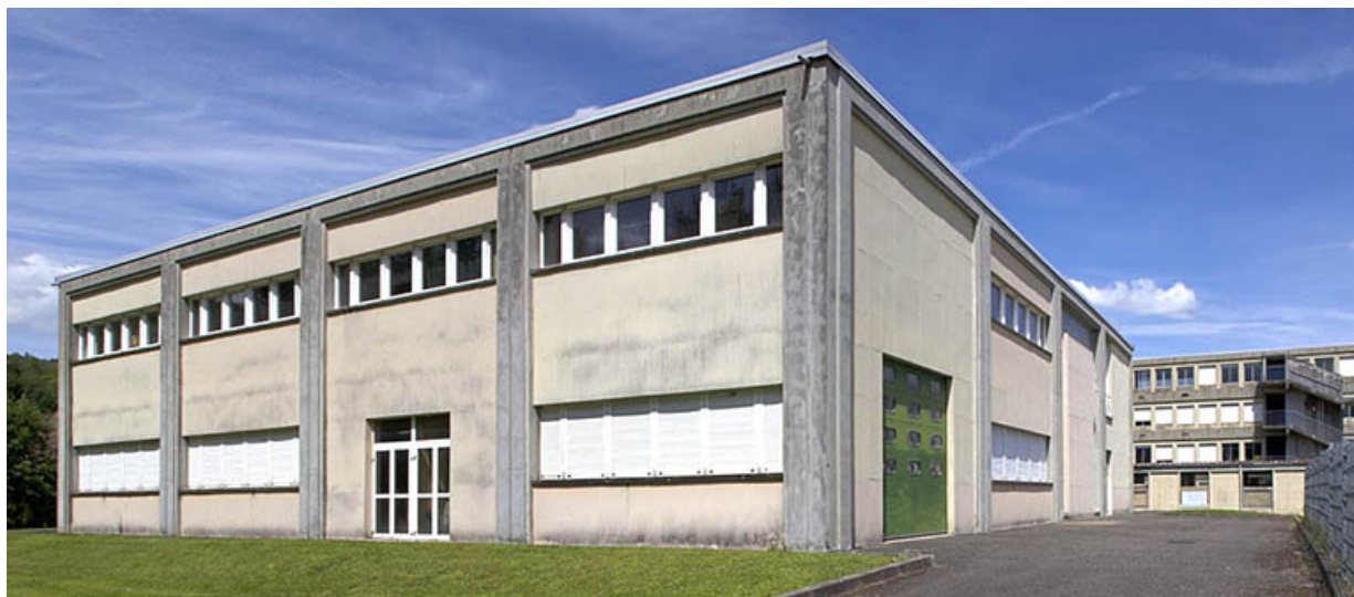
Angle sud-ouest de l'atelier d'électrotechnique, d'électronique et d'ascensoriste.
