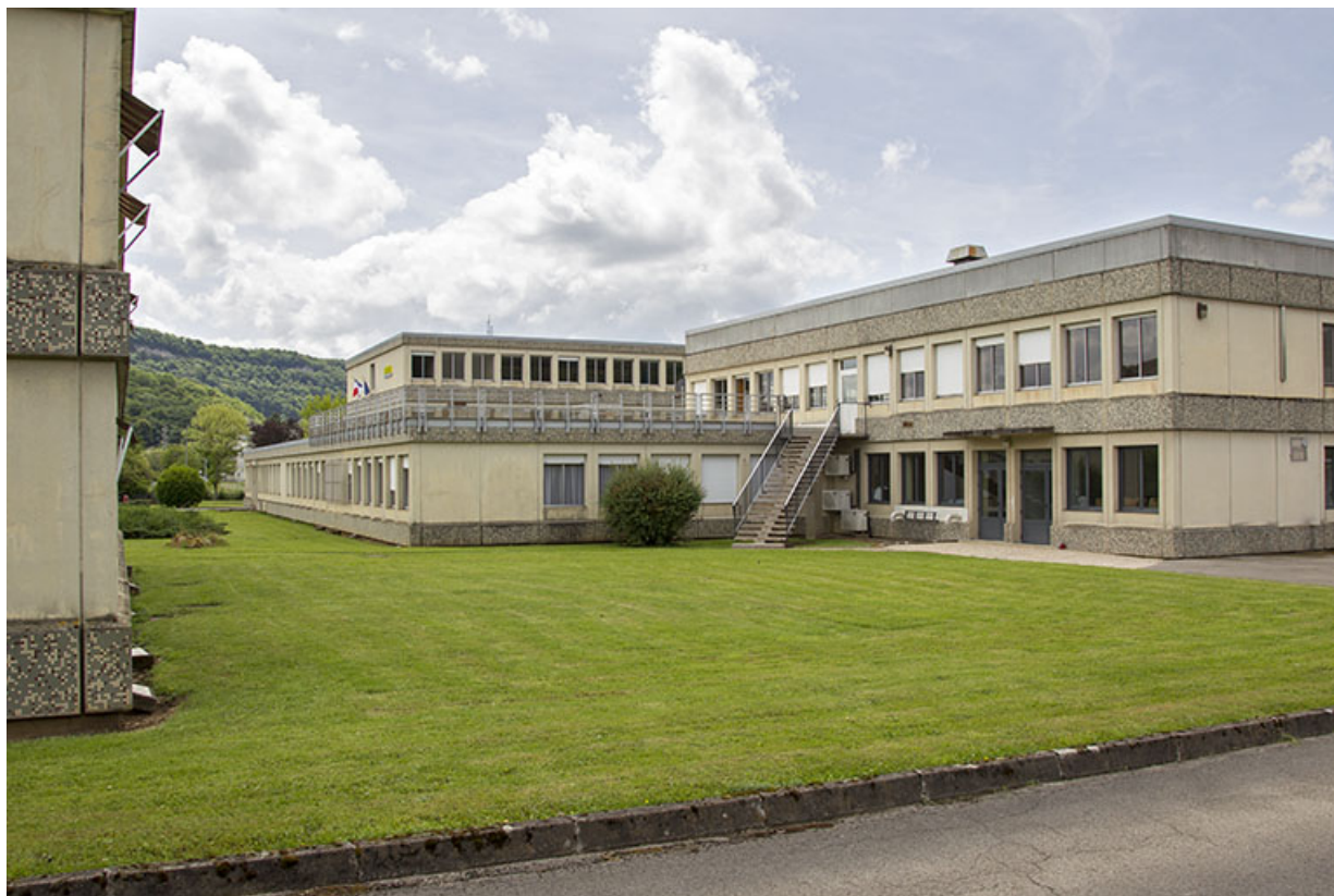
Vues du nord-est à côté des logements, la restauration et l'administration.
