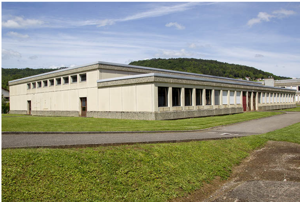
Angle sud ouest de l'atelier dédié aux métiers de la maintenance.
