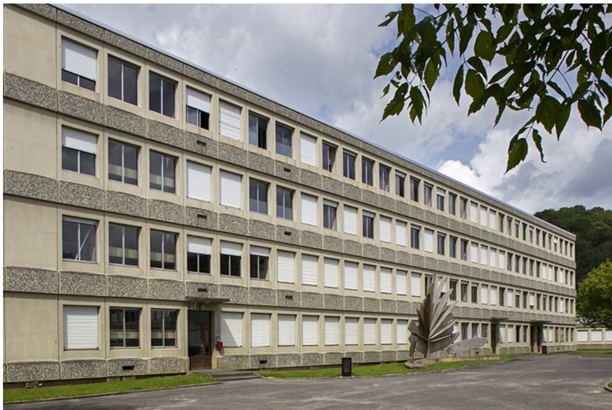
Façade antérieure est de l'internat et sa sculpture.
