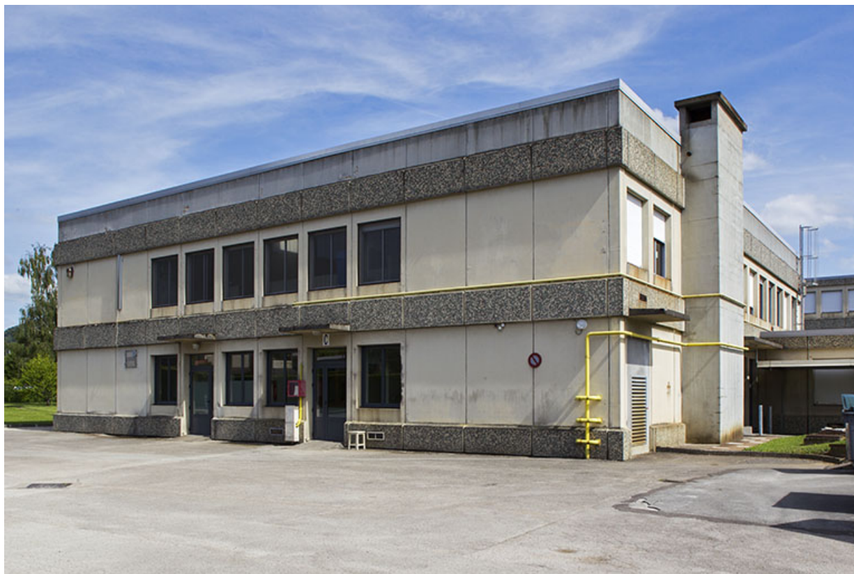
Façade nord du bâtiment de restauration.
