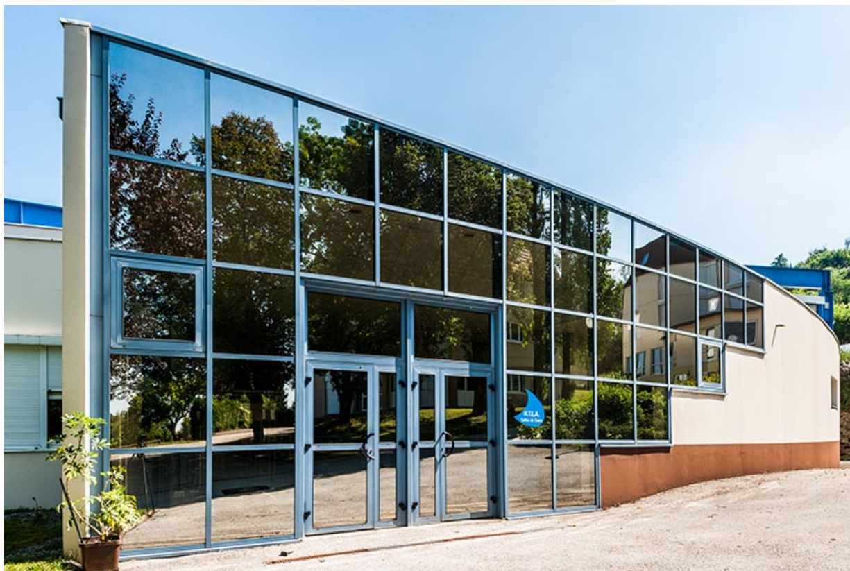
Détail de l'entrée principale sur la façade sud du hall des technologies laitières et agro-alimentaires. 25, Mamirolle, 15 Grande Rue
