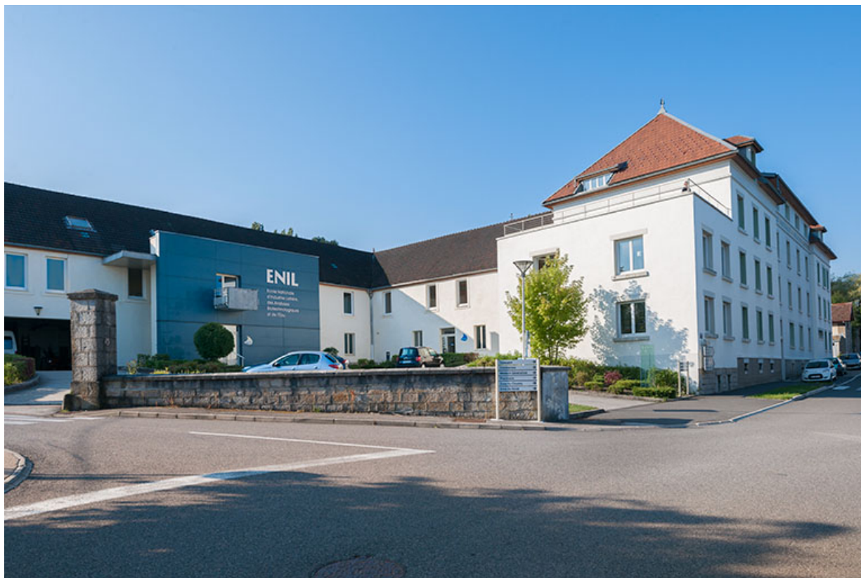
Cour d'entrée, pignon nord-est du bâtiment d'administration et d'externat et sa façade sur rue. 25, Mamirolle, 15 Grande Rue
