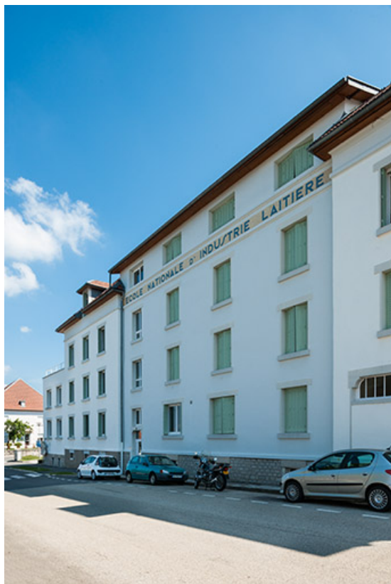
Détail de la façade sur rue du bâtiment d'administration et d'externat. 25, Mamirolle, 15 Grande Rue
