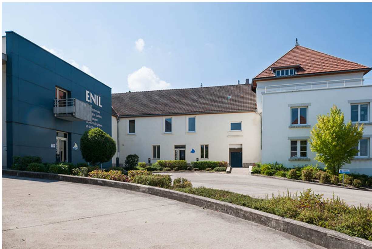
Cour, stationnement et pignon est du bâtiment d'administration et d'externat. 25, Mamirolle, 15 Grande Rue
