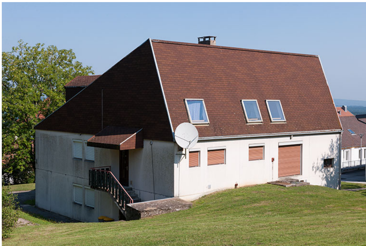
Façade postérieure et angle sud du centre de documentation et d'information. 25, Mamirolle, 15 Grande Rue
