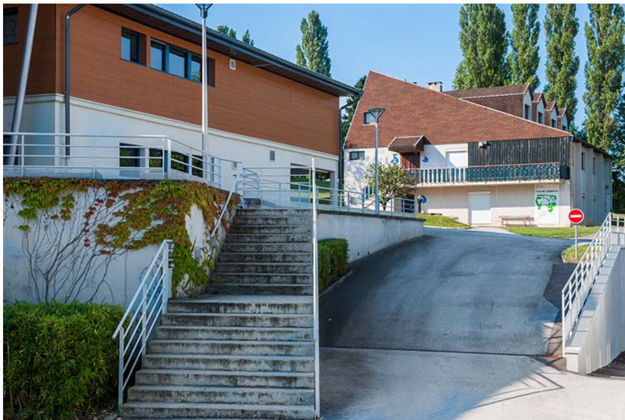
Escalier, angle ouest du bâtiment des salles de cours et laboratoires et façade nord-est du centre de documentation et d'information.
