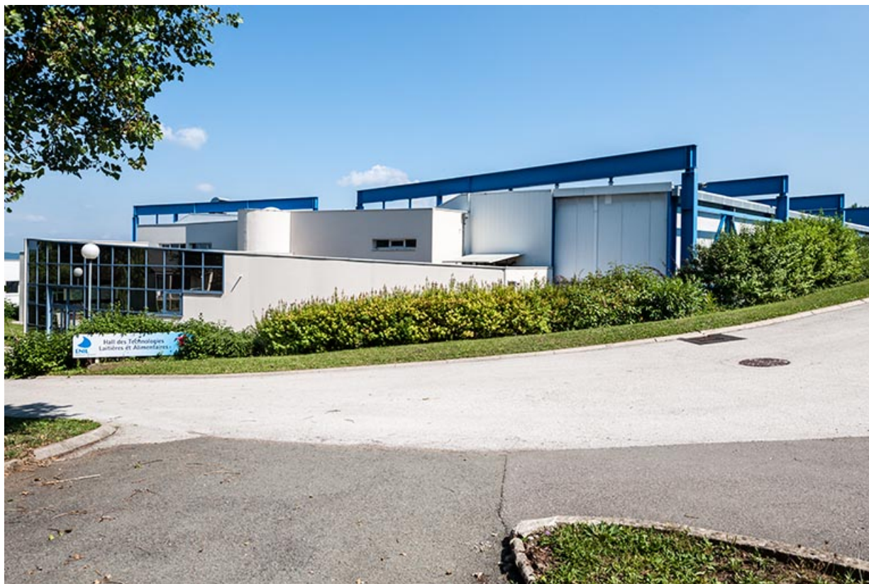
Façade ouest, entrée des salles de cours du hall des technologies laitières et agro-alimentaires. 25, Mamirolle, 15 Grande Rue
