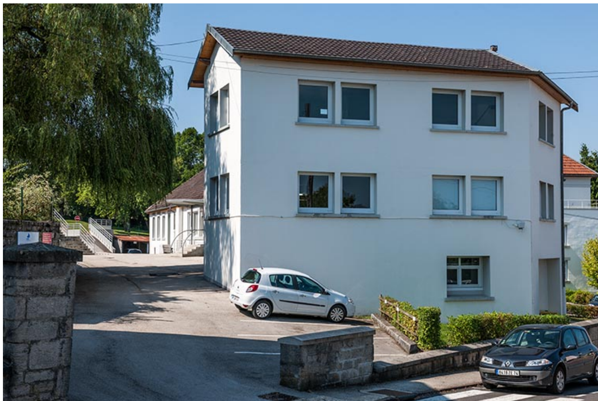
Pignon est du bâtiment d'administration et d'externat.
