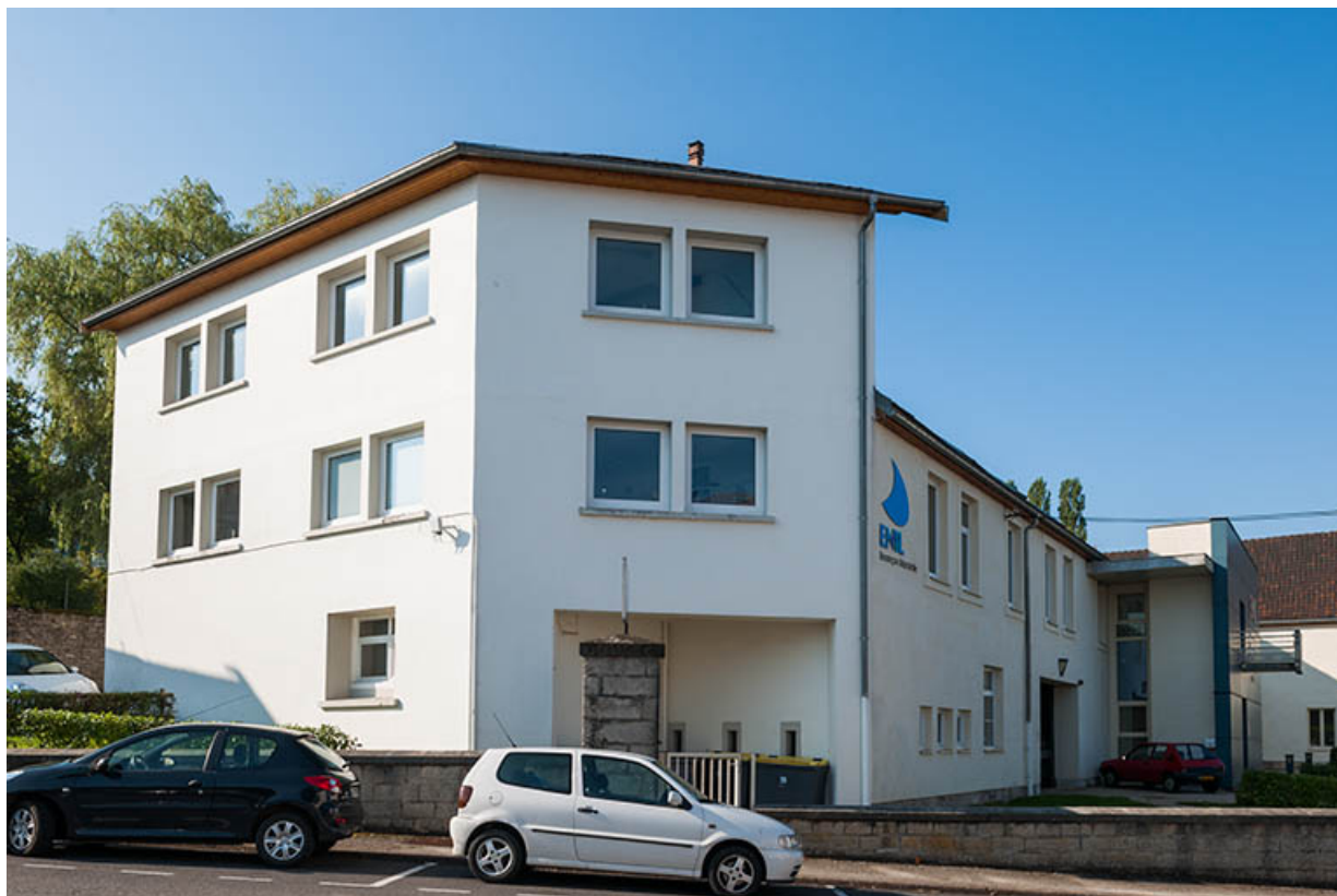
Pignon est du bâtiment d'administration et d'externat.
