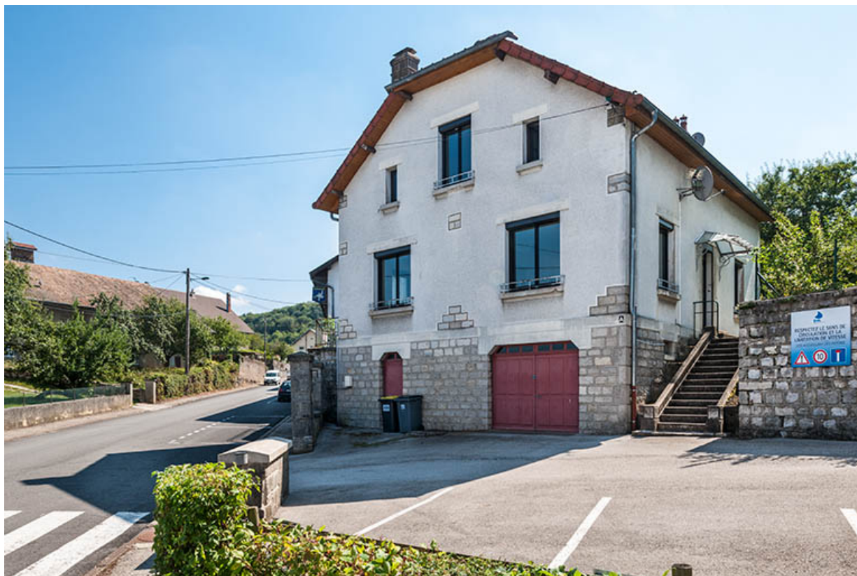
Façade antérieure sur rue du pavillon du directeur. 25, Mamirolle, 15 Grande Rue
