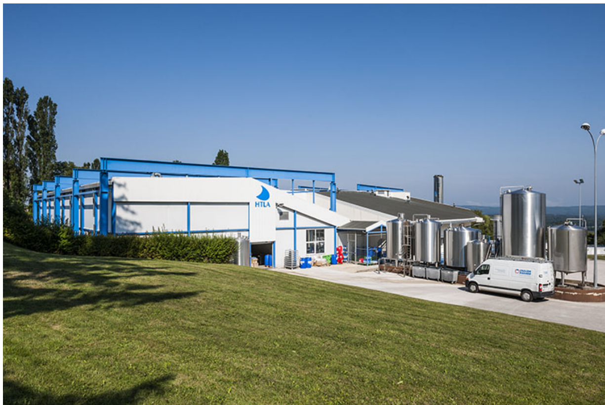
Angle sud-est du hall des technologies laitières et agro-alimentaires. 25, Mamirolle, 15 Grande Rue
