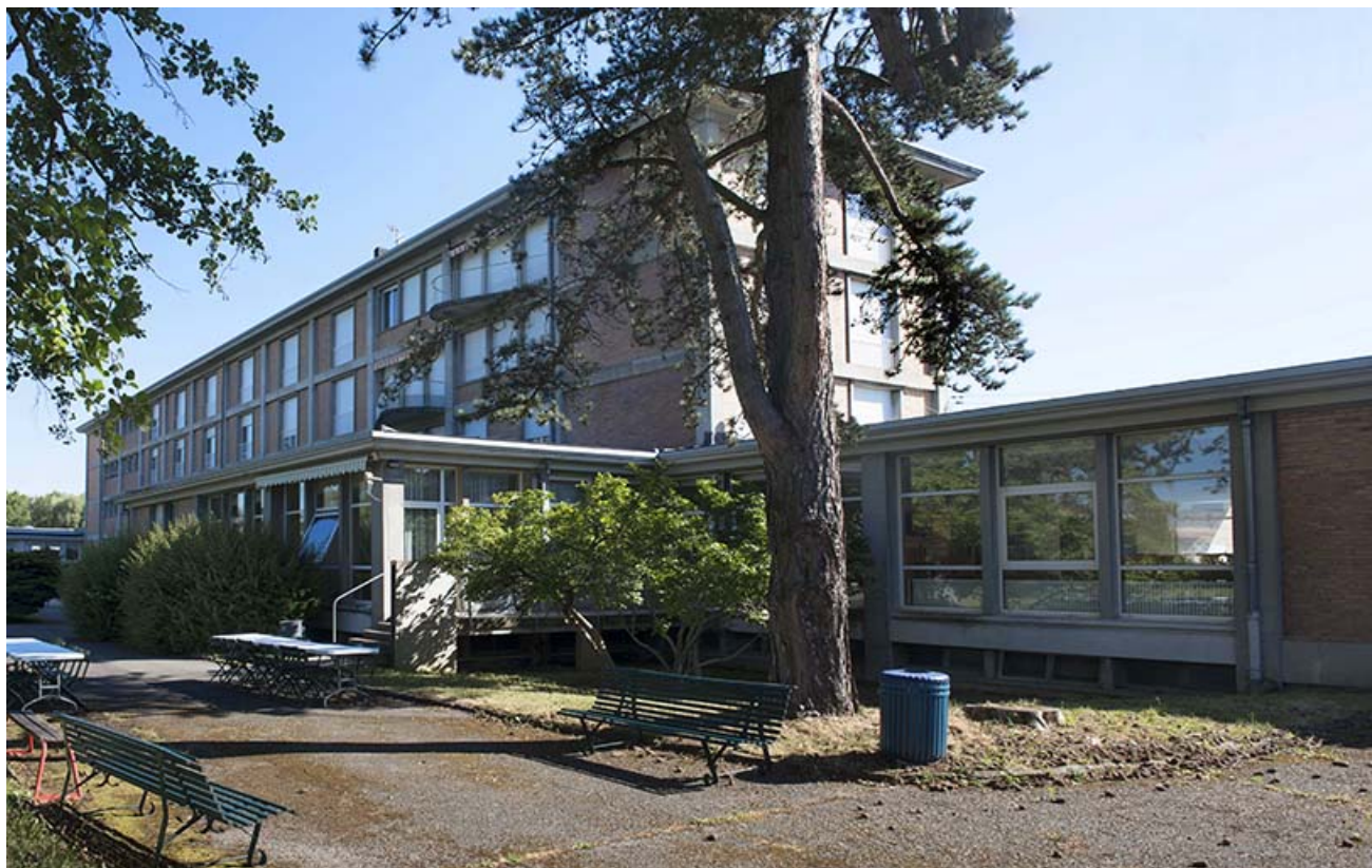
Détail de l'aile sud du bâtiment restauration et salles à manger en rez-de-chaussée. (ex-Léger) 25, Audincourt, 6 rue René Girardot
