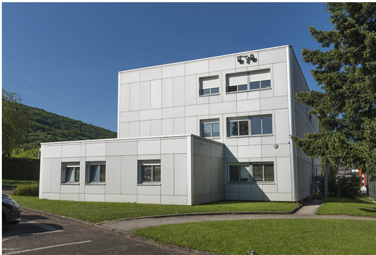
Détail de la façade est du bâtiment d'administration et logements.
