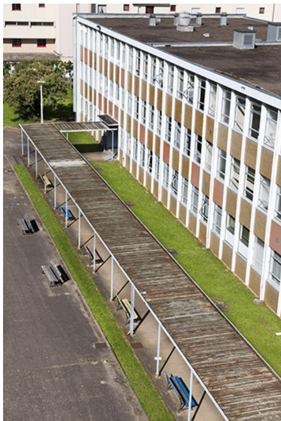
Façade antérieure sud du bâtiment d'internat vu depuis le bâtiment d'enseignement professionnel. 25, Besançon, 13 rue Goya
