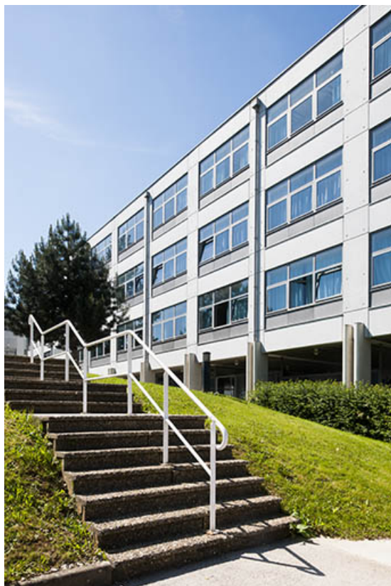
Détail de la façade postérieure est du bâtiment d'enseignement professionnel. 25, Besançon, 13 rue Goya
