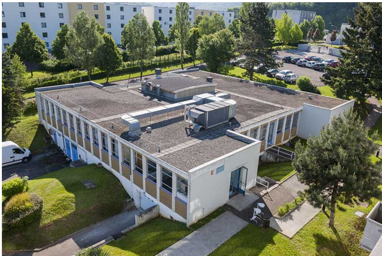
Angle nord-ouest du bâtiment de restauration.
