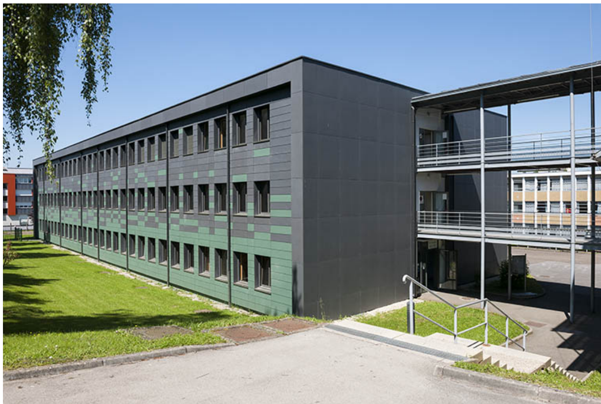
Façade sud et pignon est de l'externat.
