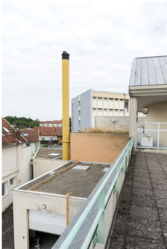
Depuis la terrasse, vue sur l'extrémité sud des bâtiments et la chaufferie.
