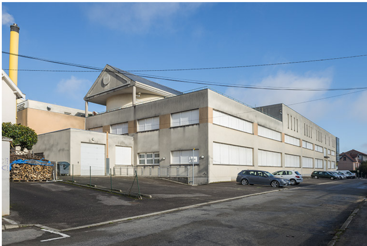
Façade sud-est le long de la rue de la prévoyance.
