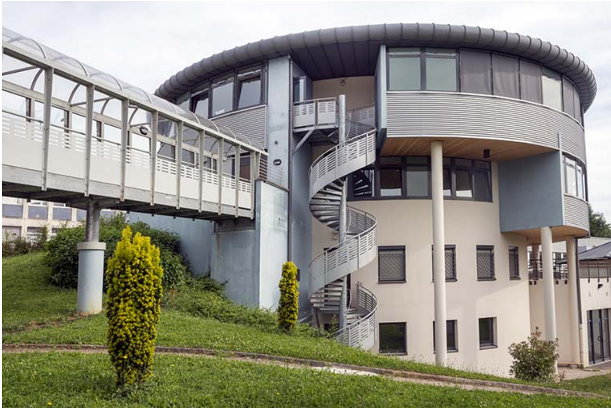
Passerelle, tour et son escalier au sud-ouest.
