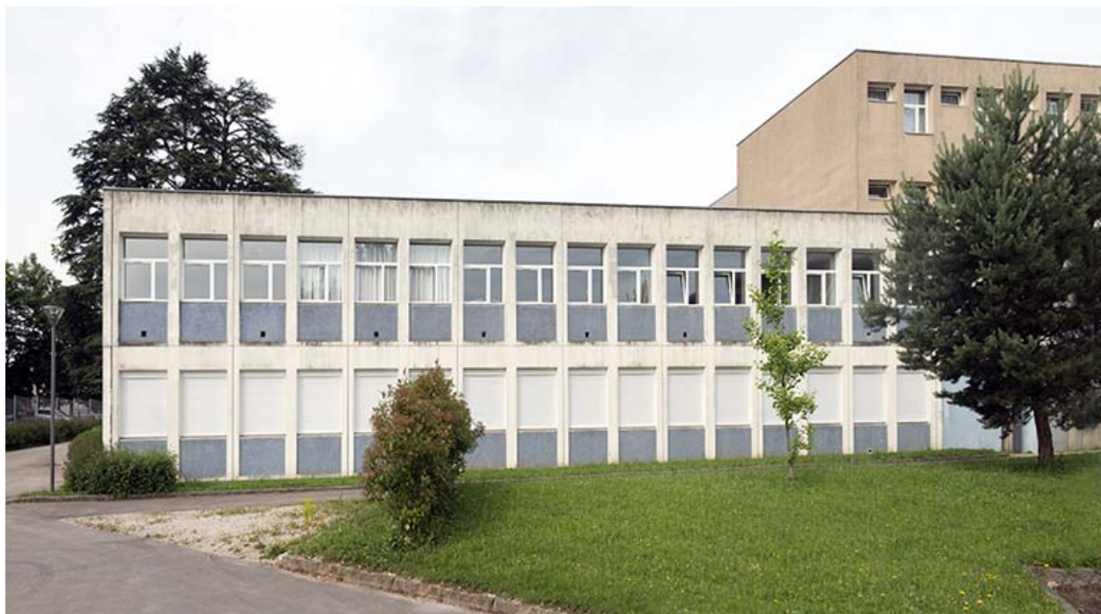
Façade nord-est du bâtiment d'internat et restauration.
