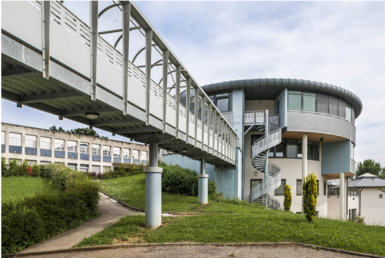
Vue d'ensemble de l'externat, la passerelle, l'escalier et la tour, les ateliers.
