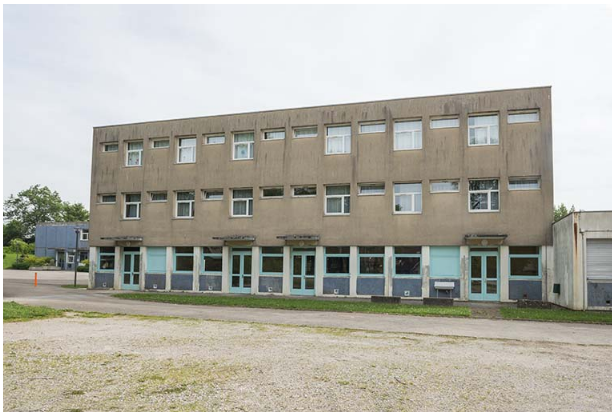
Façade sud-ouest de l'internat restauration.
