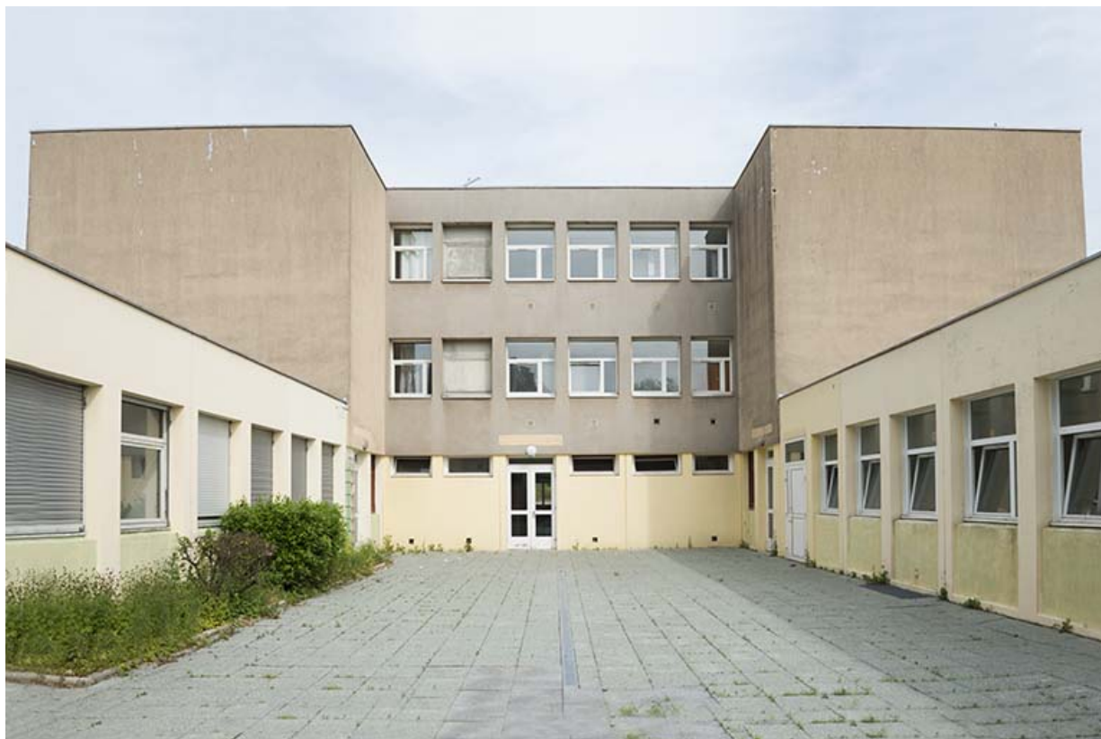
Cour postérieure du bâtiment d'internat et restauration.
