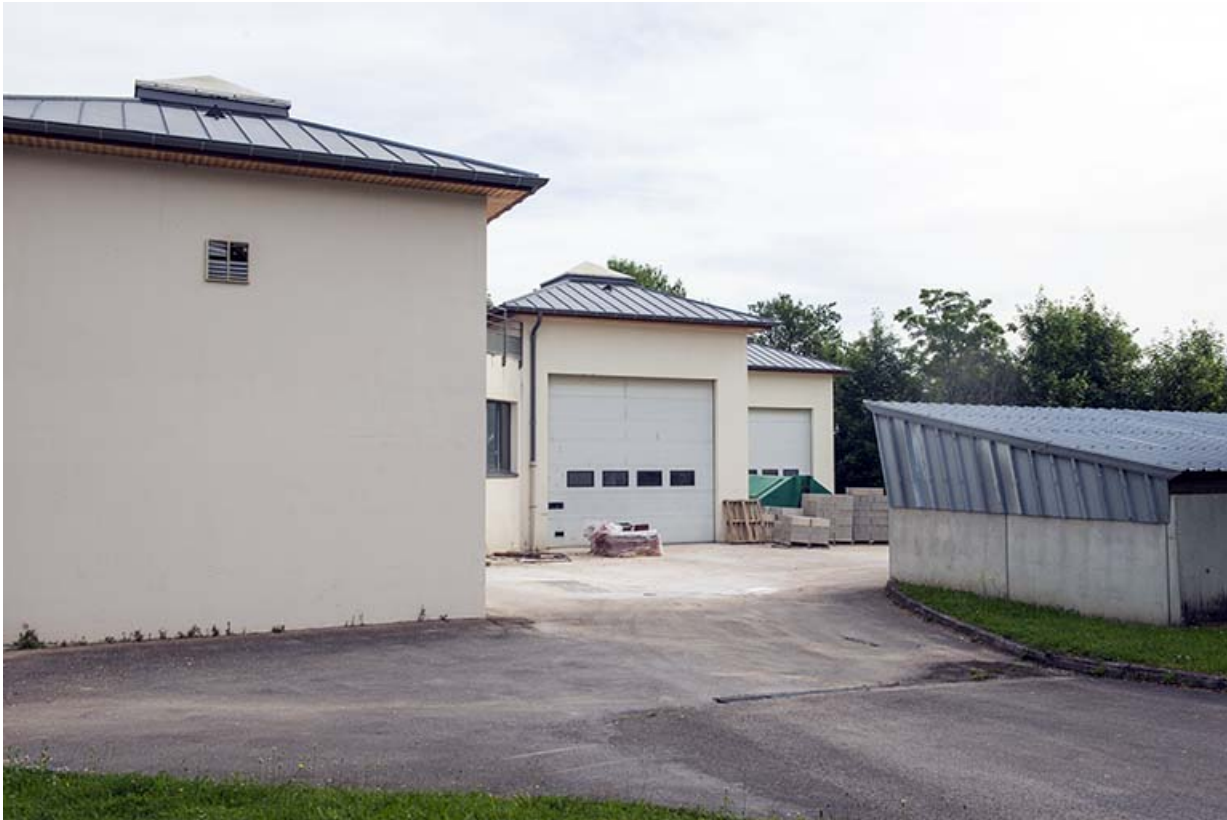
Cour et détail d'une des trois entrées des ateliers maçonnerie.
