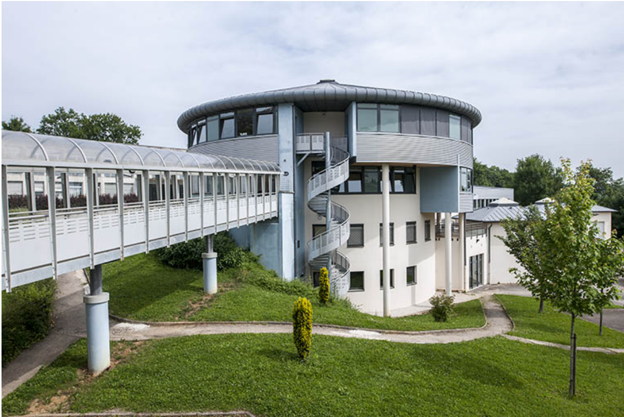
Vue d'ensemble de la passerelle, escalier et tour, ateliers.
