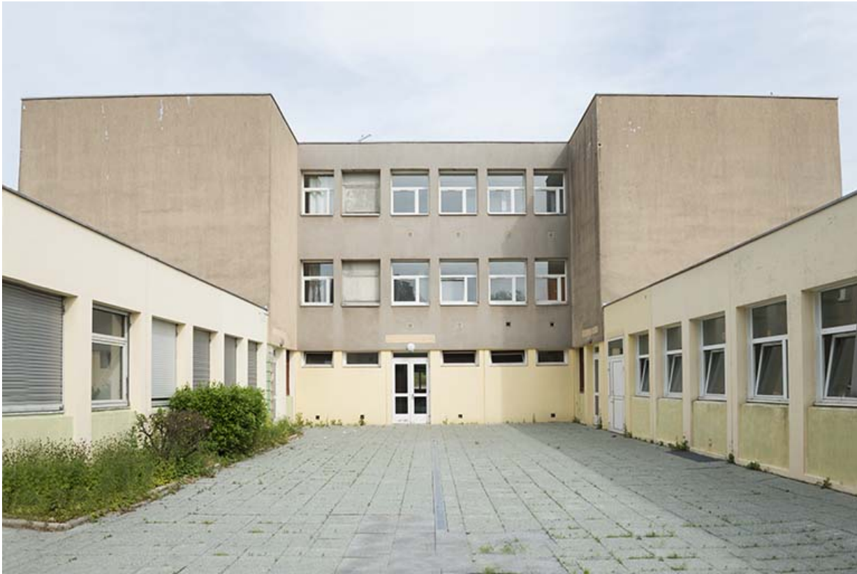
Cour postérieure du bâtiment d'internat et restauration.
