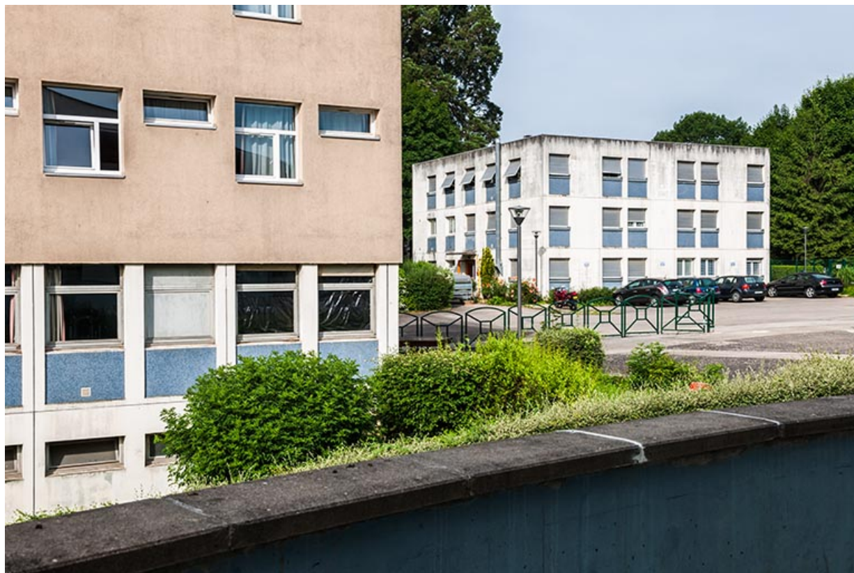
Angle nord de l'internat-restauration et vue sur les logements.
