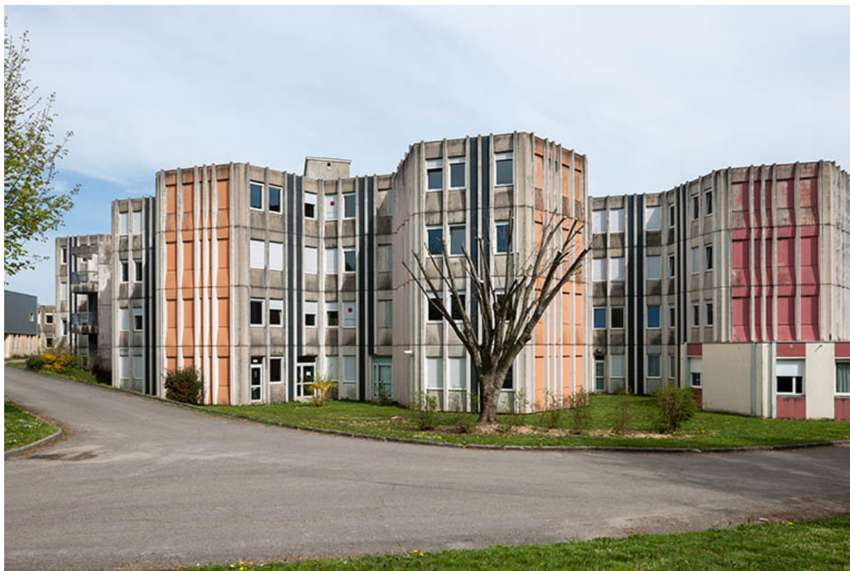
Les façades ouest de l'internat.
