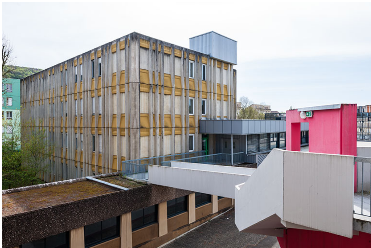
Circulation horizontale et escalier desservant les externats est et sud-est. 25, Besançon, 1 rue Rembrandt
