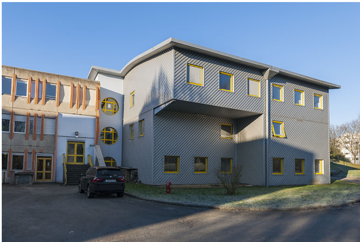
Façades postérieures nord-est des classes préparatoires aux grandes écoles. (CPGE) 25, Besançon, 1 rue Rembrandt
