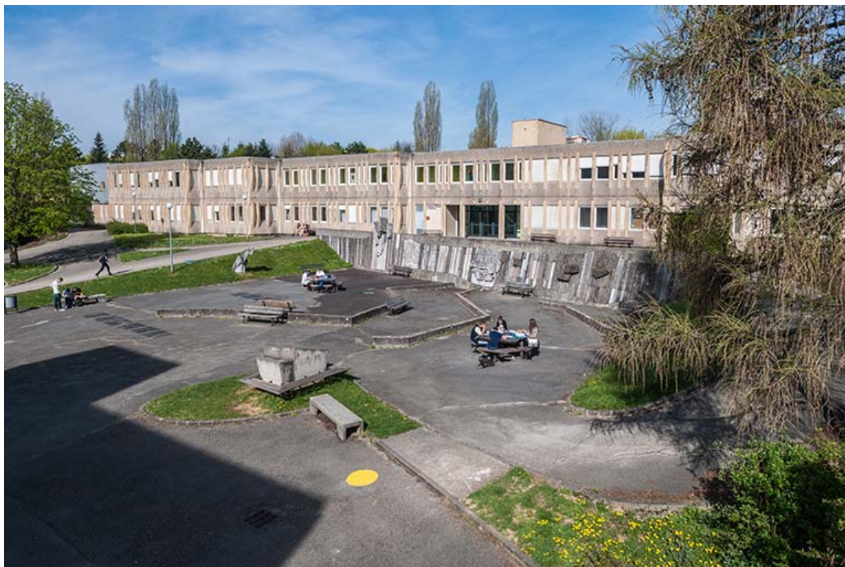
Cour, sculpture, ateliers vus du sud-est. 25, Besançon, 1 rue Rembrandt
