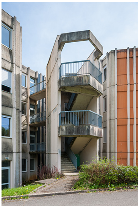
Détail de l'escalier extérieur de l'internat.
