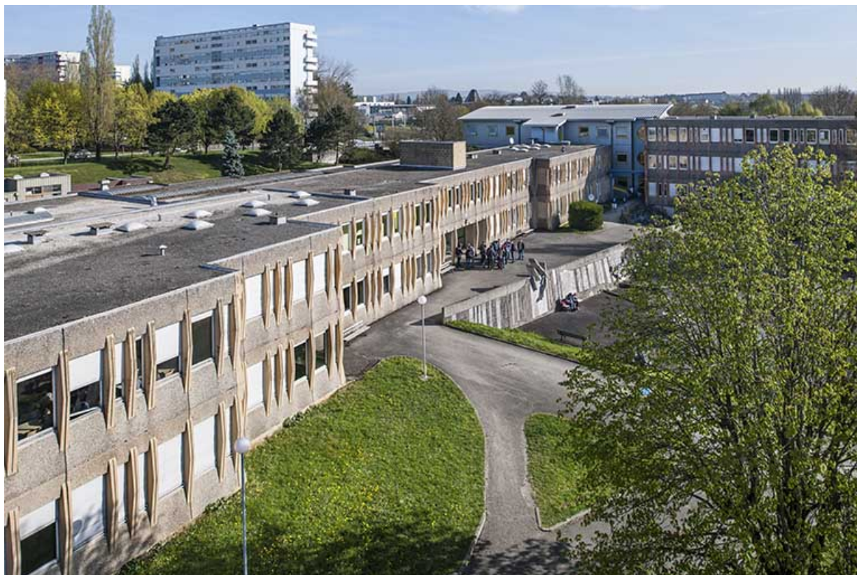
Façade antérieure sud-est des ateliers industriels, cour, bâtiment d'externat. 25, Besançon, 1 rue Rembrandt
