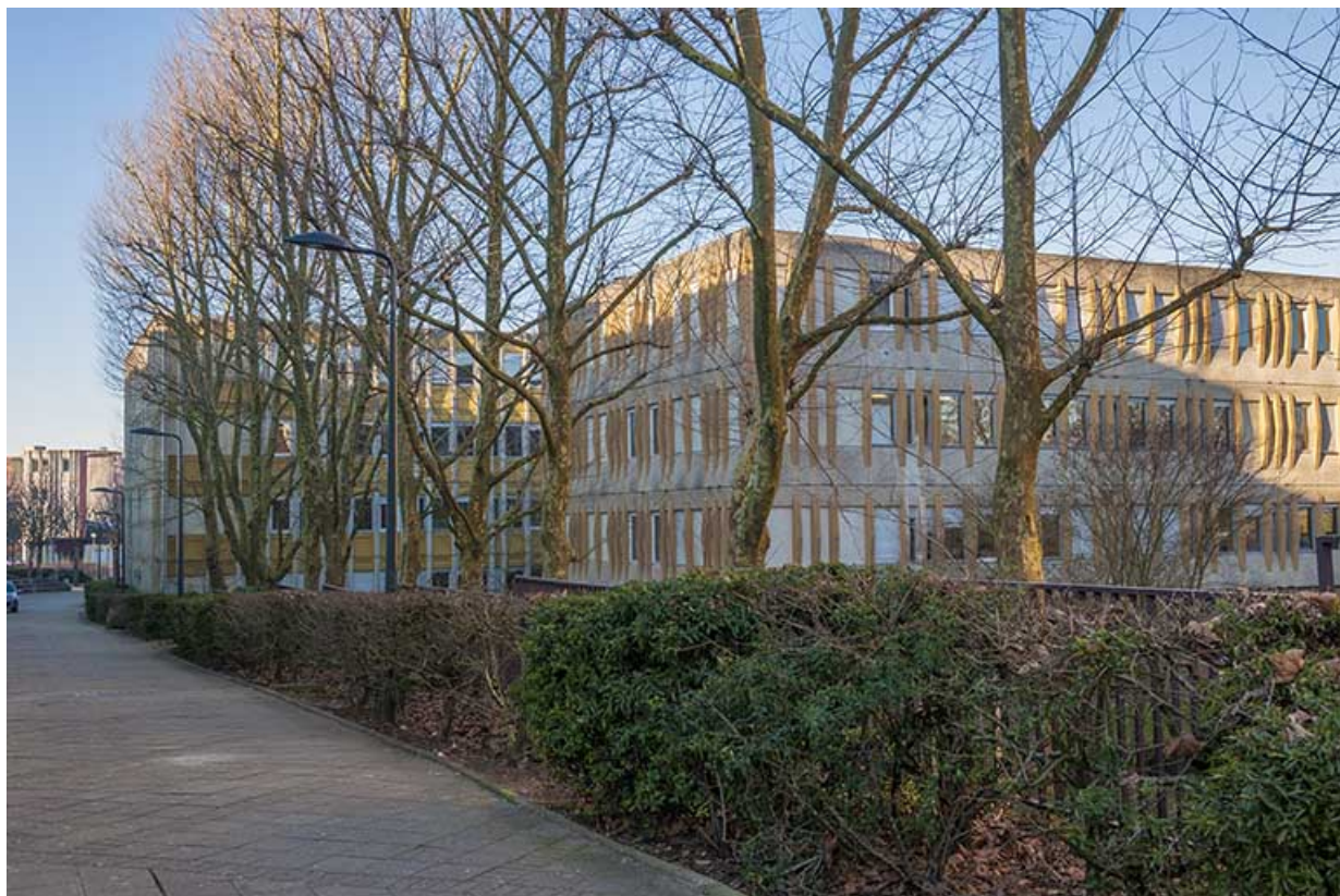
Le long de la rue Rembrandt, les pignons sud-est des externats. 25, Besançon, 1 rue Rembrandt
