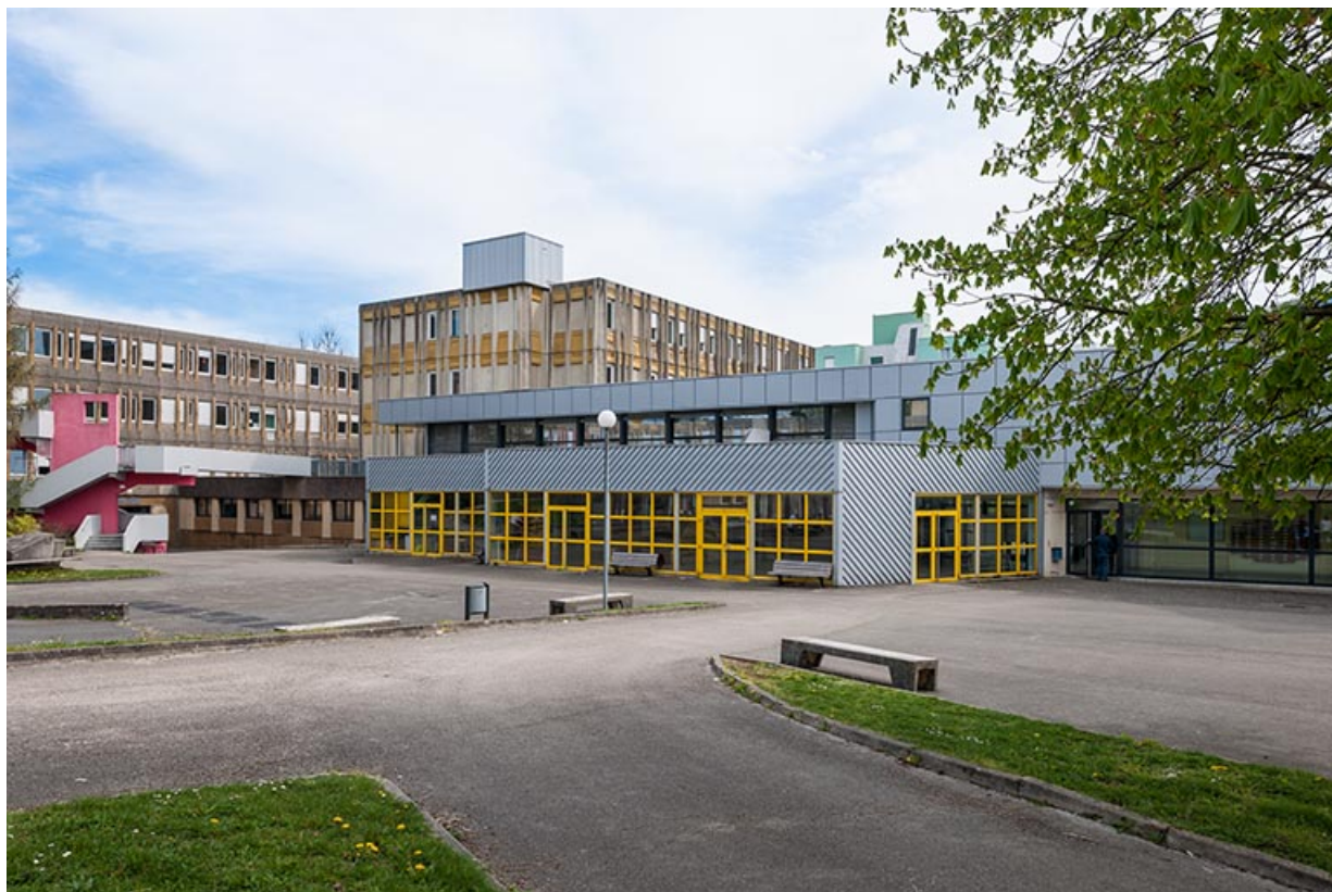
Au sud-est de la cour, l'escalier desservant les externats.
