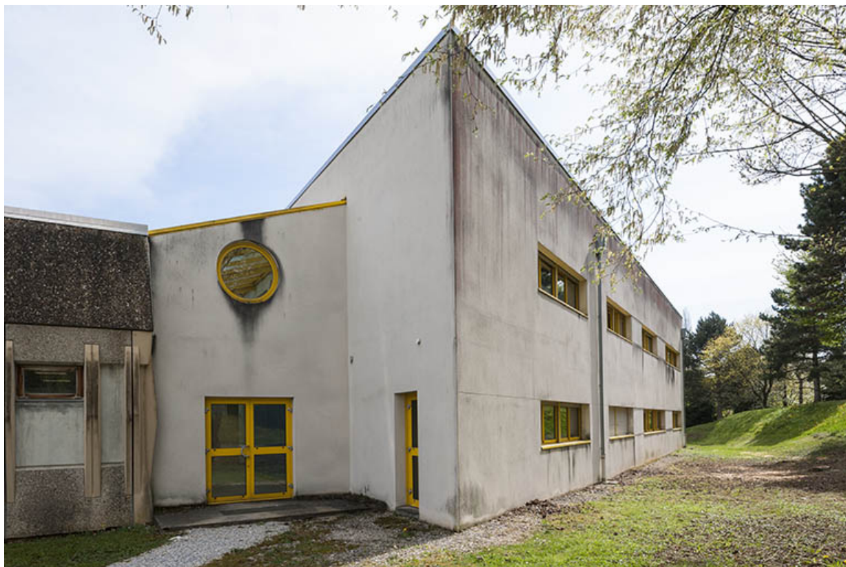
Façade postérieure nord-ouest et angle nord de l'externat ouest jouxtant les ateliers. 25, Besançon, 1 rue Rembrandt
