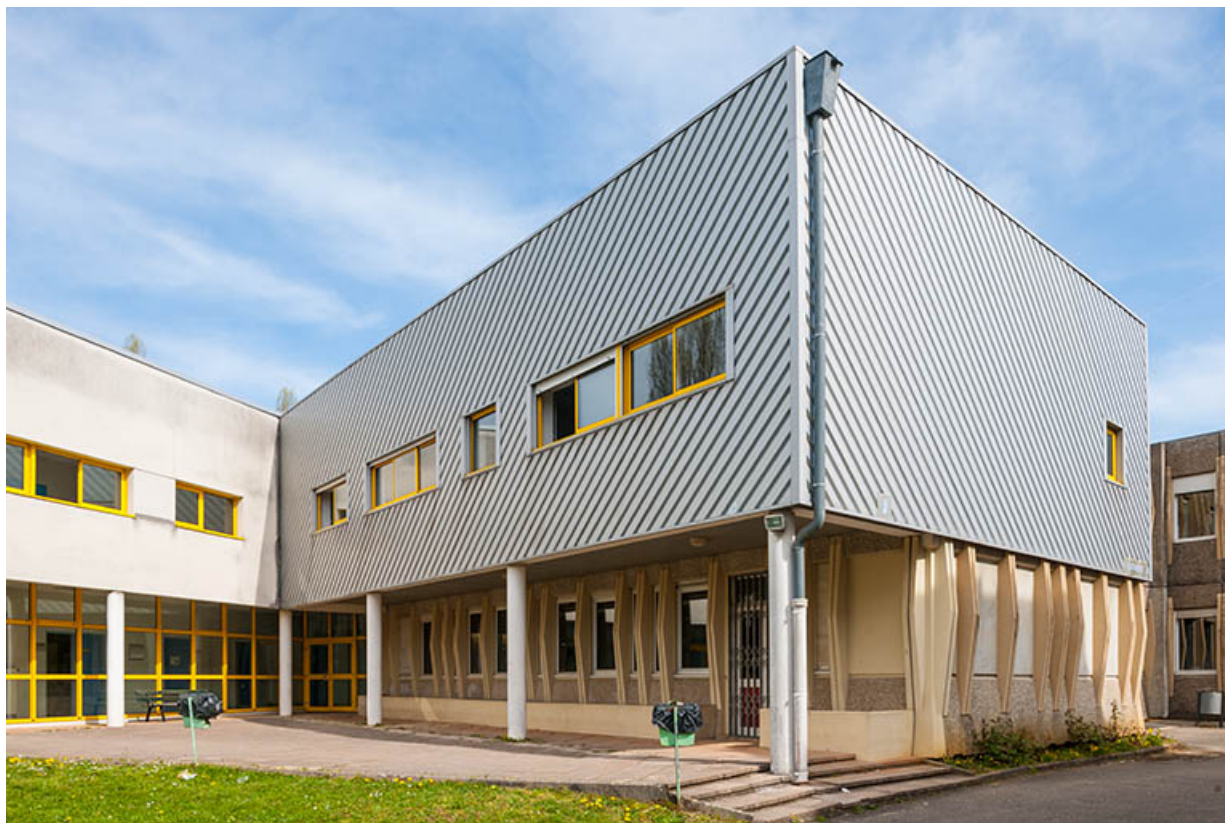
Détail de la façade antérieure de l'externat ouest.
