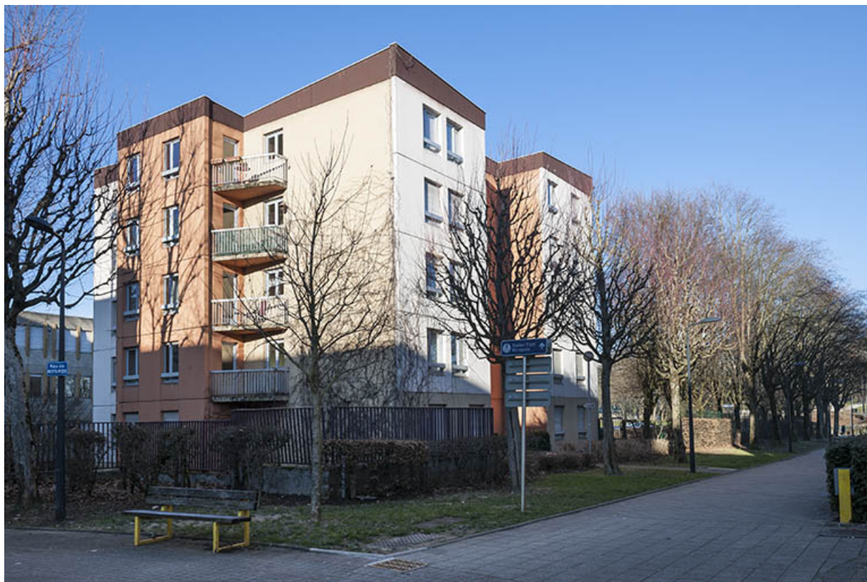
Angle est des logements depuis la rue Renoir et la place des petits pieds, à l'est. 25, Besançon, 1 rue Rembrandt
