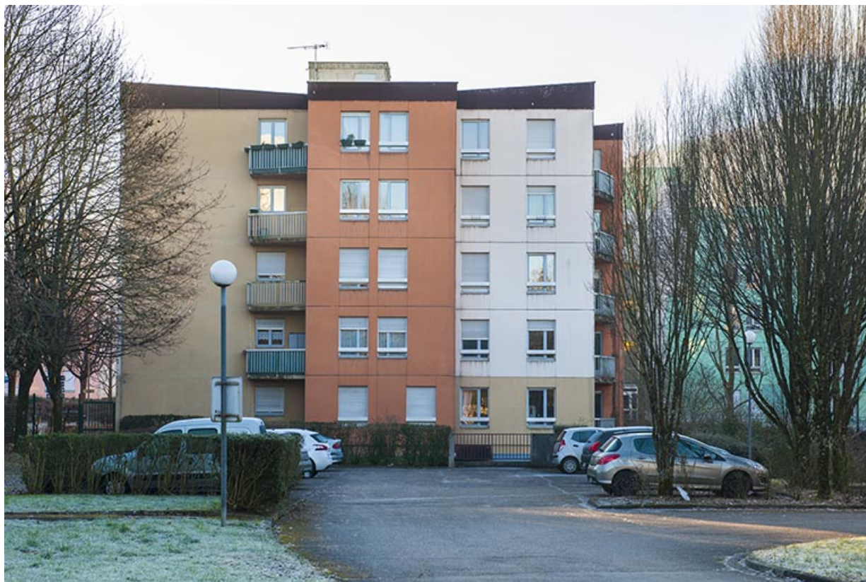
Les logements : façade nord-ouest.
