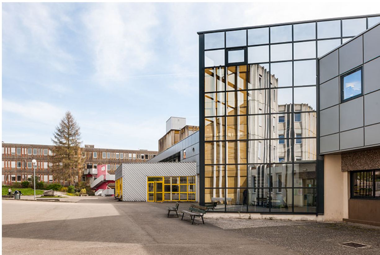
Depuis le sud-ouest, vue de profil des bâtiments bordant la cour au sud-est. 25, Besançon, 1 rue Rembrandt
