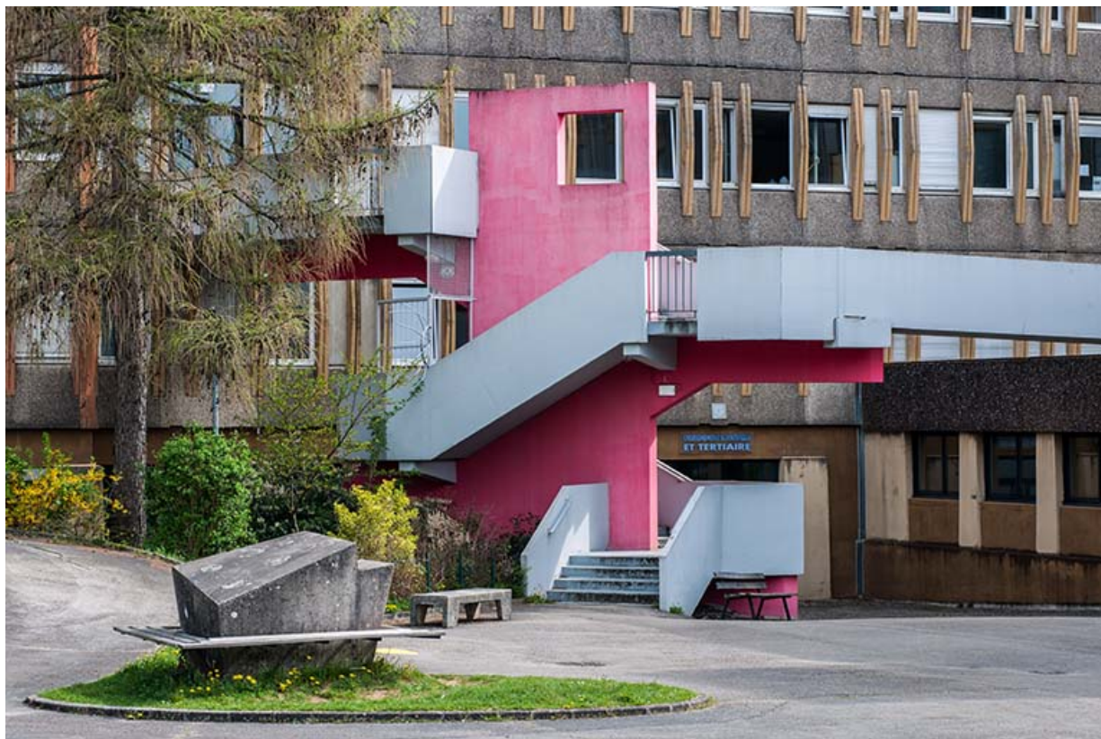
Vus de la cour, la passerelle et l'escalier devant l'externat d'enseignement scientifique et tertiaire. 25, Besançon, 1 rue Rembrandt
