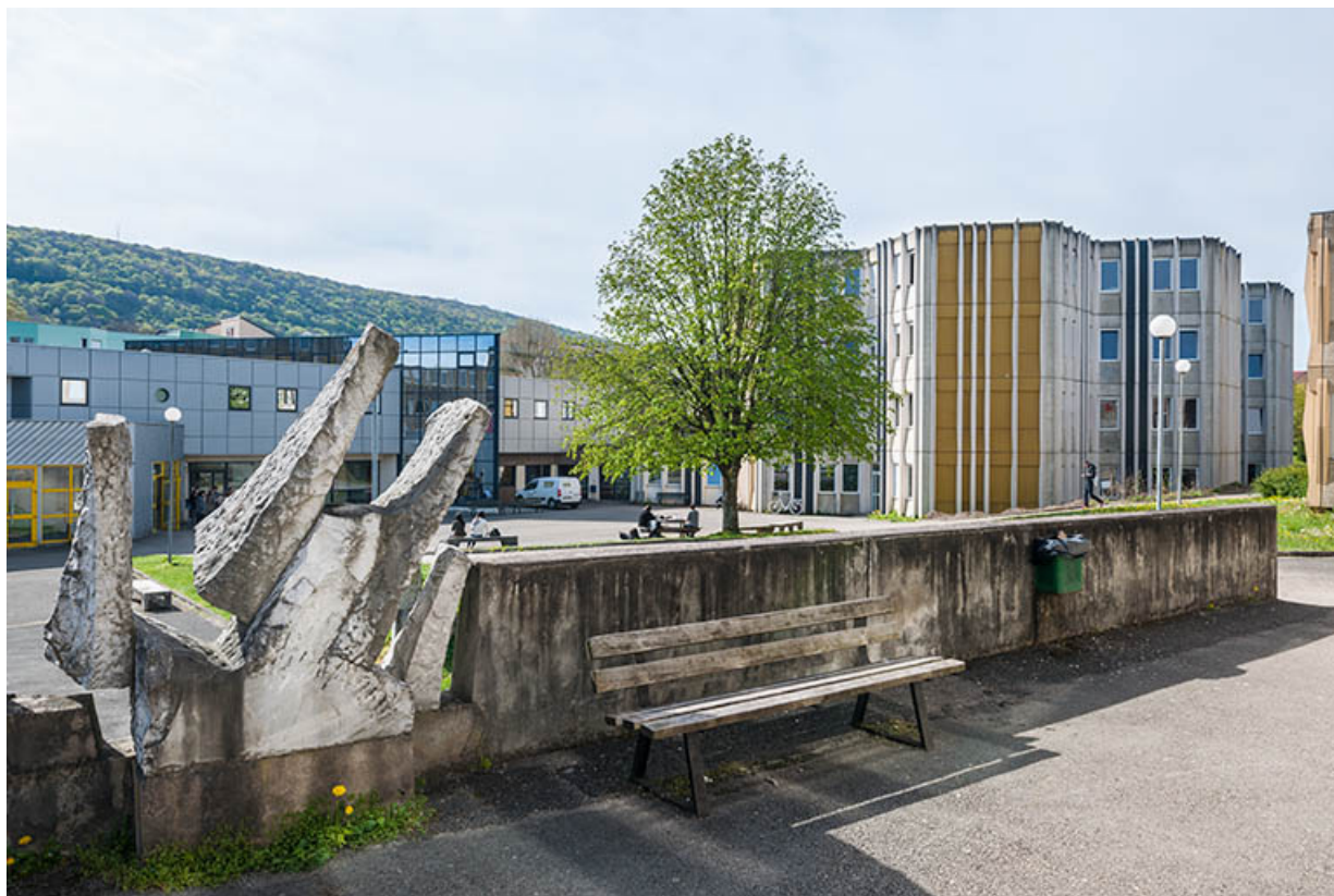
Face postérieure de l'oeuvre de Jean Gilles. 25, Besançon, 1 rue Rembrandt
