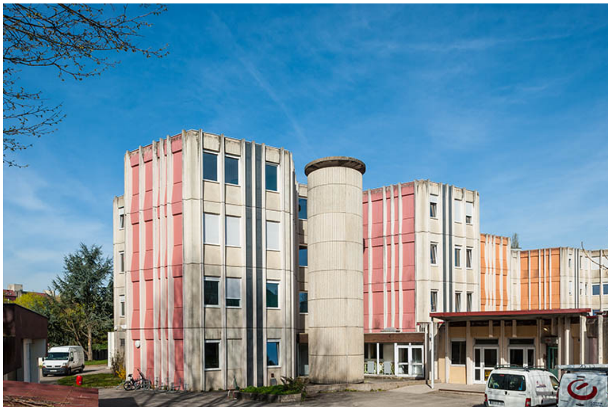
Les façades est du bâtiment de restauration et d'internat.
