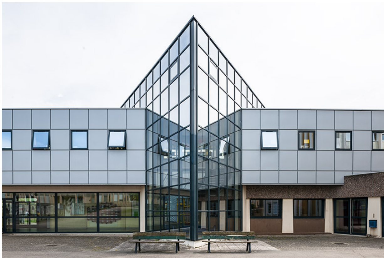
Bâtiment de l'administration et centre de documentation et d'information (cdi) à l'étage : détail. 25, Besançon, 1 rue Rembrandt
