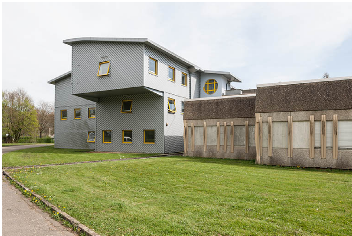
Extrémité postérieure nord-est des ateliers et classes préparatoires.
