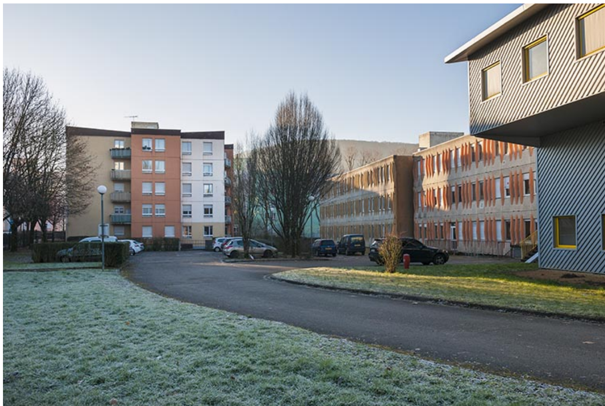
Façades nord-est de l'externat et façade nord-ouest des logements. 25, Besançon, 1 rue Rembrandt
