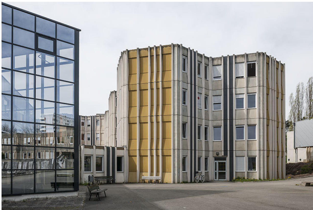
Détail de façade nord et est, sur cour, de l'internat.
