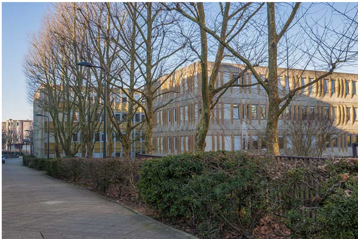
Le long de la rue Rembrandt, les pignons sud-est des externats.
