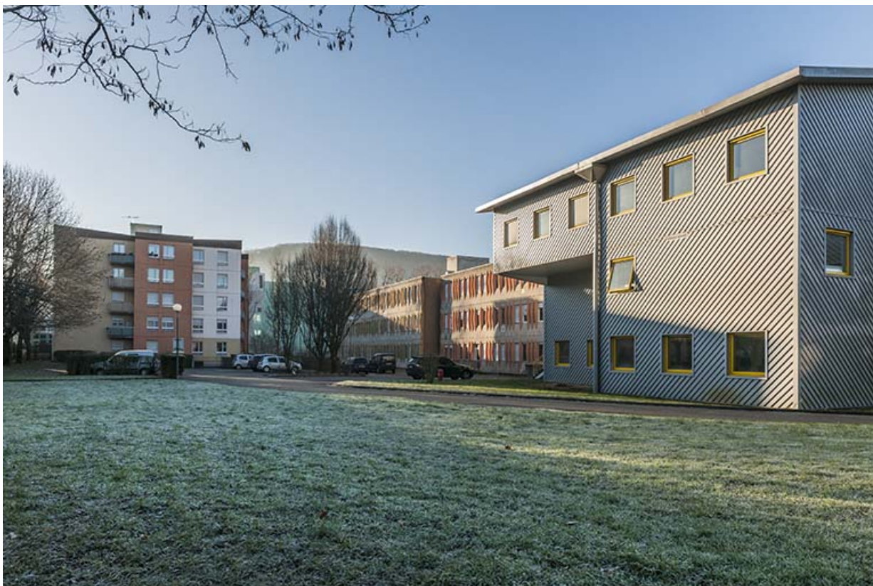
Vue d'ensemble des façades postérieures nord-est depuis le nord du terrain. 25, Besançon, 1 rue Rembrandt
