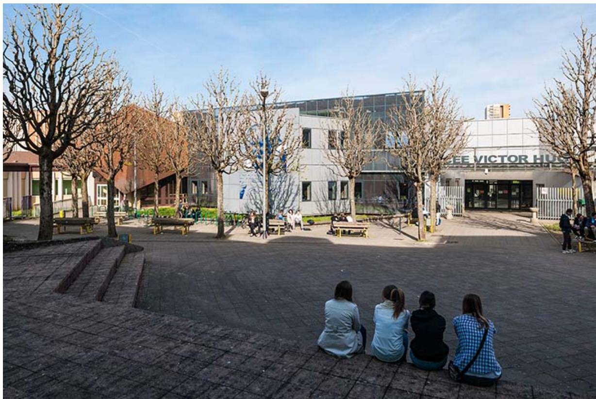
L'entrée, vue de la place devant le lycée.
