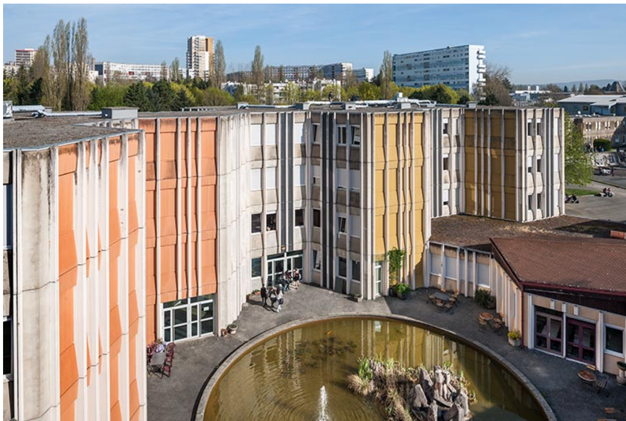
Bassin, façades sud et ouest des externats qui le bordent.
