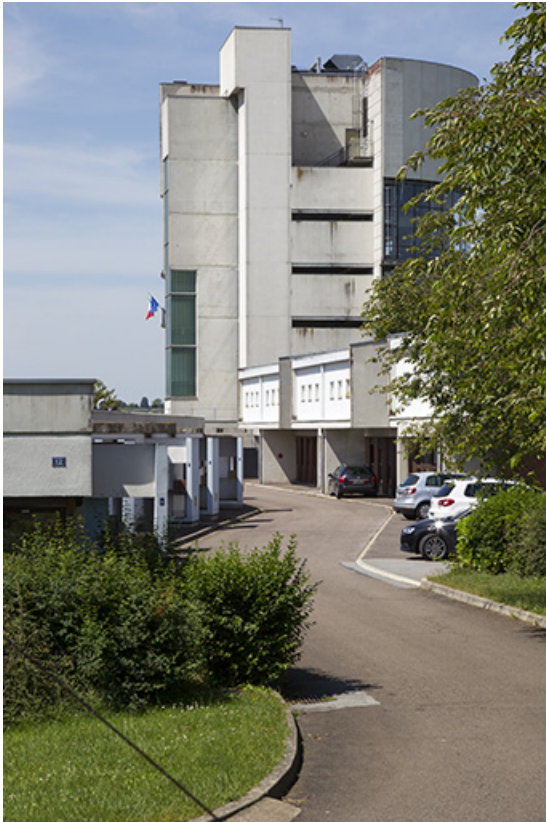
Façades antérieures -nord- des logements et vue depuis le nord-est sur le bâtiment "agencement" ainsi que sur la tour centrale. 25, Besançon, 14 rue Alain Savary, lieudit : Temis
