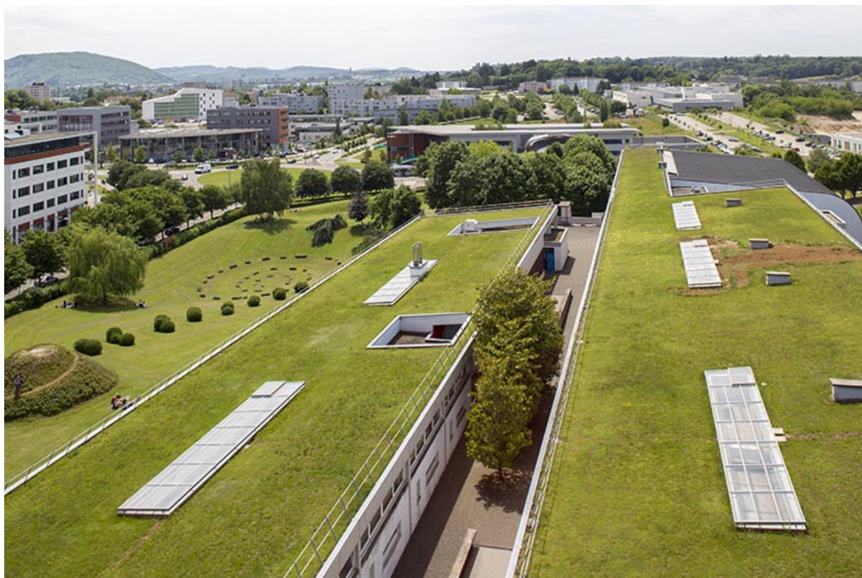
Depuis la tour, vue d'ensemble sur la partie sud-ouest.
