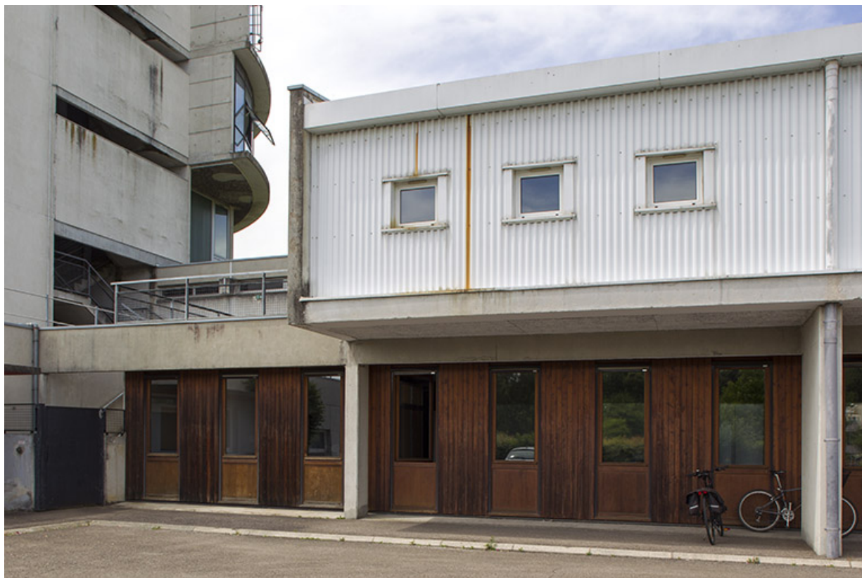
Entrée au rez-de-chaussée du bâtiment "agencement".
