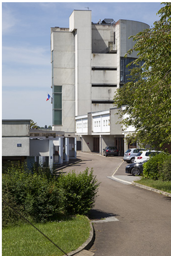
Façades antérieures -nord- des logements et vue depuis le nord-est sur le bâtiment "agencement" ainsi que sur la tour centrale. 25, Besançon, 14 rue Alain Savary, lieudit : Temis
