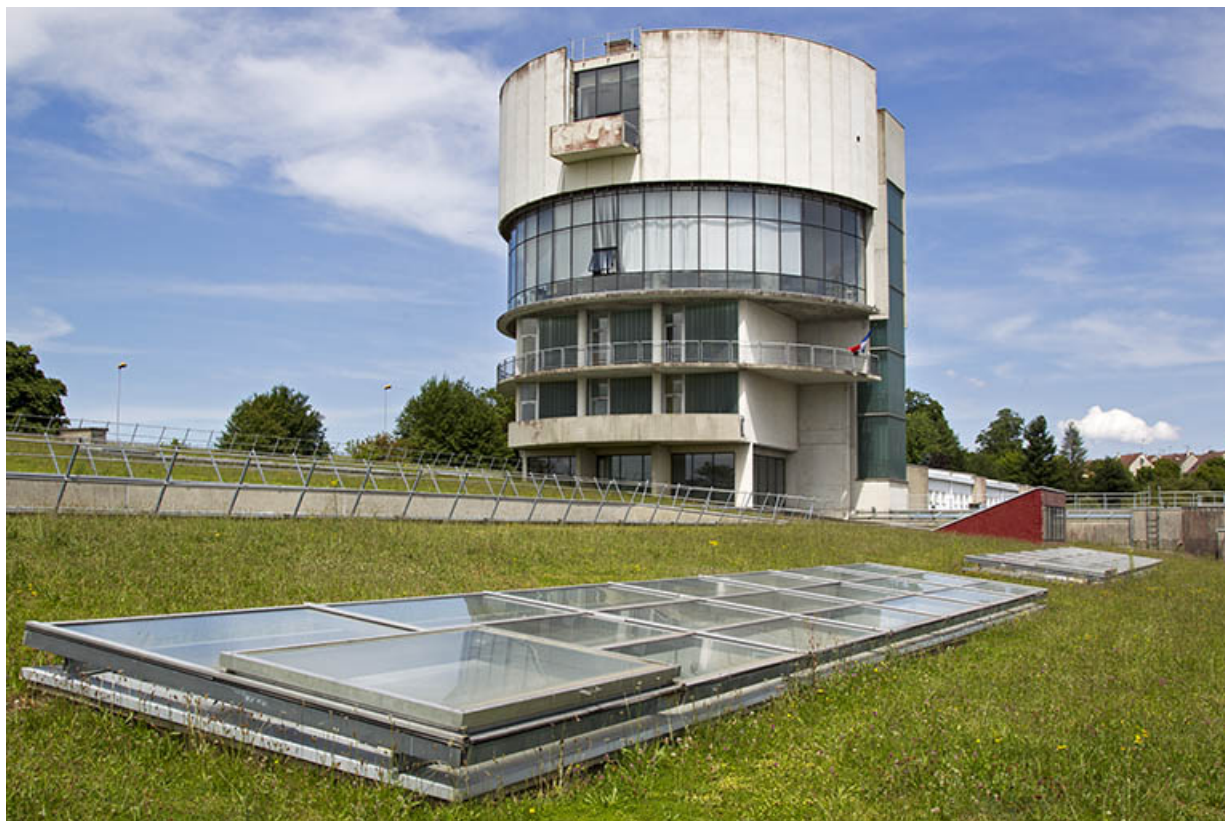
La tour vue du sud-ouest et détail de verrière sur terrasse.
