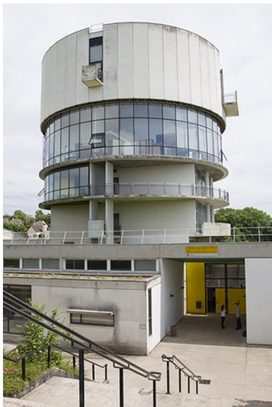
Vue postérieure (nord) de la tour et de l'escalier.
