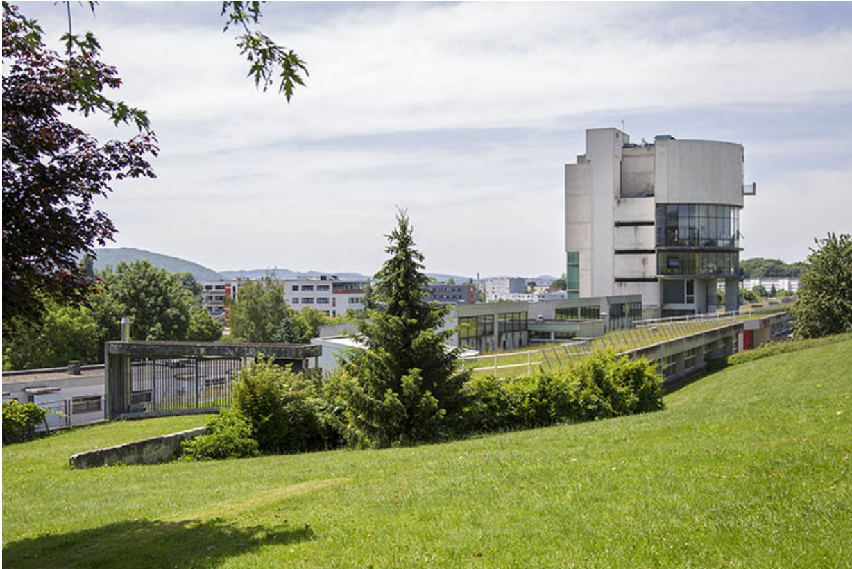
Vue d'ensemble des façades postérieures depuis le nord-est.
