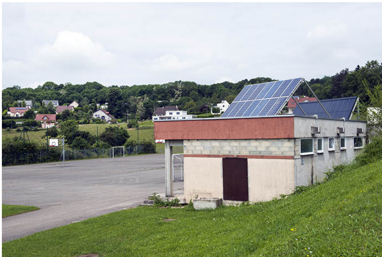
Angle sud-est du vestiaire.
