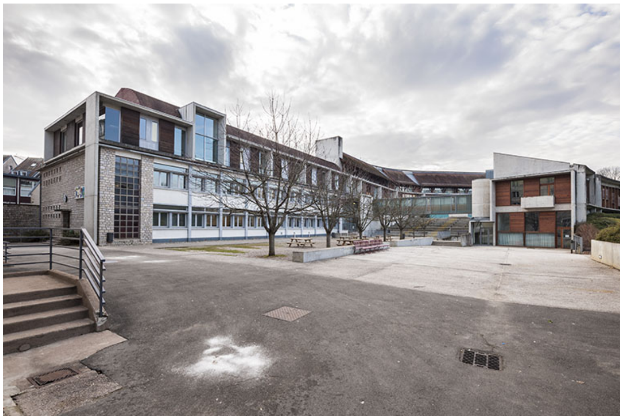
Vue d'ensemble de la cour, de l'externat et du restaurant d'application depuis le nord-ouest.
