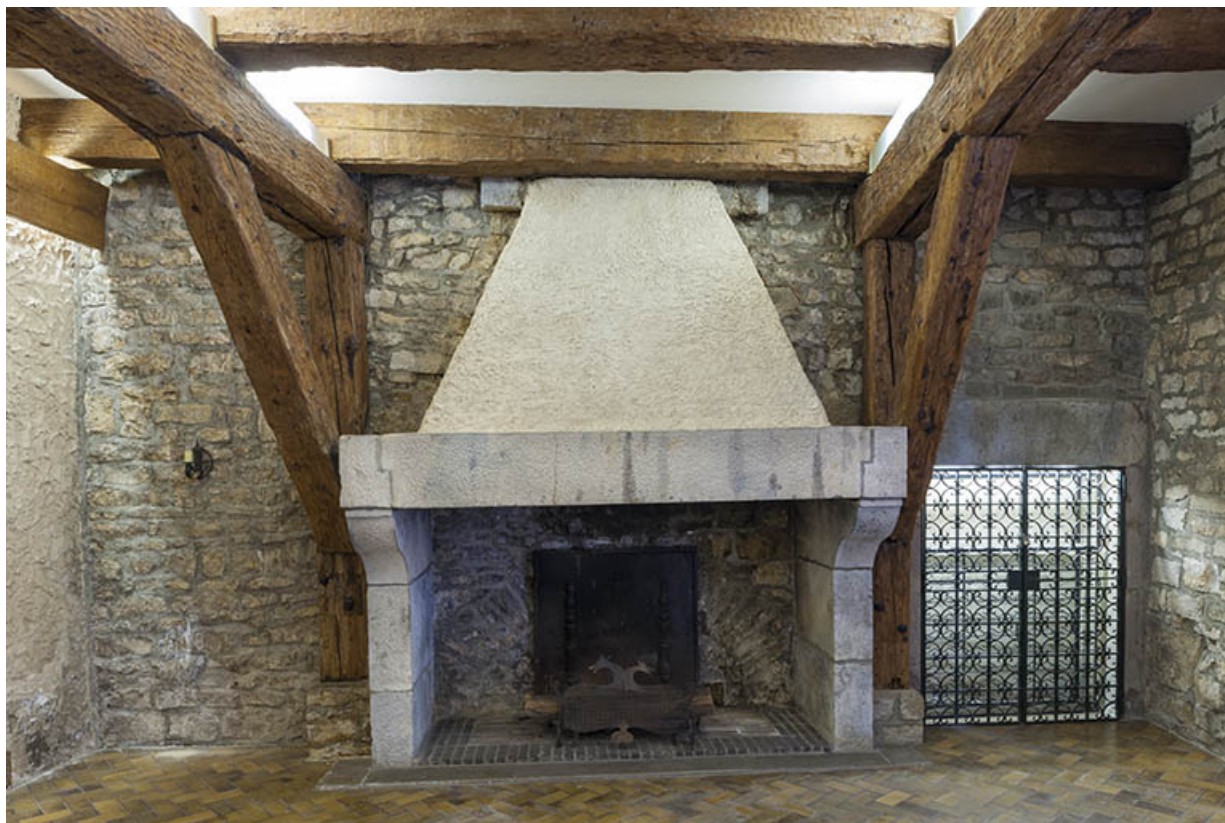
Détail intérieur du pavillon de corps de garde : cheminée.
