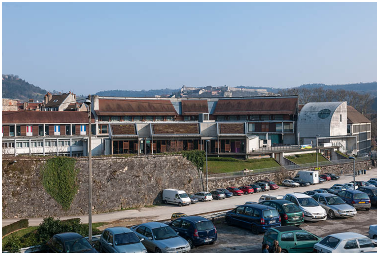
Vue d'ensemble des parties sud depuis l'ouest.
