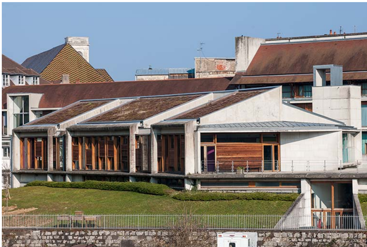
Vue rapprochée du restaurant d'application vu du sud-ouest.
