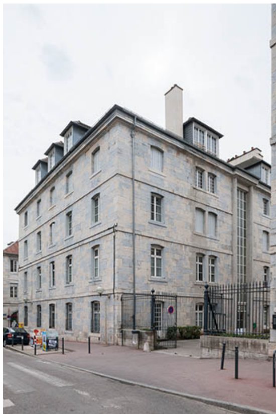
Angle nord-ouest et façade du pavillon des officiers est donnant sur la place Marulaz. 25, Besançon, 5 place Marulaz
