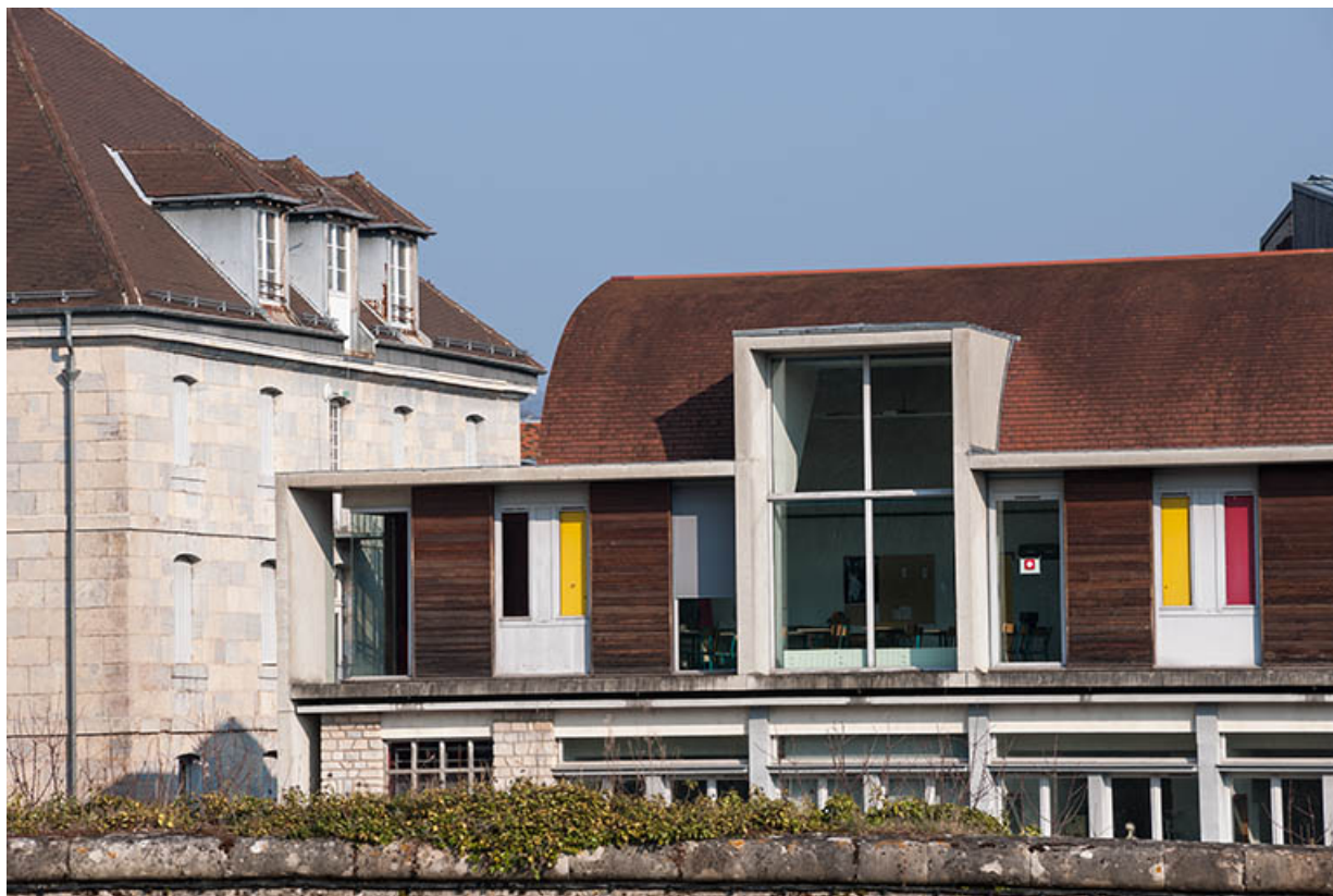
Extrémité nord de l'externat et pignon sud du pavillon des officiers est vus de l'ouest.
