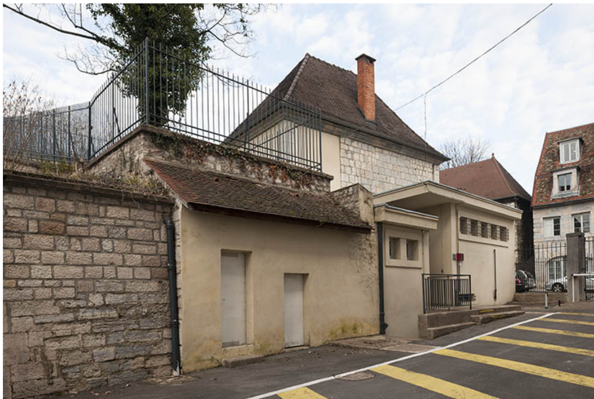
Façade est sur cour de l'ancien corps de garde et des bâtiments adjacents, vus de trois-quart. 25, Besançon, 5 place Marulaz
