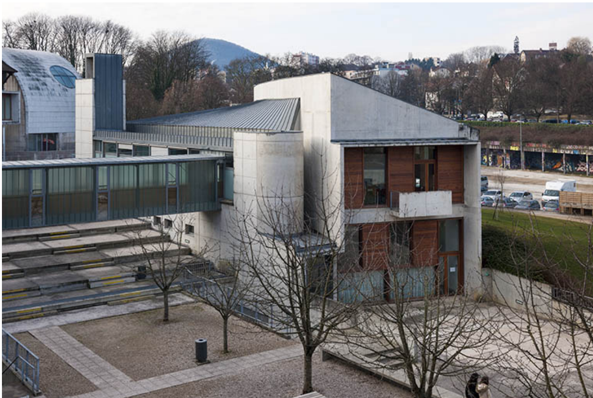
Vue plongeante sur la cour et l'angle nord-est du restaurant d'application.
