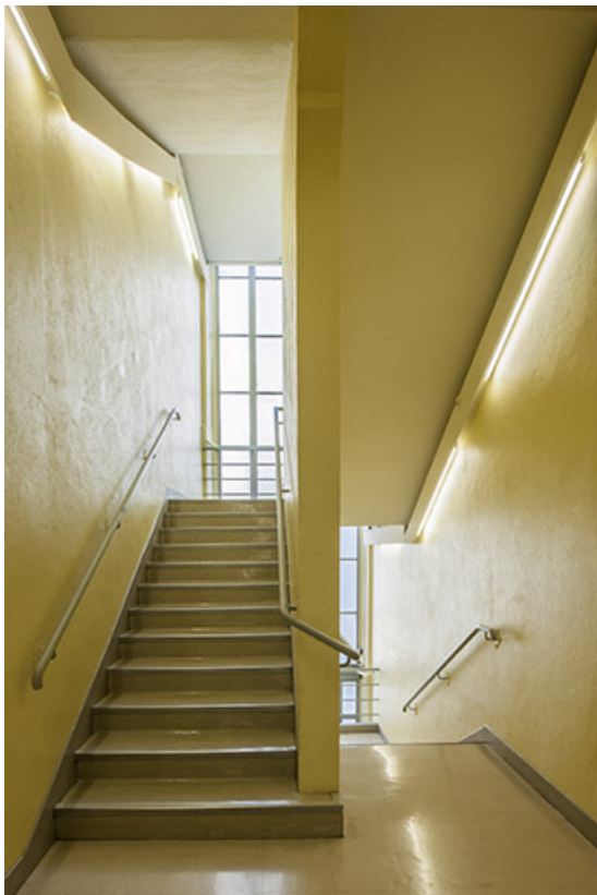
Détail d'escalier dans le pavillon d'officier est. 25, Besançon, 5 place Marulaz
