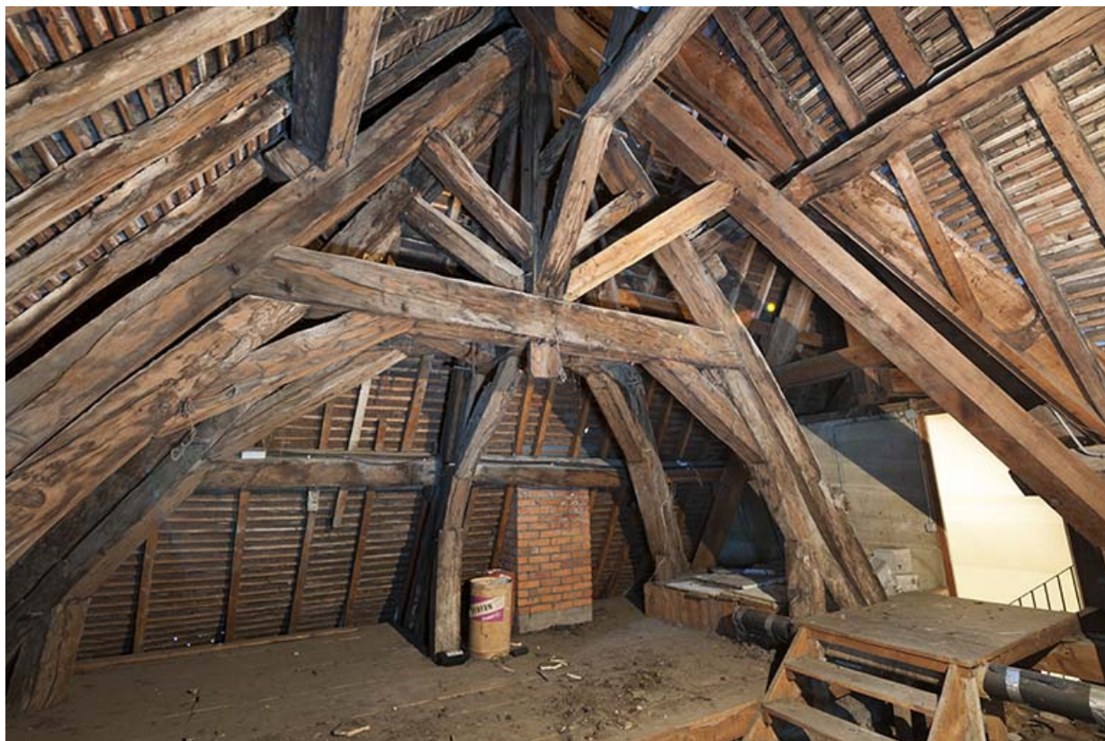
Détail de charpente de l'ancien corps de garde.
