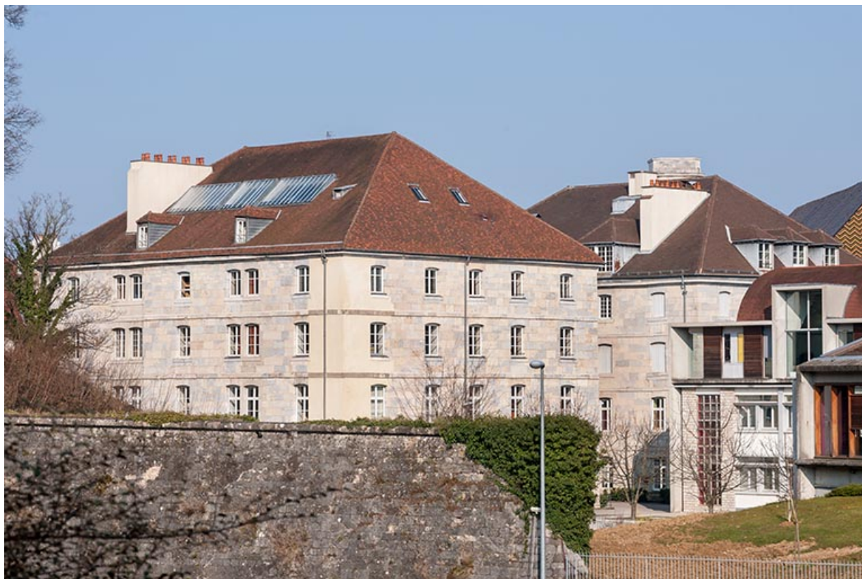
Vus du sud-ouest, les deux pavillons des officiers ouest et est.
