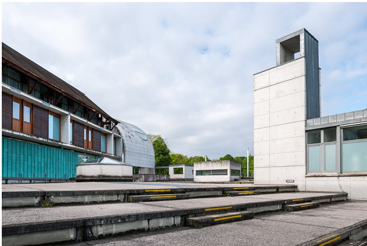
Cour au-dessus du gymnase, entre restaurant et externat. 25, Besançon, 5 place Marulaz
