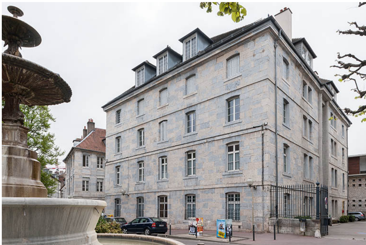
Angle nord-ouest et façade du pavillon des officiers est donnant sur la place Marulaz. 25, Besançon, 5 place Marulaz
