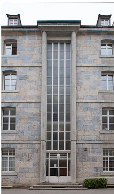
Entrée sur cour du pavillon des officiers est. 25, Besançon, 5 place Marulaz
