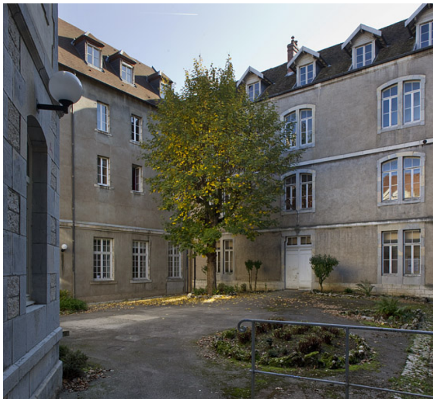
Bâtiments de la cour située dans le bâtiment Ducat.
