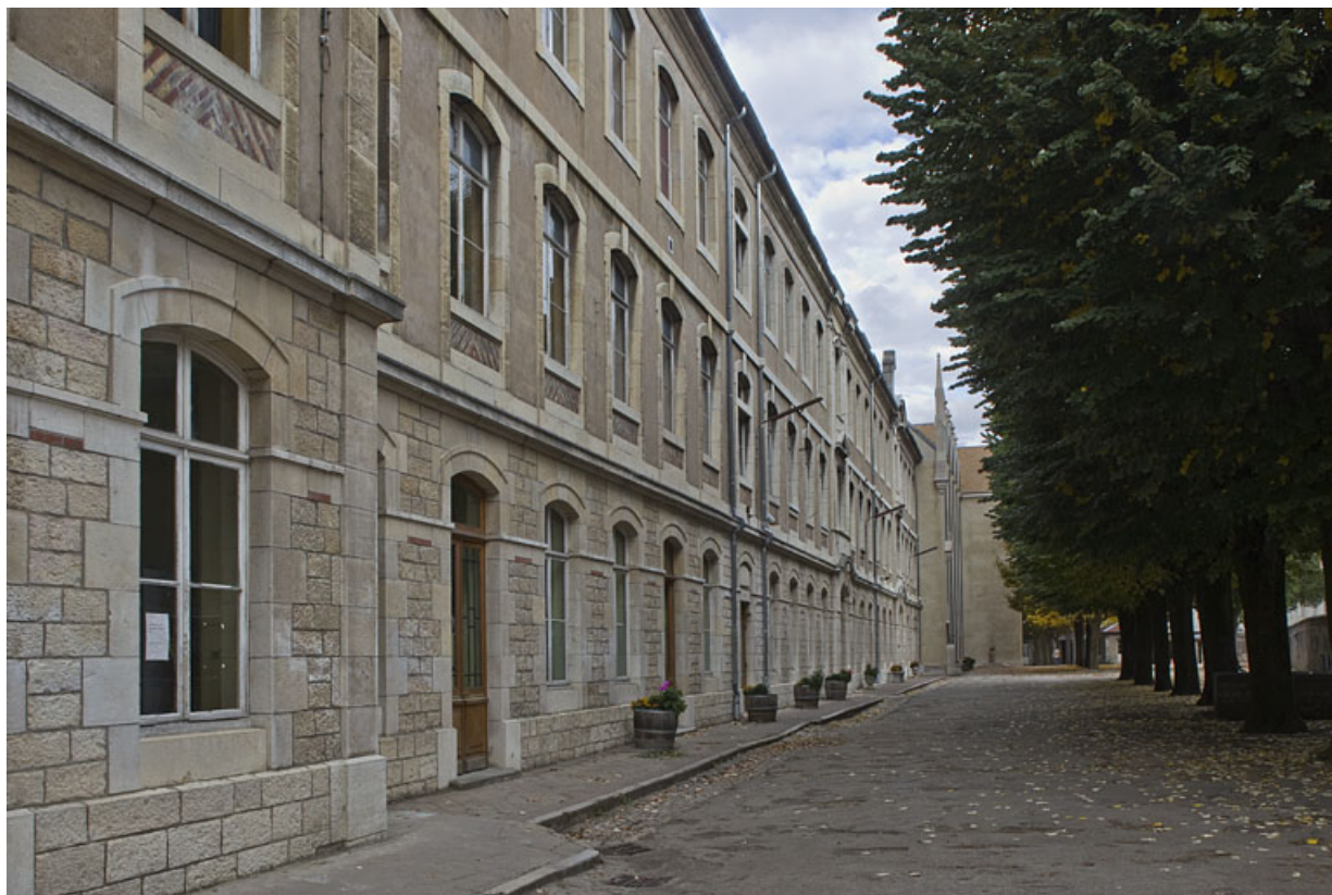
Vue perspective de la façade antérieure du bâtiment Ducat prolongé par la chapelle. 25, Besançon, 4 rue du Lycée
