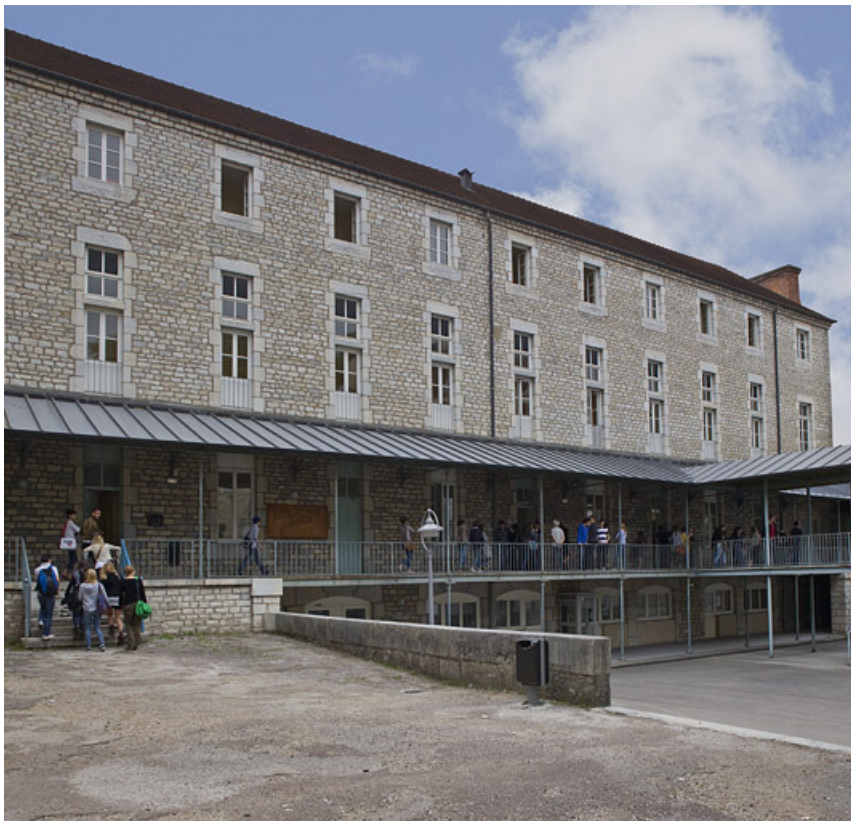
Vue générale de la façade antérieure du bâtiment Girod de Chantrans. 25, Besançon, 4 rue du Lycée
