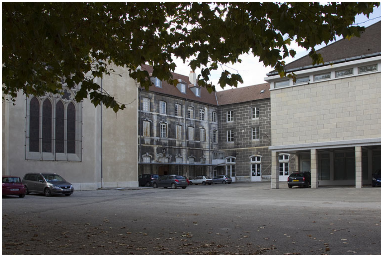
Vue générale de la chapelle, des bâtiments Ducat et Vauban ainsi que du gymnase depuis la cour du lycée. 25, Besançon, 4 rue du Lycée
