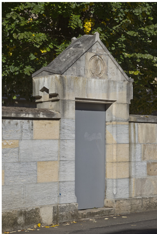
Portail situé dans la rue Girod de Chantrans, dans le mur d'enceinte du lycée, qui permet l'accès à la cour du bâtiment Ducat. 25, Besançon, 4 rue du Lycée
