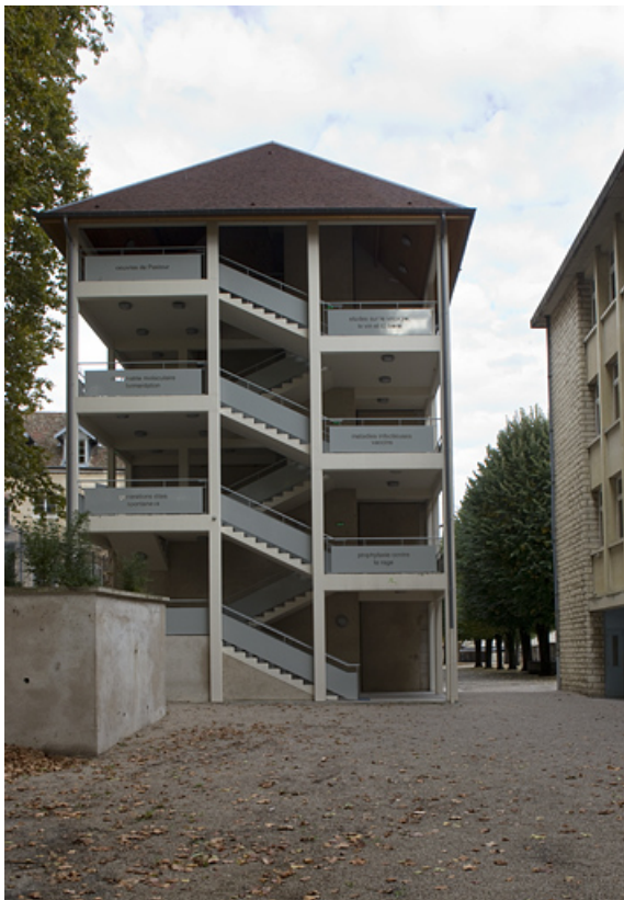
Escalier de distribution extérieur situé à l'extrémité ouest du bâtiment Ducat. 25, Besançon, 4 rue du Lycée
