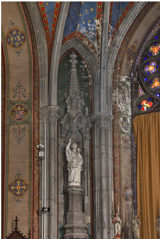
Décor sculpté du choeur situé entre deux retombées d'ogives (côté nord). 25, Besançon, 4 rue du Lycée
