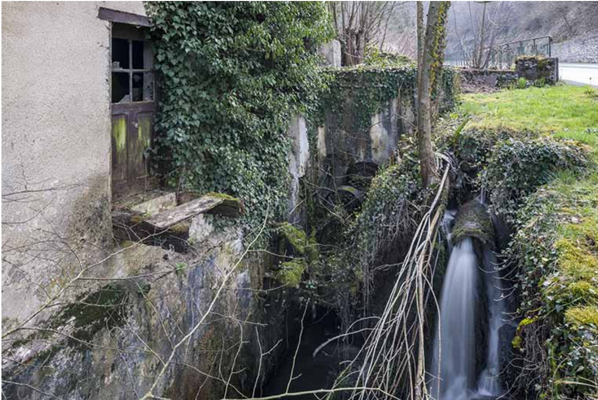
Canal d'amenée et vestiges de la turbine.
