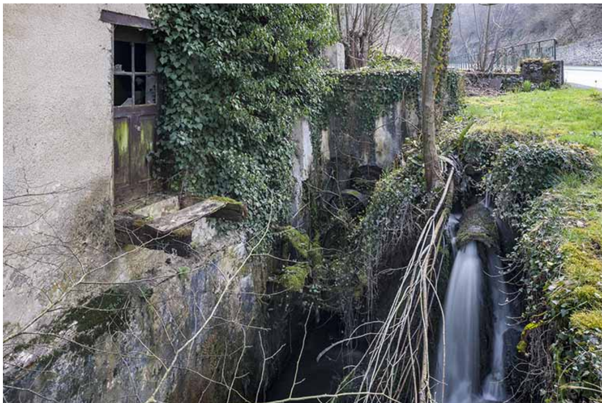
Canal d'amenée et vestiges de la turbine.
