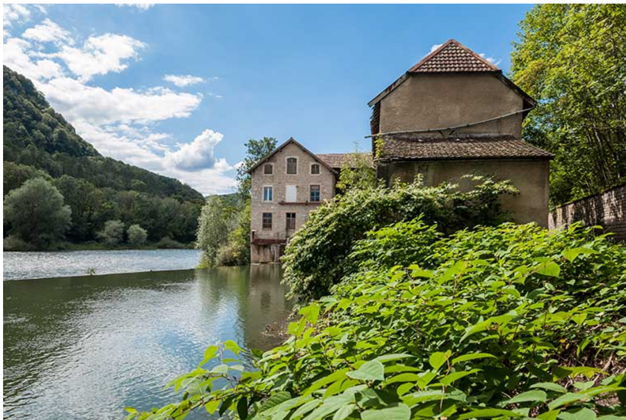
Moulin (sud) et magasin industriel depuis l'amont.
