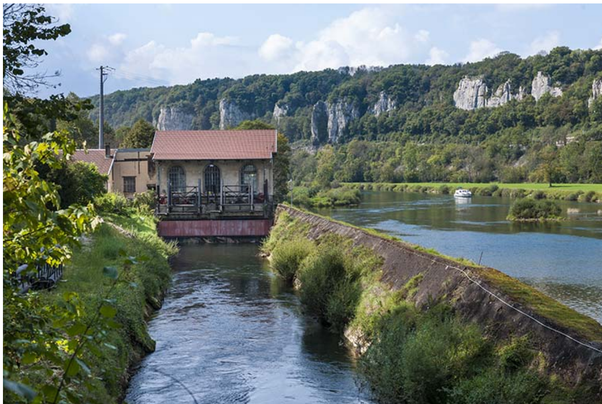
Vue depuis le canal d'aménée.
