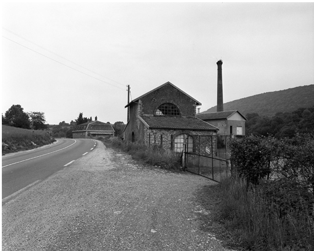
Vue d'ensemble depuis la route nationale.
