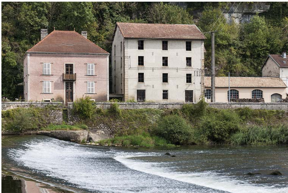
Le logement patronal, la minoterie et la centrale hydroélectrique depuis l'ouest.
