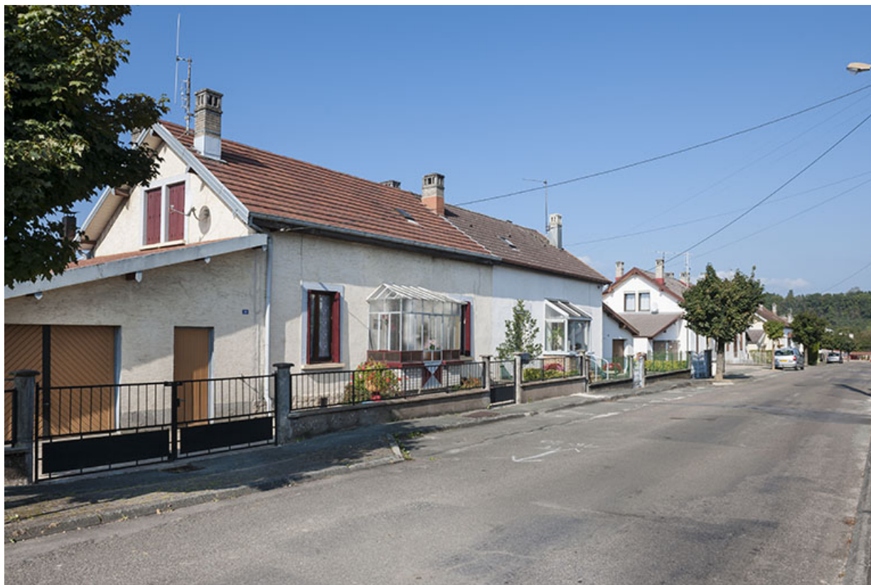
Maisons jumelées sur le côté ouest de la rue Voulot.
