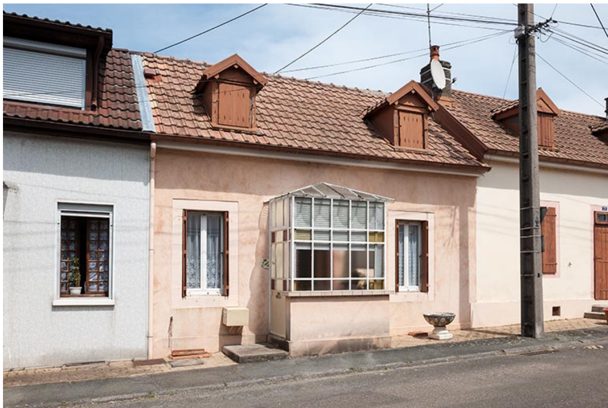
Logement au centre d'une habitation, rue de la 2e Cité.
