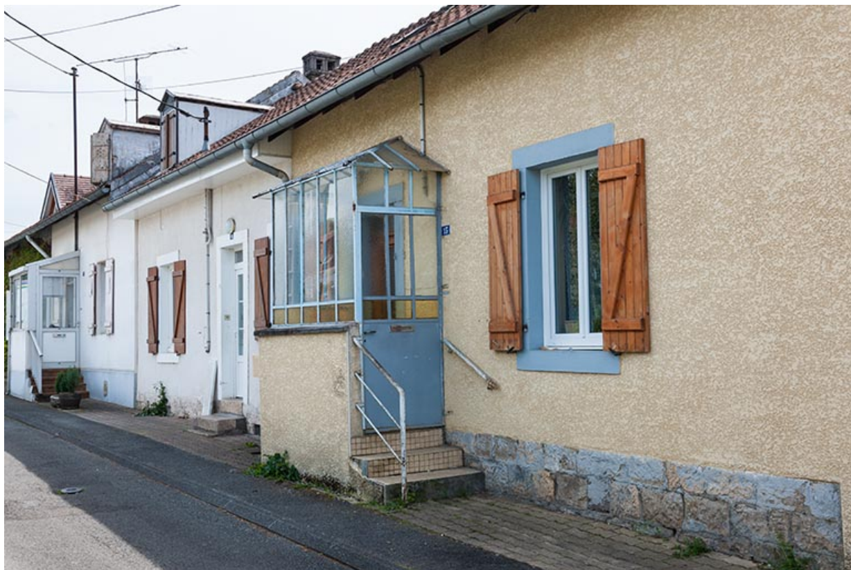
Rue de la 3e Cité. Façade nord vue de trois quarts droite.
