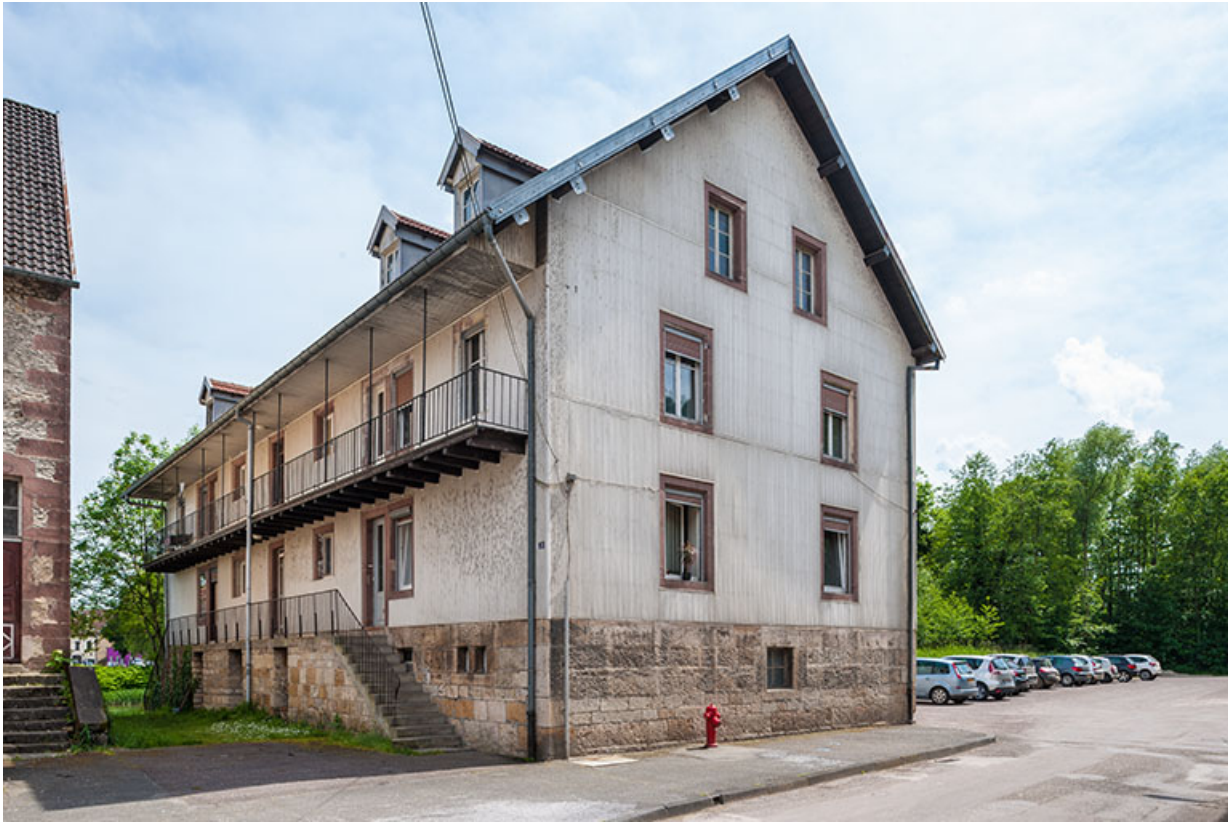
Logement oriental. Façade antérieure vue de trois quarts.
