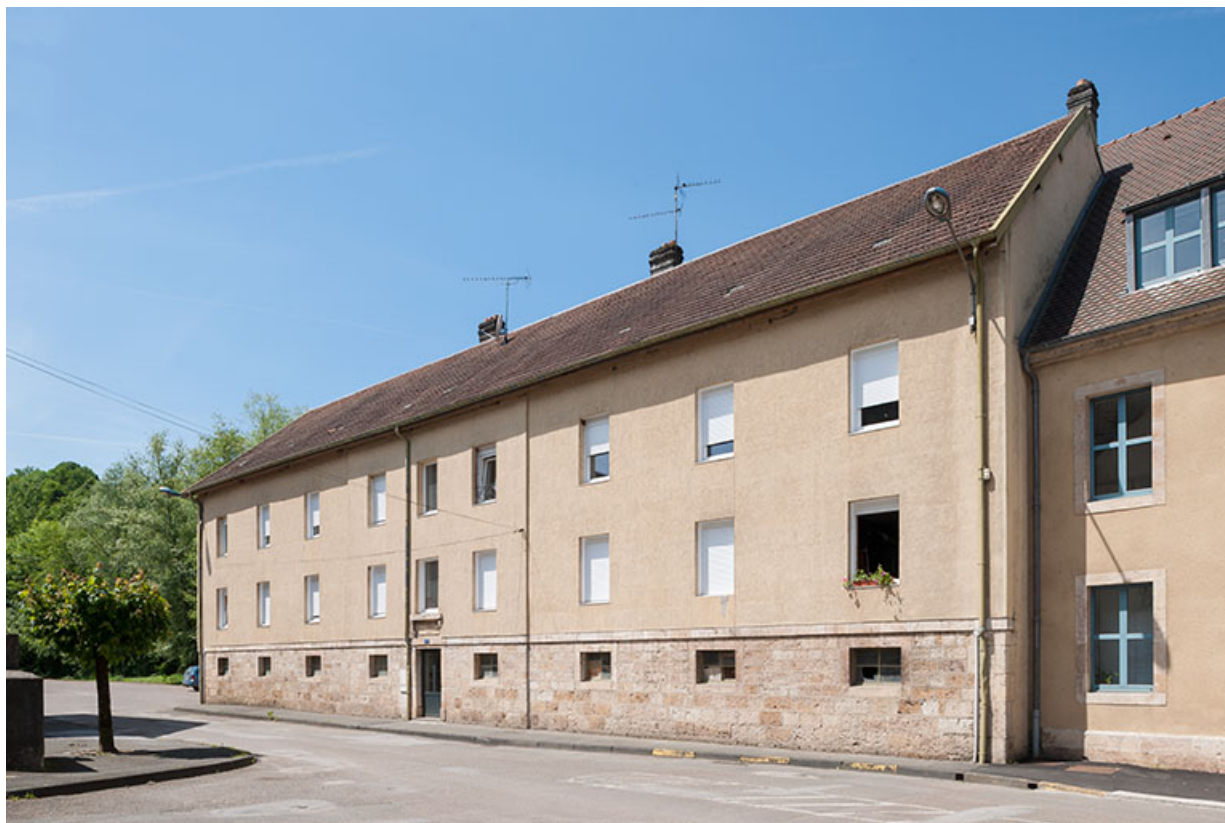
Logement occidental. Vue de trois quarts droite.
