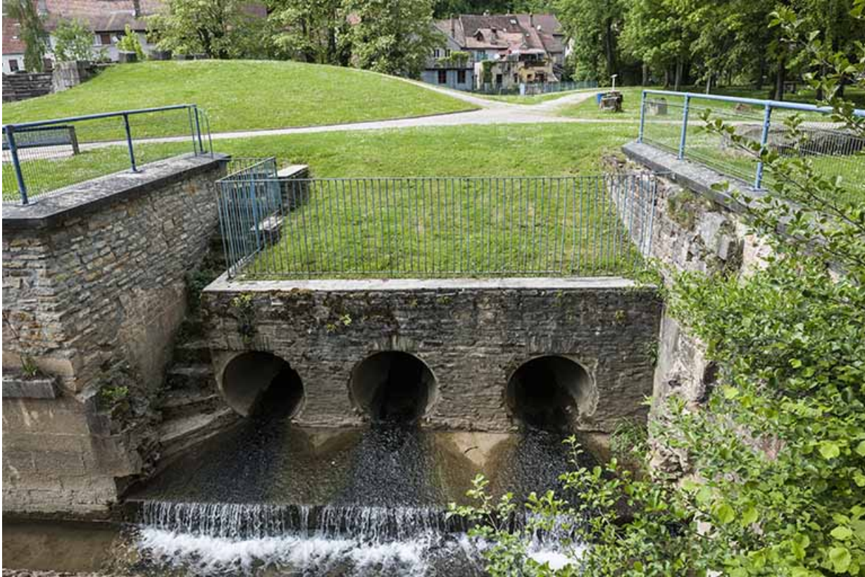
Vestiges des évacuations des turbines hydrauliques.
