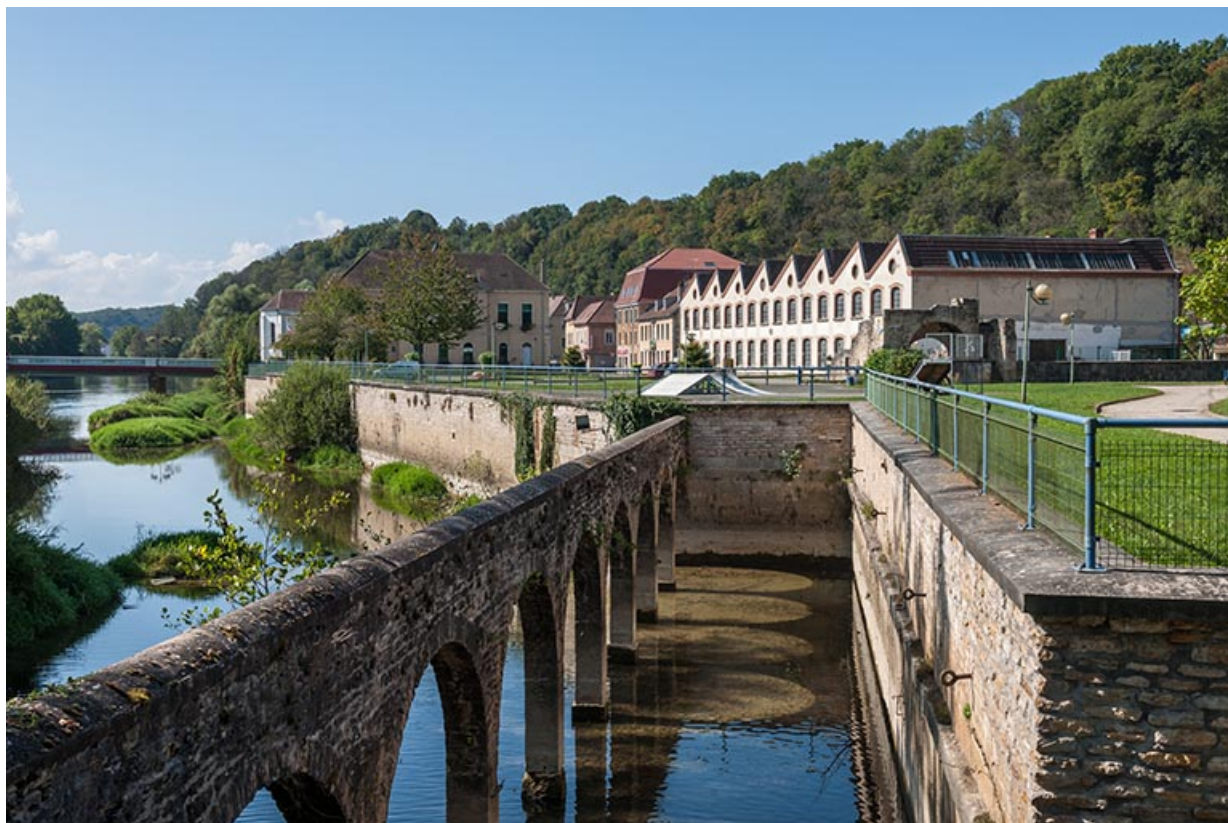
Vue d'ensemble depuis le nord du site.
