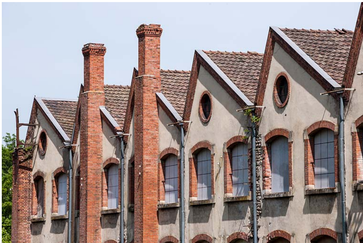
Détail des pignons de l'atelier de fabrication.
