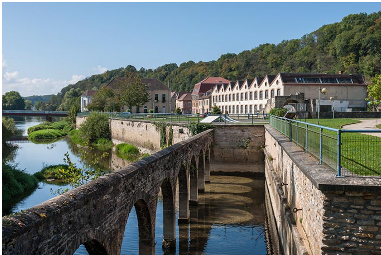
Vue d'ensemble depuis le nord du site.
