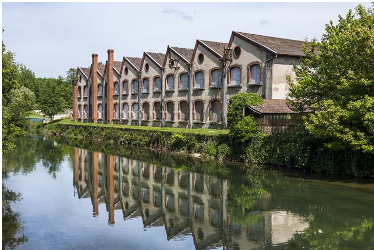
Façade ouest de l'atelier de fabrication.
