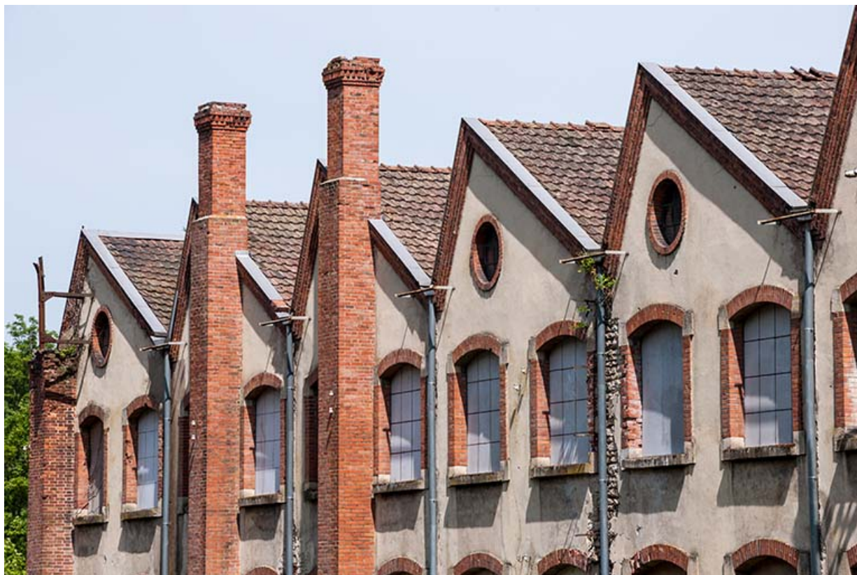
Détail des pignons de l'atelier de fabrication.
