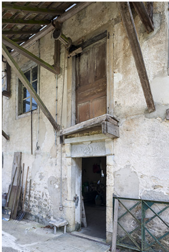
Mur-pignon ouest vu de trois quarts.
