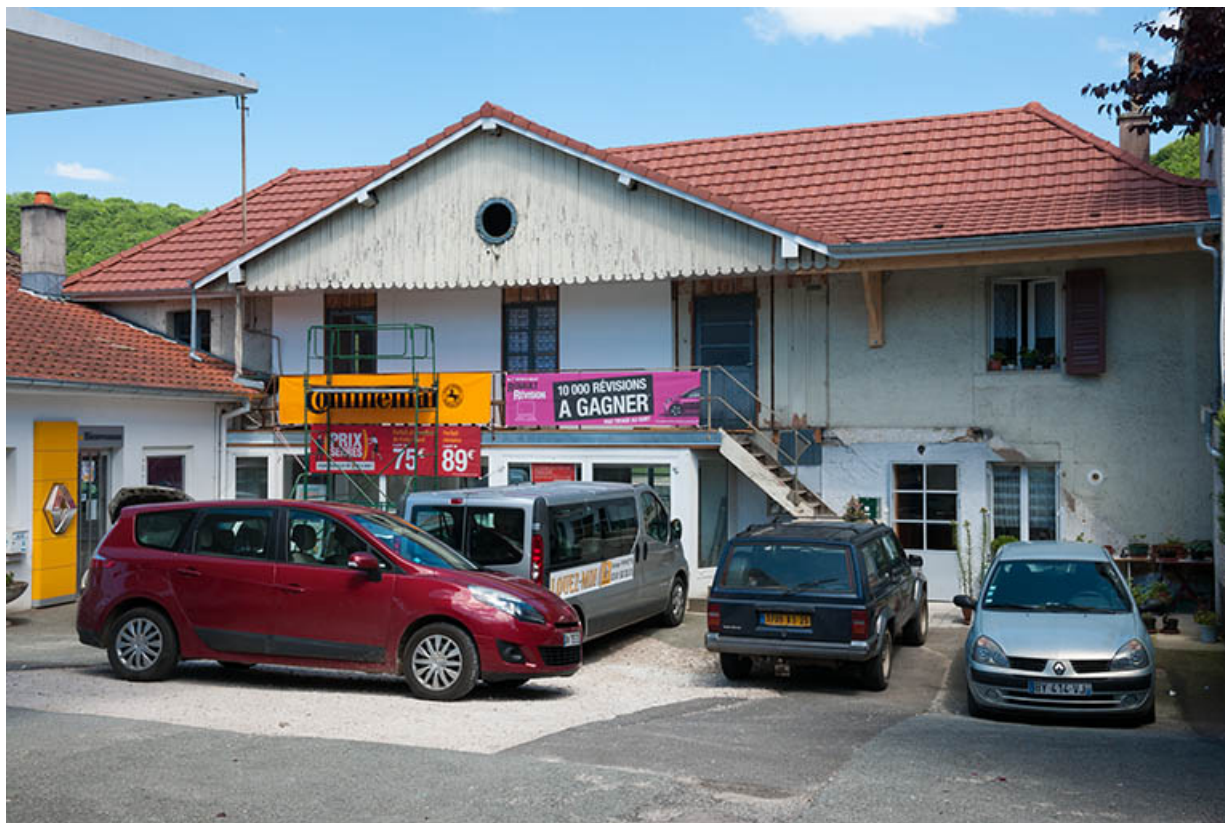
Façade ouest (ancien atelier de menuiserie). 25, Pont-de-Roide, 23 rue de Montbéliard
