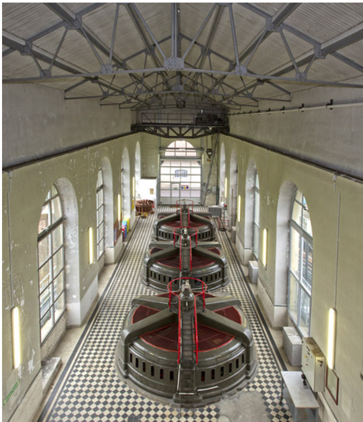
Salle des machines. Alignement des groupes turbo-alternateurs.
