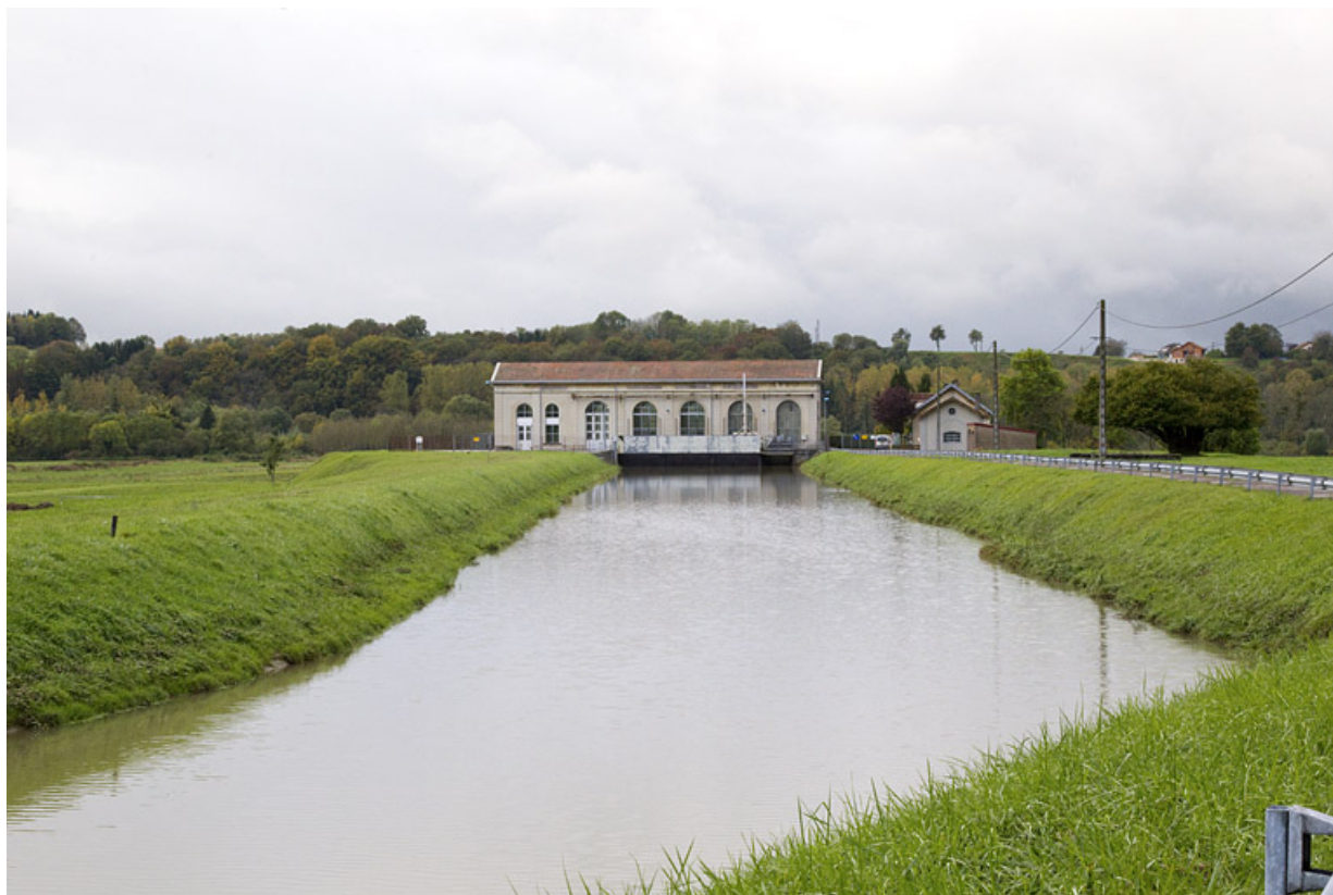
La centrale depuis le bief d'amenée.
