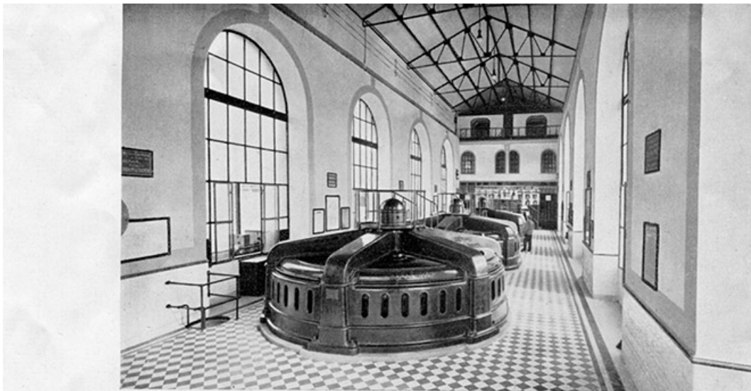
USINE DU CHATELOT : Salle des machines comprenant 3 groupes turbines et alternateurs de 1.000 CV chacun et 1 condensateur synchrone de 625 KVA.
