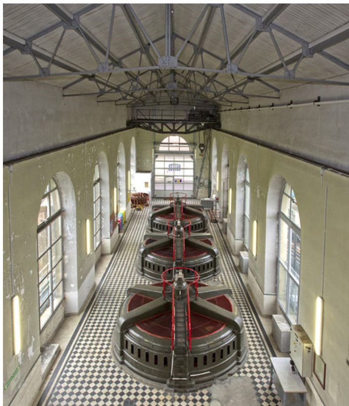
Salle des machines. Alignement des groupes turbo-alternateurs.
